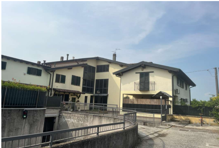
1 - fronte lato ingresso
