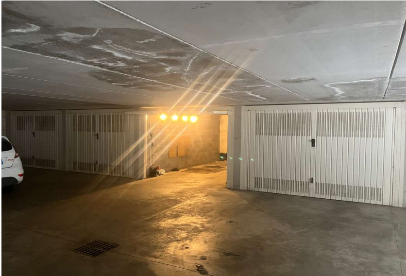
11 - corsello e vano autorimessa
