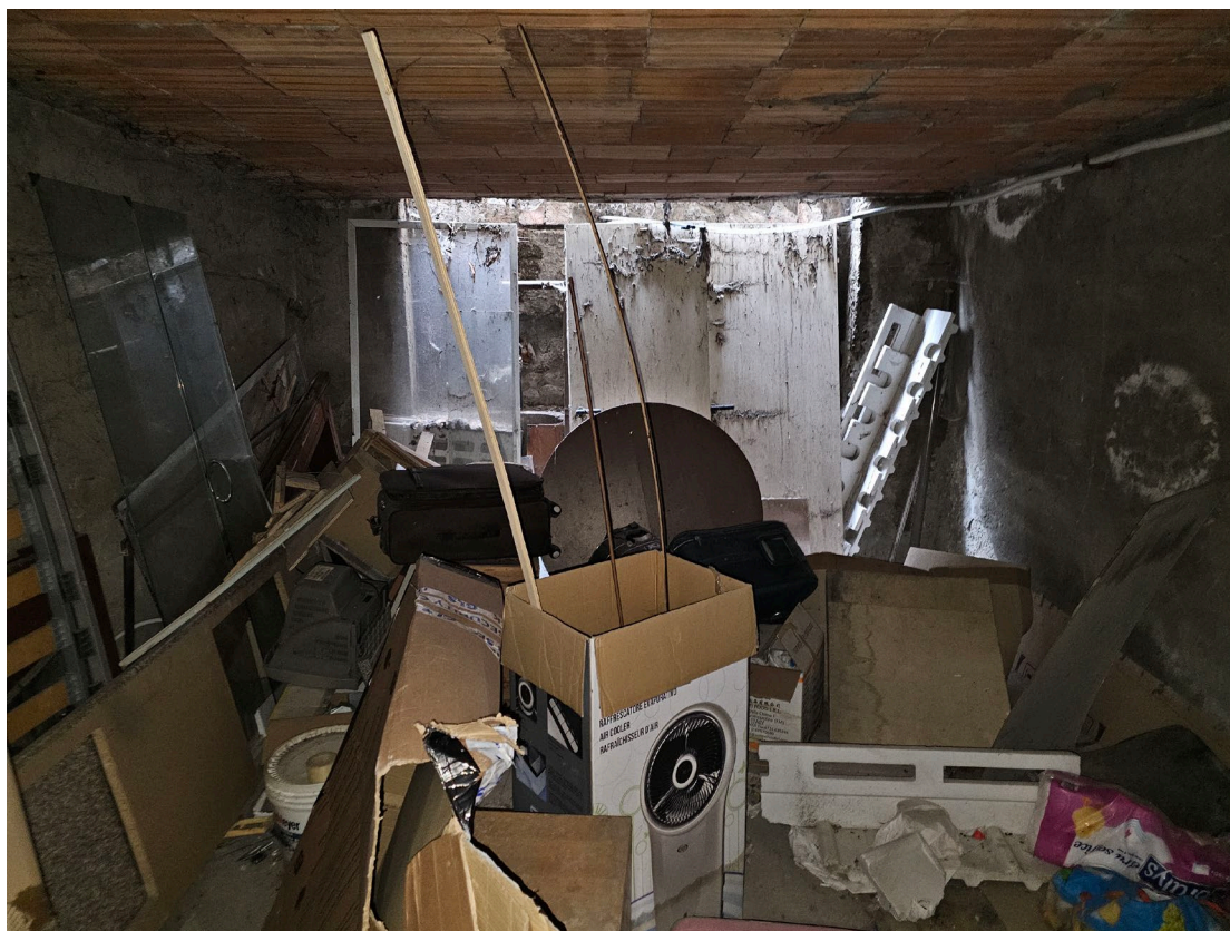
Interno 13: p.interrato – Cantina
