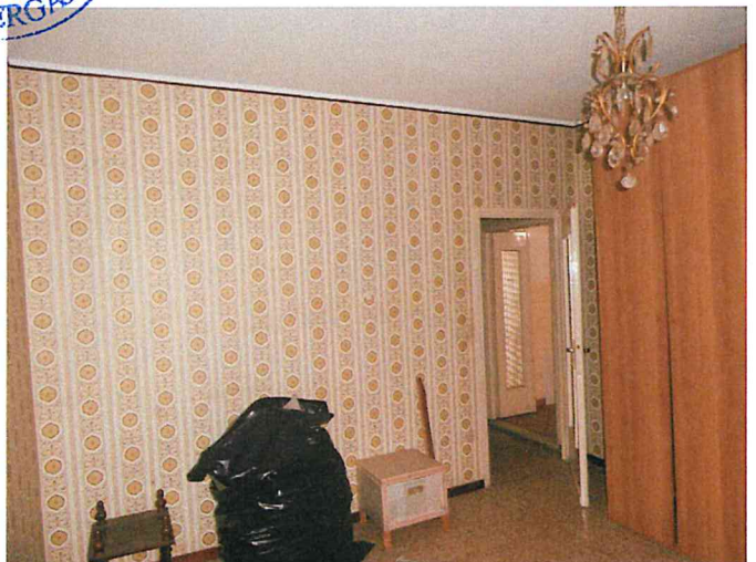
Foto 18 - Corpo A - interno - camera Nord
