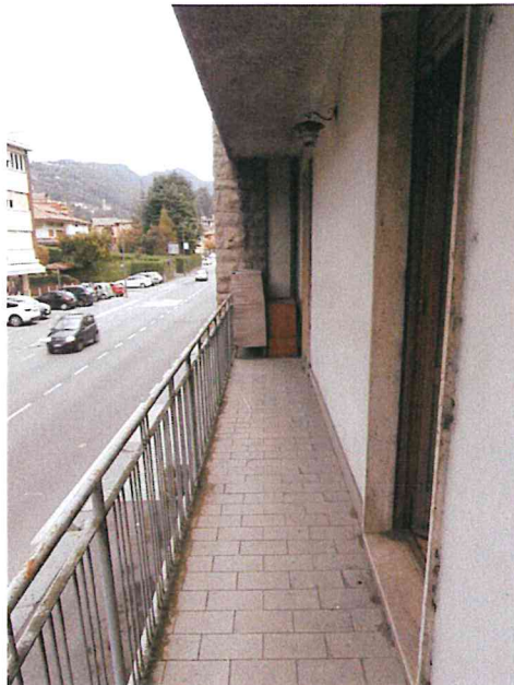
Foto 05 - Corpo A - balcone Nord
