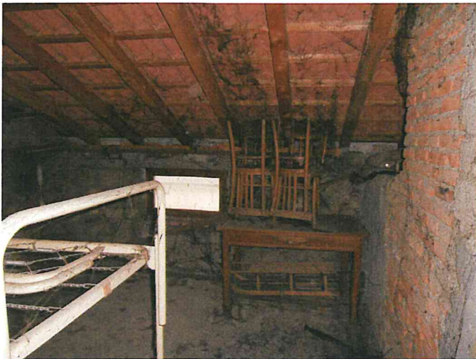
Foto 27 - Corpo C - interno - sottotetto porzione Est
