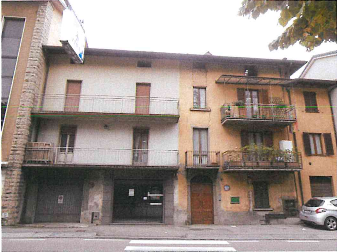
Foto 01 - Vista edificio prospetto Nord
