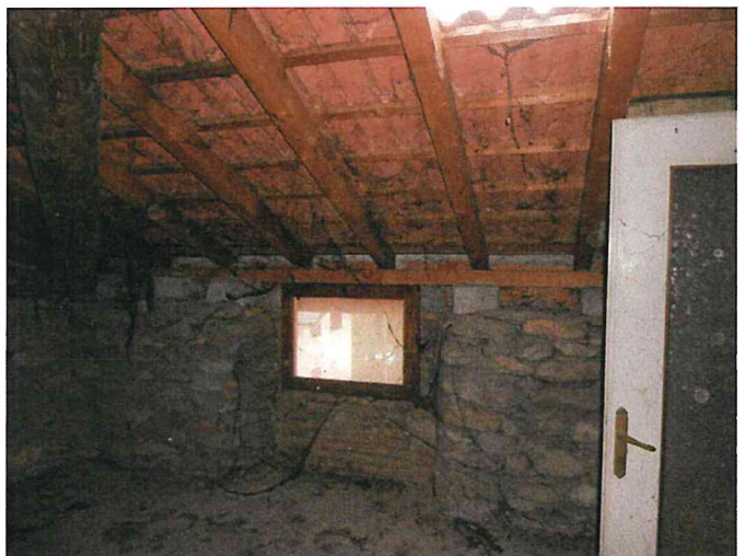
Foto 24 - Corpo C - interno sottotetto porzione Ovest
