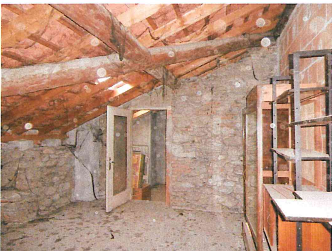
Foto 23 - Corpo C - interno - sottotetto porzione Ovest
