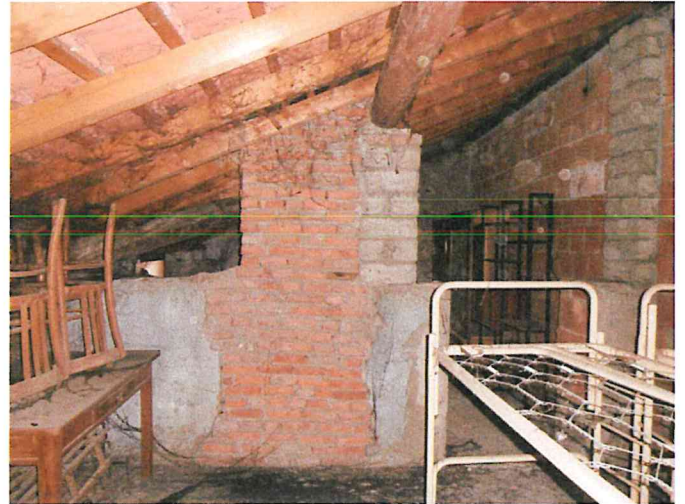
Foto 26 - Corpo C - interno - sottotetto porzione Est
