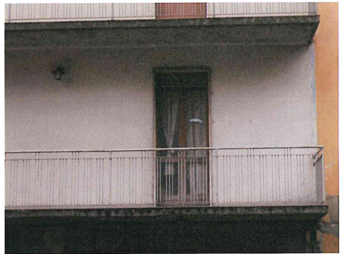
Foto 04 - Corpo A - prospetto Nord
