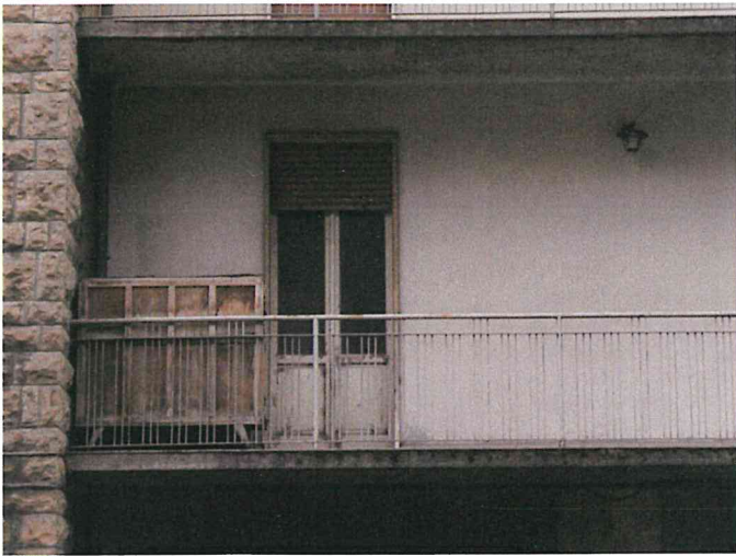
Foto 03 - Corpo A - prospetto Nord
