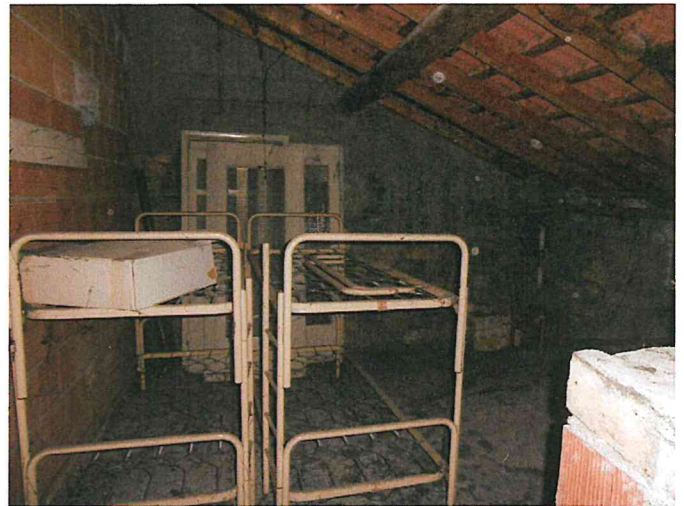
Foto 28 - Corpo C - interno - sottotetto porzione Est
