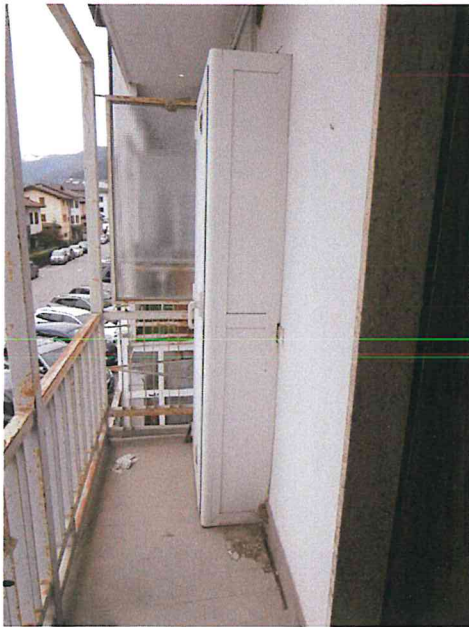
Foto 07 - Corpo A - Balcone Sud
