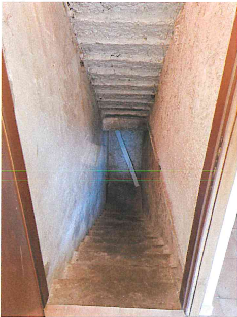
Foto 13 - Corpo B - scale condominiali piano interrato
