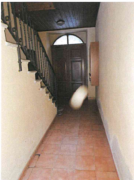
Foto 11 - Corpi A-B-C - ingresso condominiale
