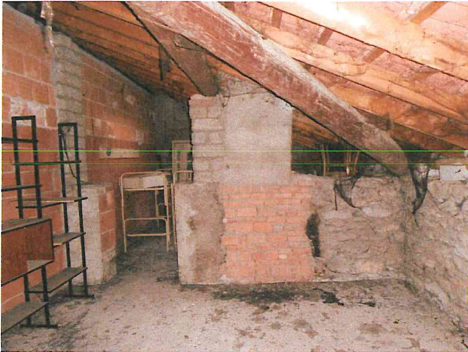
Foto 25 - Corpo C - interno - sottotetto porzione Ovest
