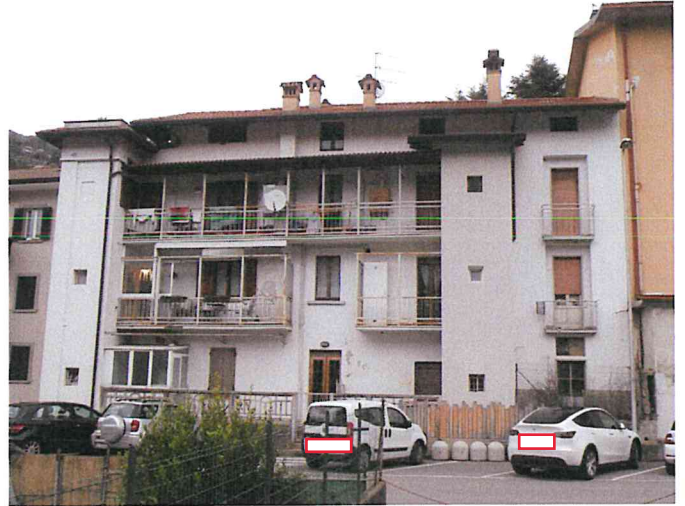
Foto 02 - Vista edificio prospetto Sud
