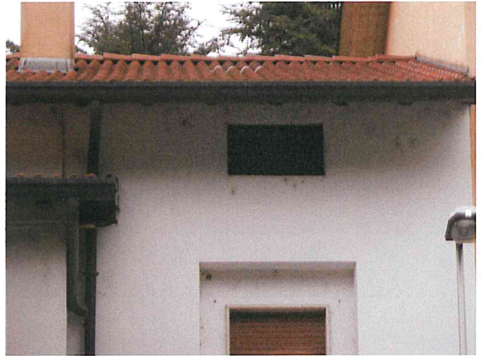
Foto 10 - Corpo C - Prospetto Sud
