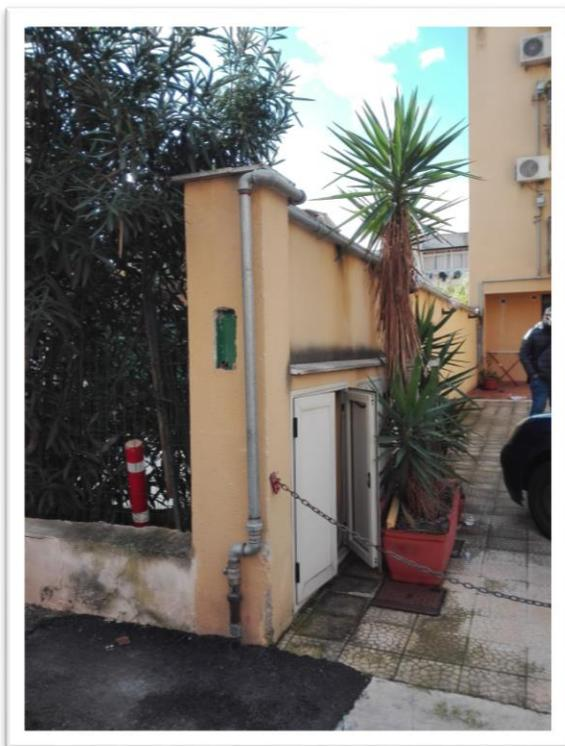
Foto 6 particolare predisposizione citofoni esterno, armadio contatori enel
