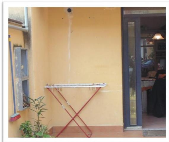
armadi esterni dove sono alloggiati i contatori elettrici    alloggiamento (vuoto) contatore gas e predisposizione climatizzatore
