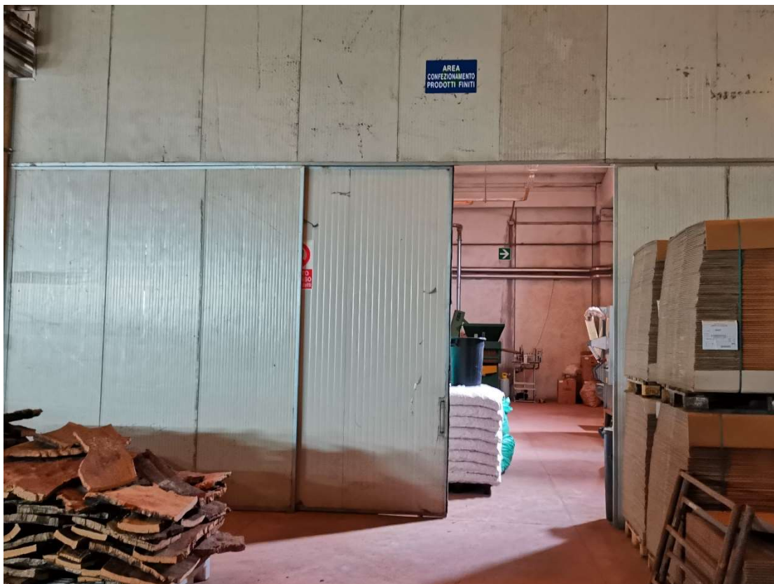
FOTO 030 – PIANO TERRA, SALA LAVORAZIONE 2
