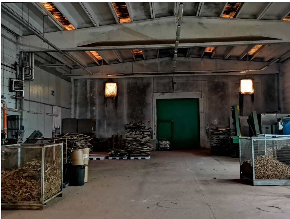
FOTO 028 – PIANO TERRA, SALA LAVORAZIONE 2
