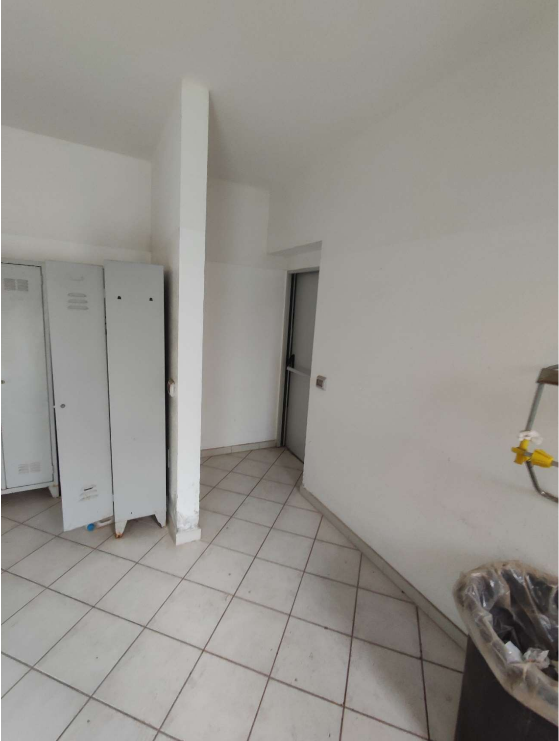
FOTO 018 – PIANO TERRA, SPOGLIATOIO UOMINI
