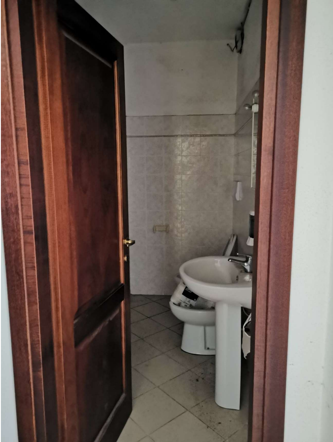
FOTO 011 – PIANO TERRA, BAGNO
