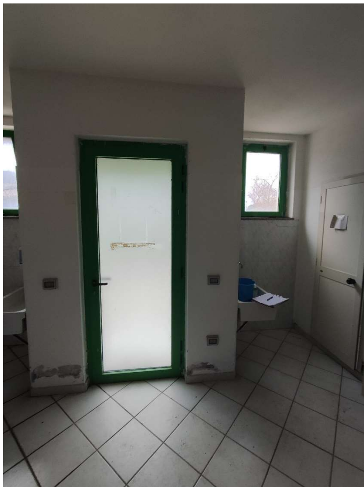
FOTO 017 – PIANO TERRA, SPOGLIATOIO UOMINI
