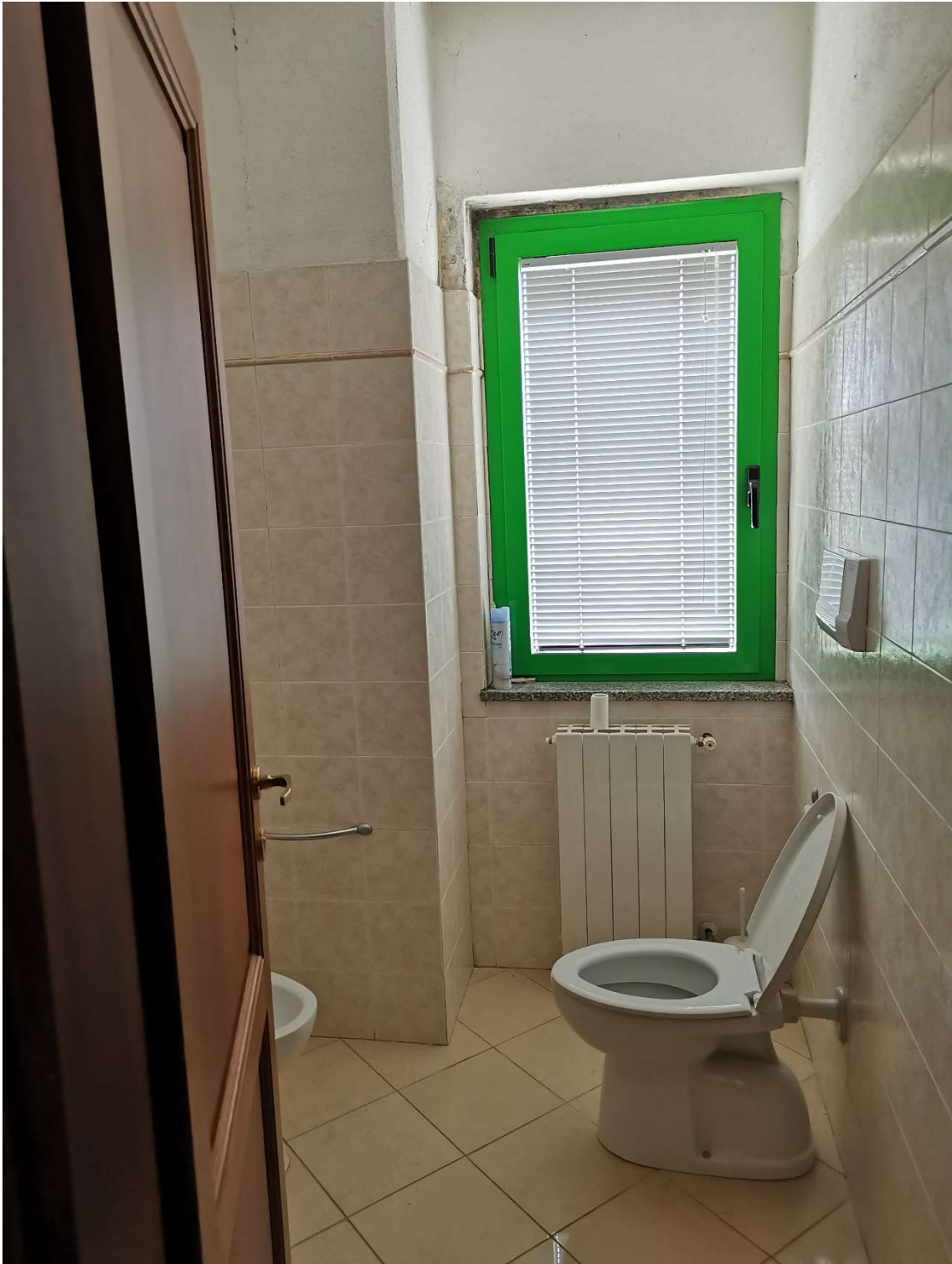
FOTO 042 – PIANO PRIMO, BAGNO
