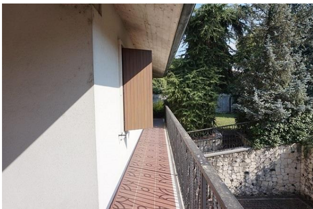
Piano terra fronte sud
