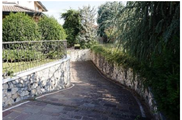
Rampa accesso carraio piano interrato da ovest
