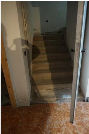
Piano interrato – Scala interna da disimpegno
