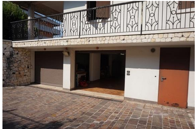
Ingressi autorimesse da corsia manovra a sud
