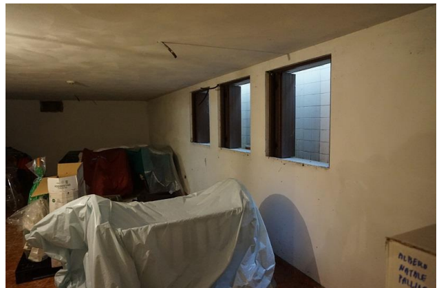
Piano interrato – Angolo nord/est taverna
