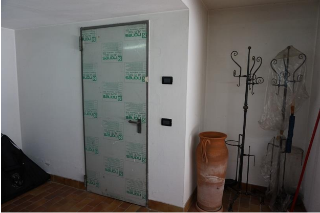
Piano interrato – Ingresso disimpegno da autorimessa
