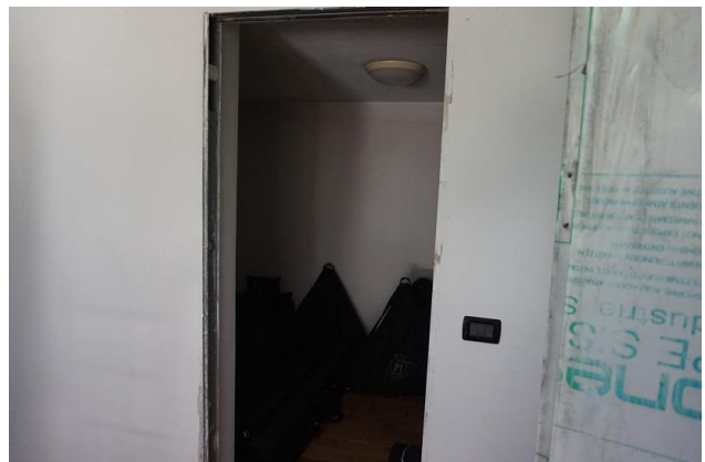
Piano interrato – Cantina da autorimessa
