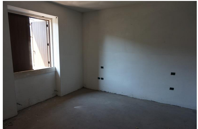
Piano primo – Camera a nord/ovest
