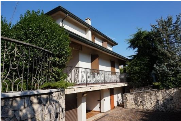
Fronte sud da rampa accesso carraio
