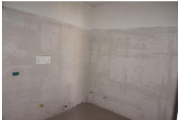
Piano primo – Bagno camera nord/est
