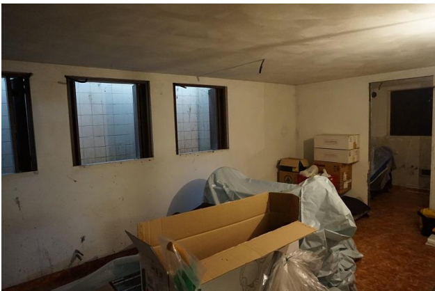
Piano interrato – Angolo sud/est taverna
