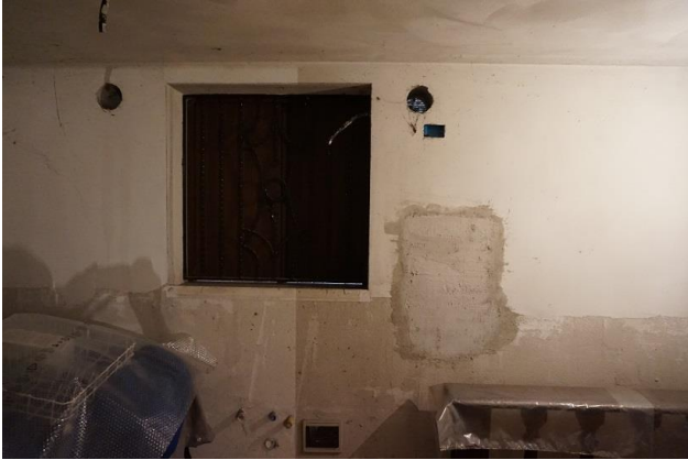
Piano interrato – Parete est taverna
