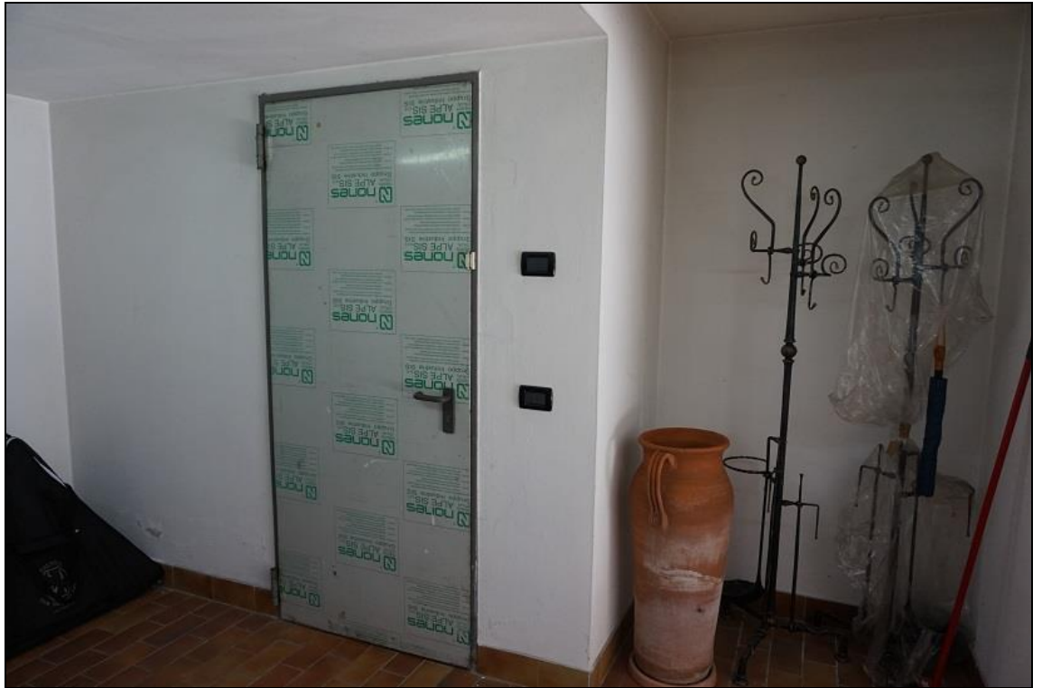
FOTO 15 – Piano interrato – Ingresso disimpegno da autorimessa
