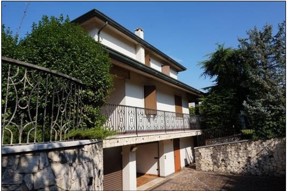
FOTO 7 – Fronte sud da rampa accesso carraio
