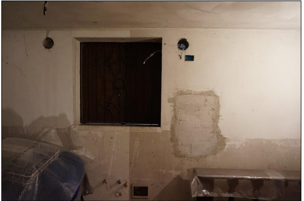
FOTO 23 – Piano interrato – Parete est taverna
