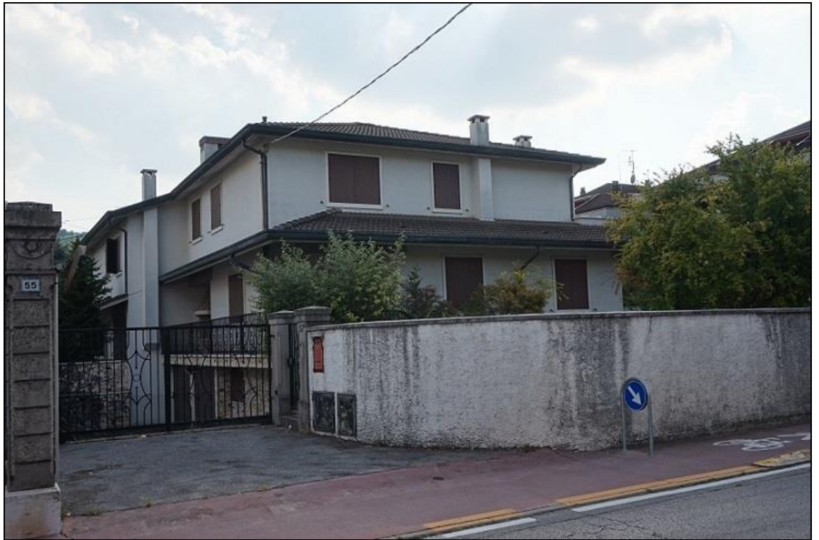
FOTO 1 – Vista da nord/est
