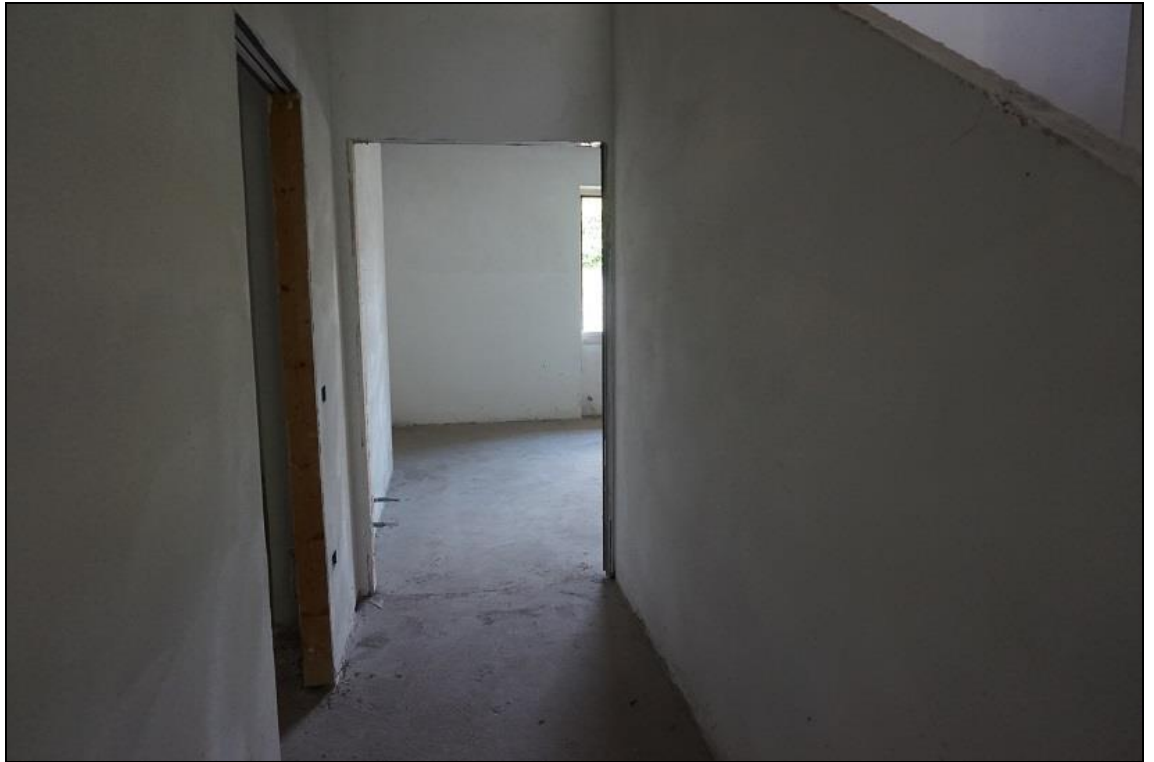
FOTO 29 – Piano terra – Corridoio da ovest verso est
