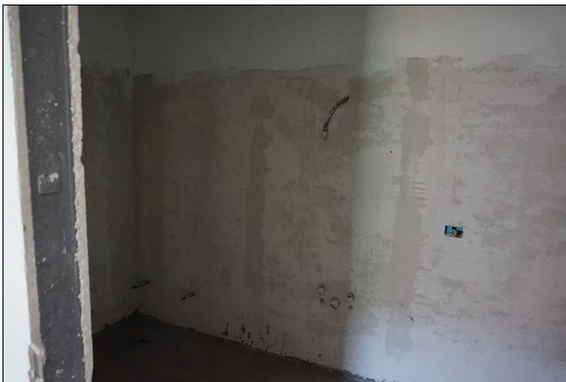
FOTO 37 – Piano primo – Bagno camera a nord/ovest
