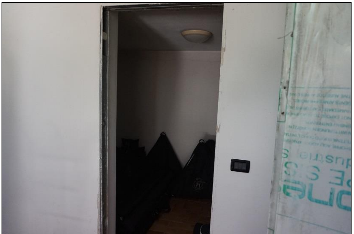
FOTO 14 – Piano interrato – Cantina da autorimessa
