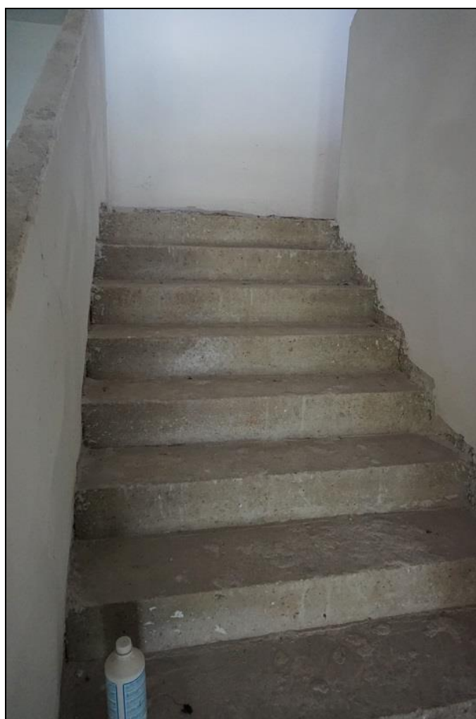
FOTO 32 – Piano terra – Scala interna
