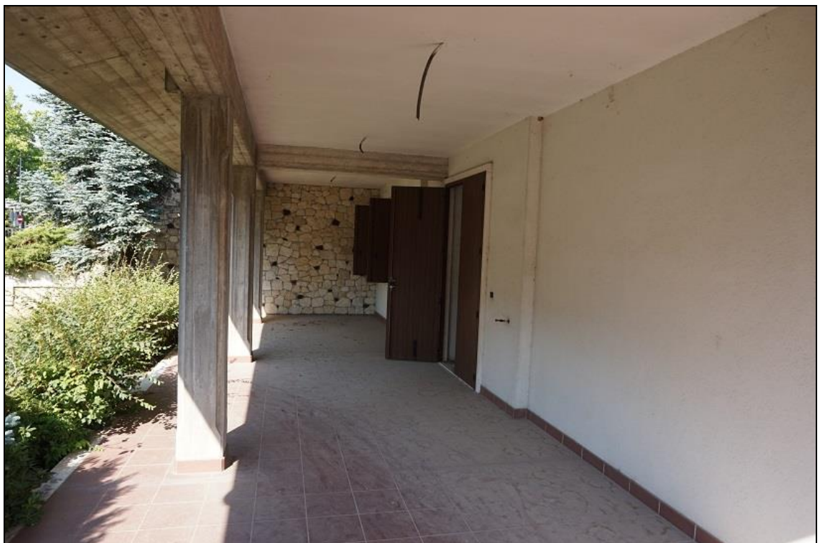
FOTO 12 – Portico ad ovest da sud verso nord
