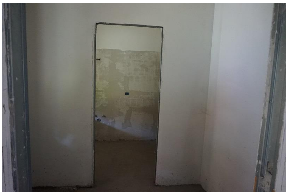
FOTO 31 – Piano terra – Anti bagno e bagno
