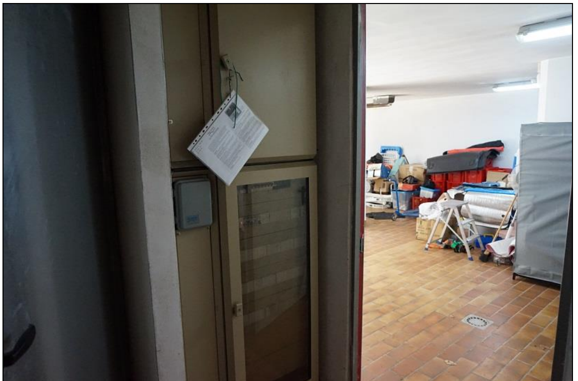
FOTO 46 – Piano interrato – Autorimesse da disimpegno abitazione
