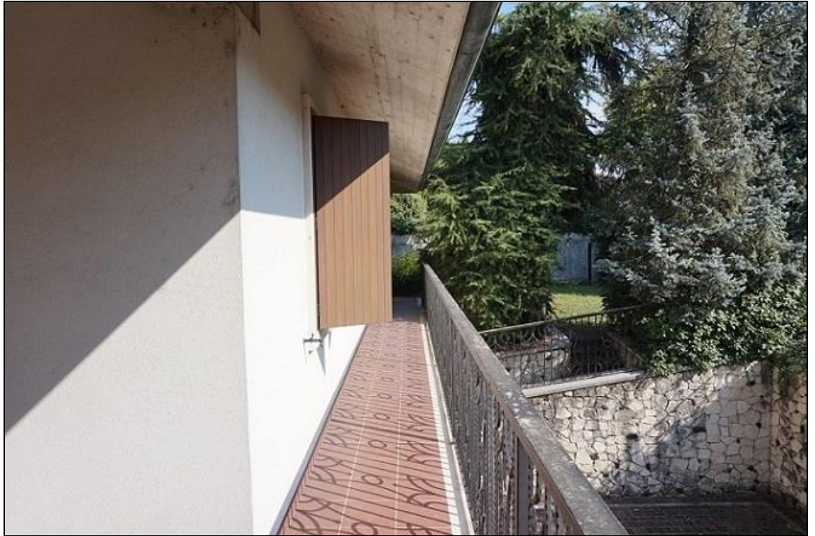
FOTO 11 – Piano terra fronte sud
