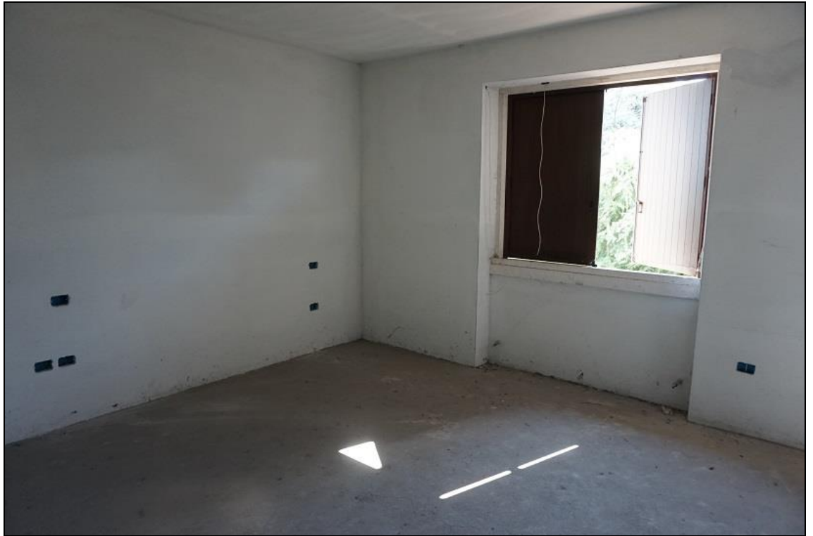
FOTO 41 – Piano primo – Camera a sud
