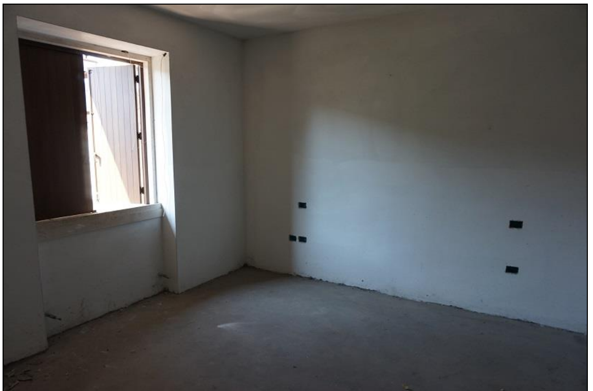
FOTO 36 – Piano primo – Camera a nord/ovest
