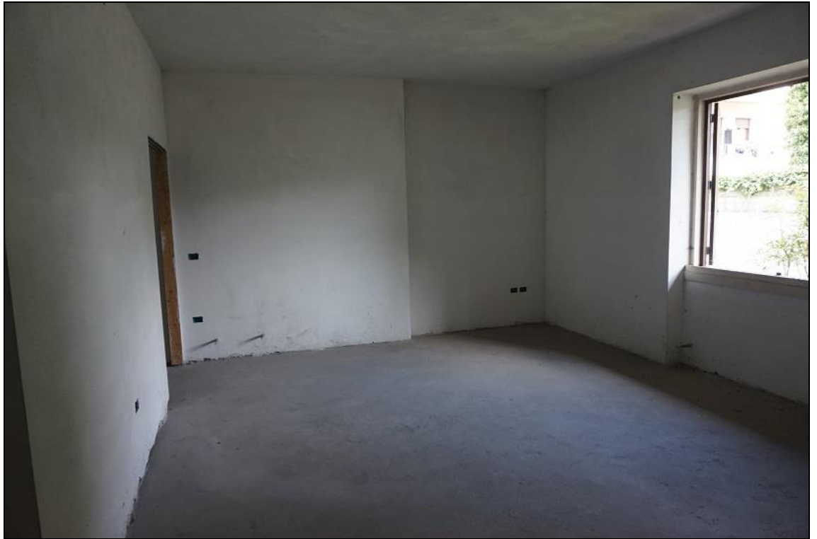
FOTO 27 – Piano terra – Angolo nord/est soggiorno
