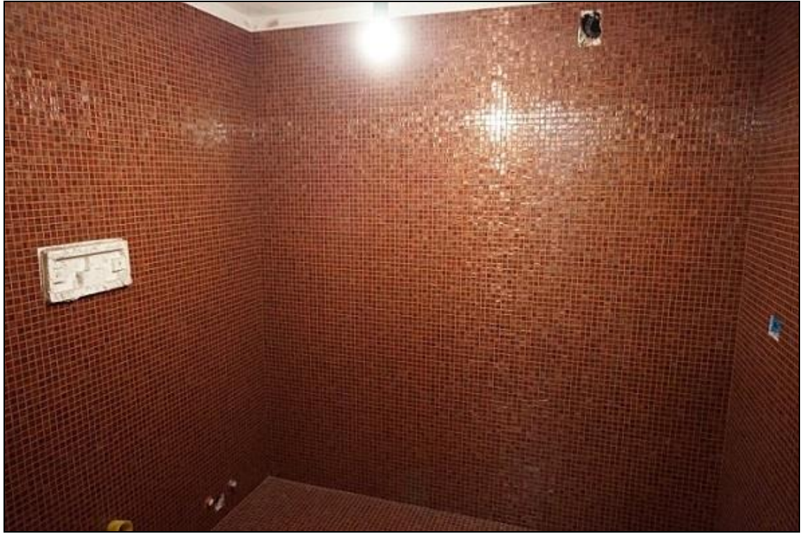
FOTO 17 – Piano interrato – Bagno
