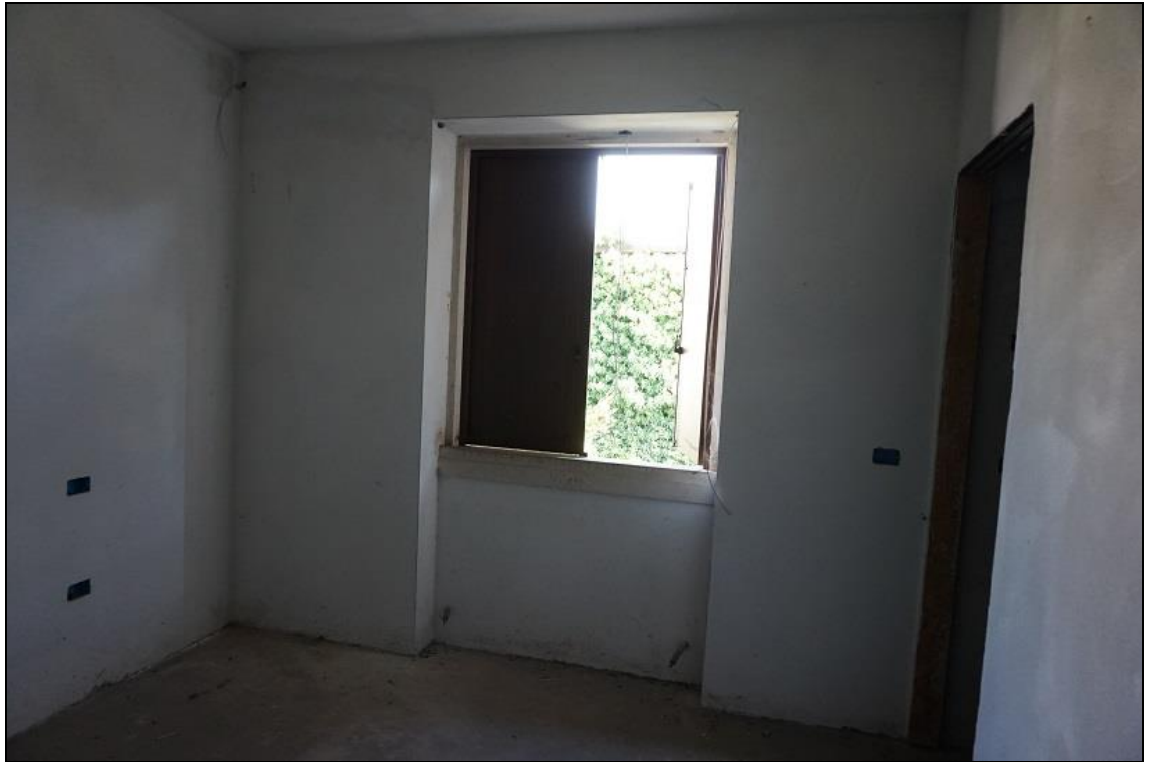
FOTO 39 – Piano primo – Camera a nord/est
