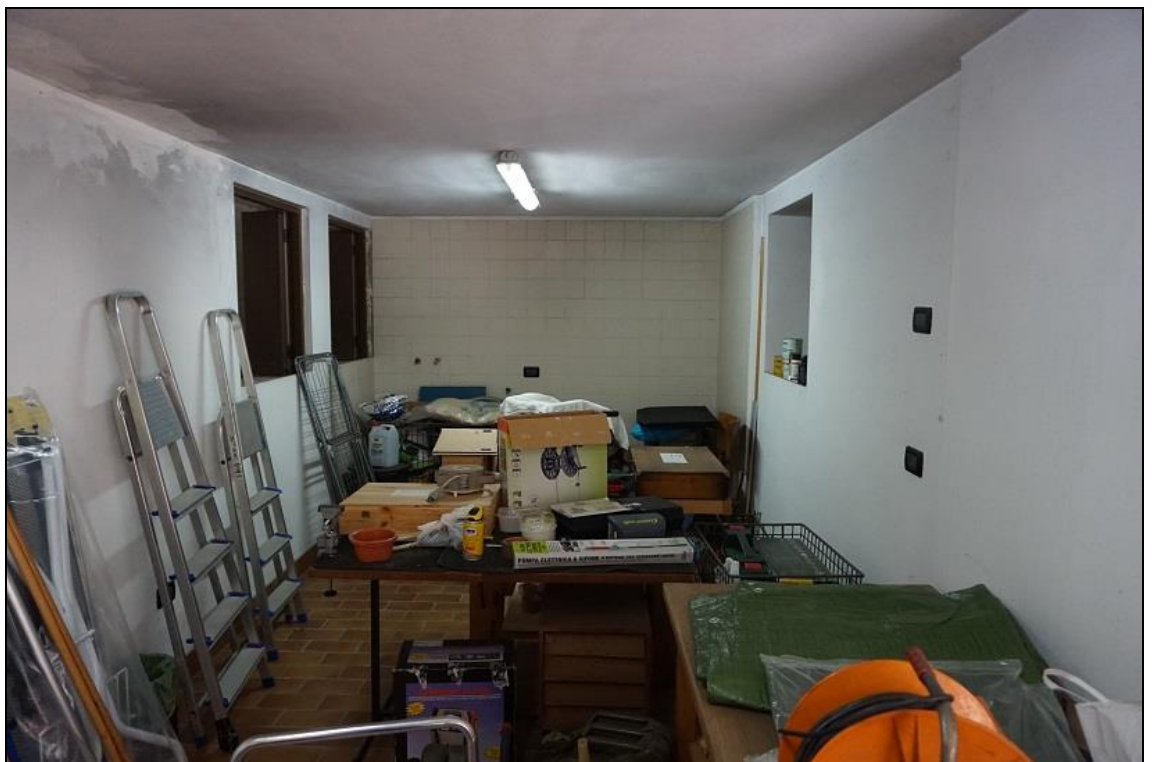
FOTO 44 – Piano interrato – Autorimessa (Part.1551 sub.8) da sud
