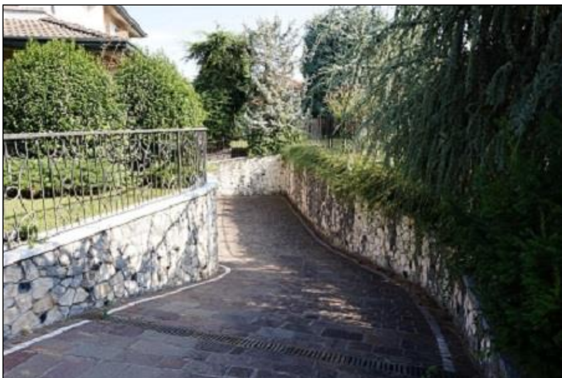
FOTO 6 – Rampa accesso carraio piano interrato da ovest
