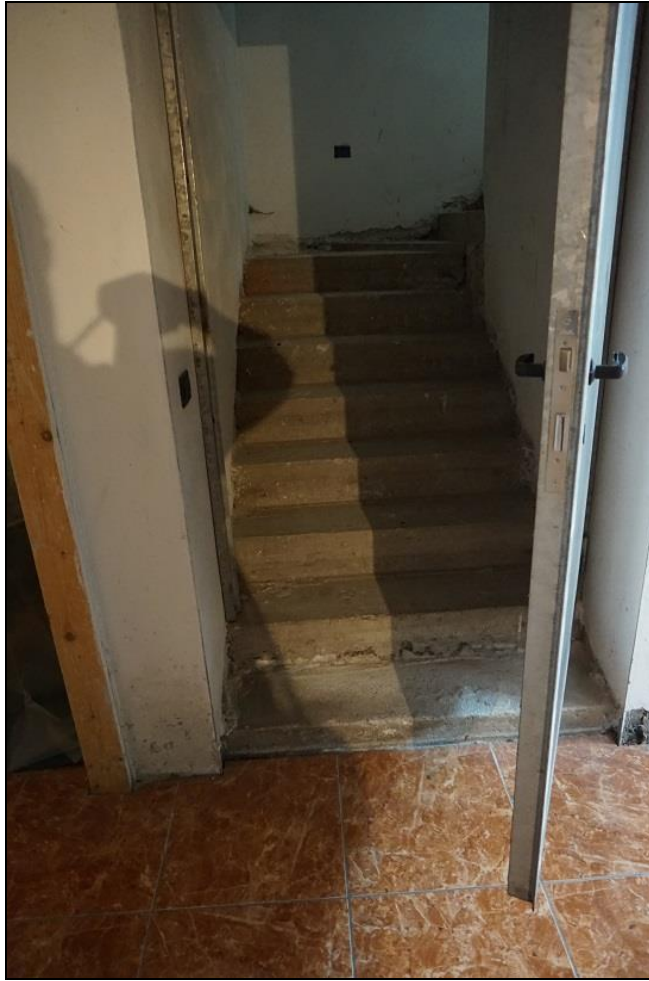
FOTO 19 – Piano interrato – Scala interna da disimpegno
