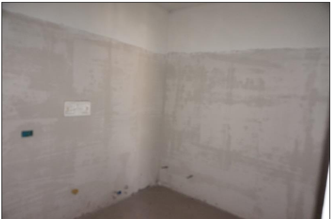
FOTO 40 – Piano primo – Bagno camera nord/est
