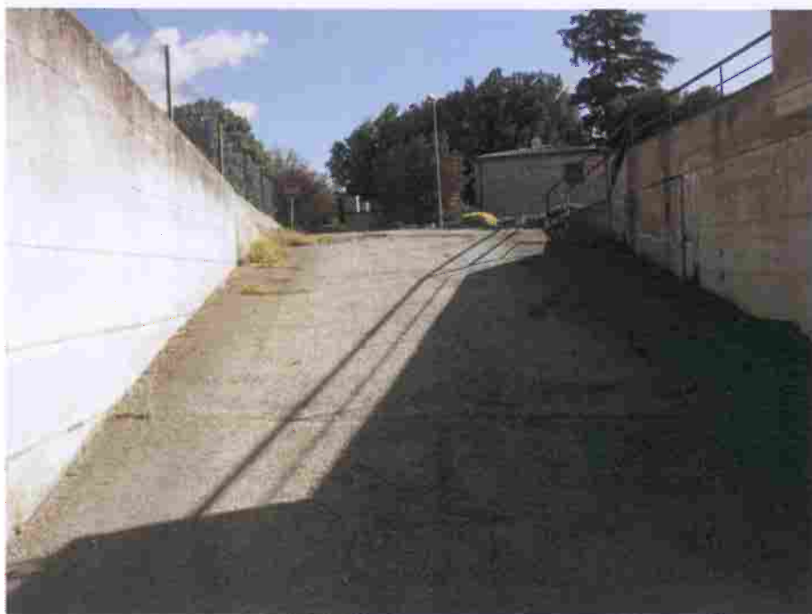
Foto n° 36 – Rampa di accesso alle autorimesse del civ. n. 37.
