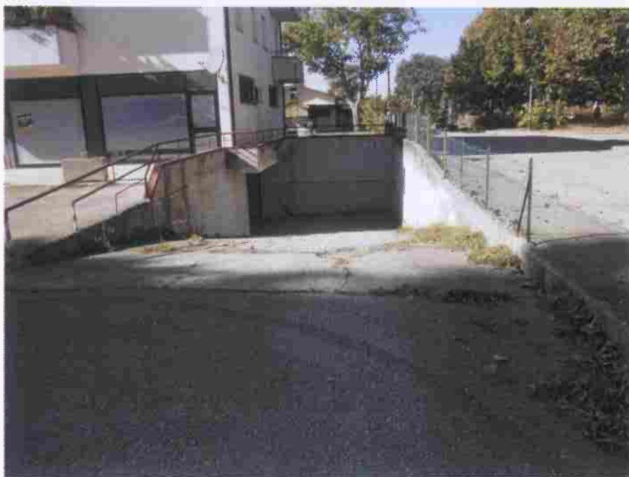
Foto n° 35 – Rampa di accesso alle autorimesse del civ. n. 37.
