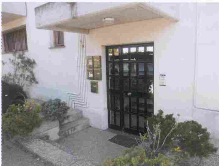
Foto n° 11 – Portone esterno d'ingresso del civ. n. 37.
