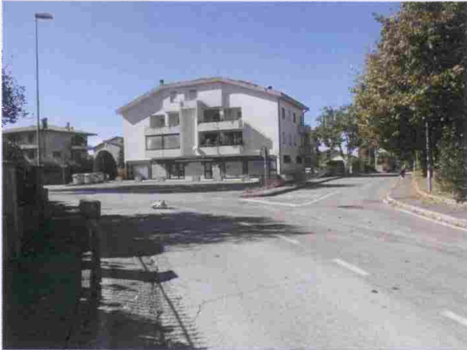
Foto n° 1 – Vista, dalla Via Eugenio Montale, dei beni esecutati.
