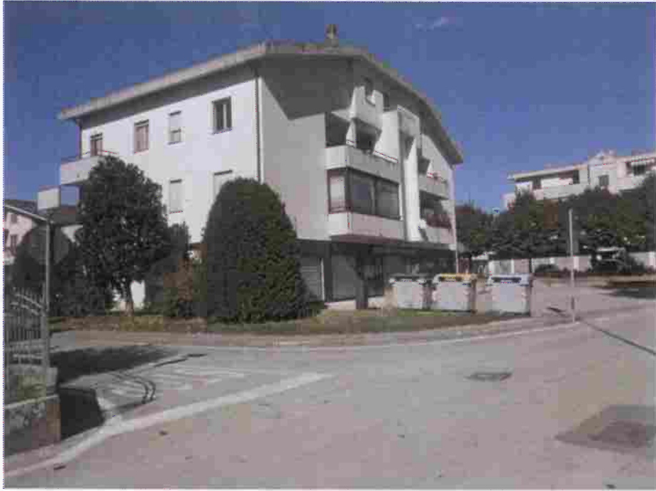
Foto n° 7 – Vista, dalla Via Eugenio Montale, dei beni esegutati.
