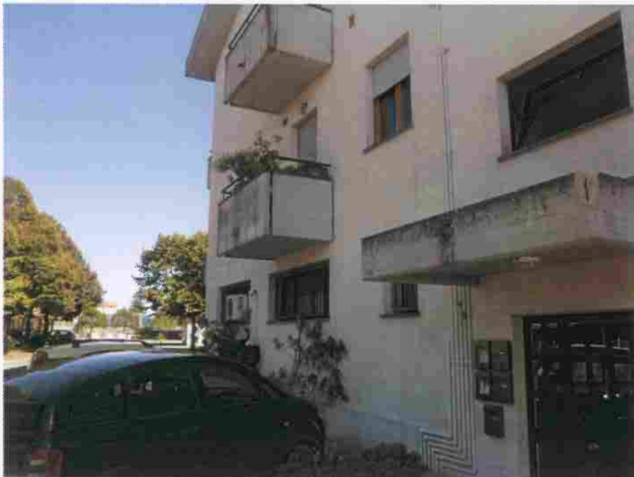
Foto n° 10 – Vista di una porzione del bene A1-abitazione.
