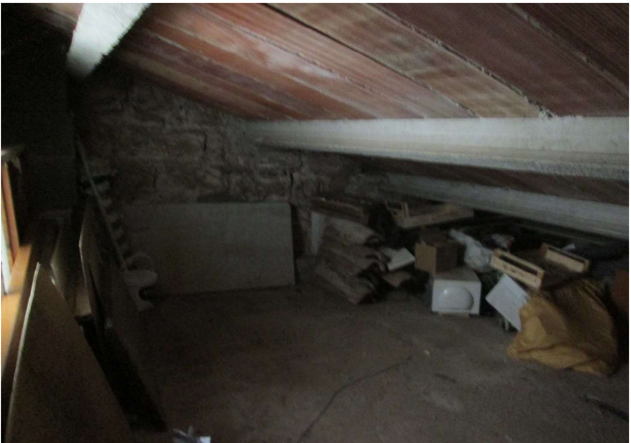
Foto 19- Locale grezzo al Piano secondo -sottotetto
