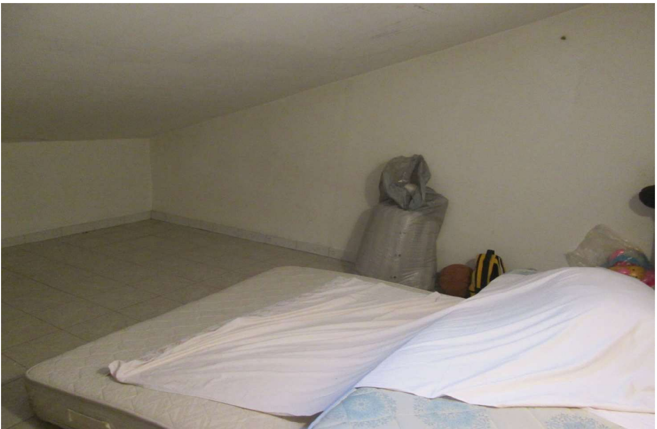
Foto 17- Vano finito al Piano secondo -sottotetto
