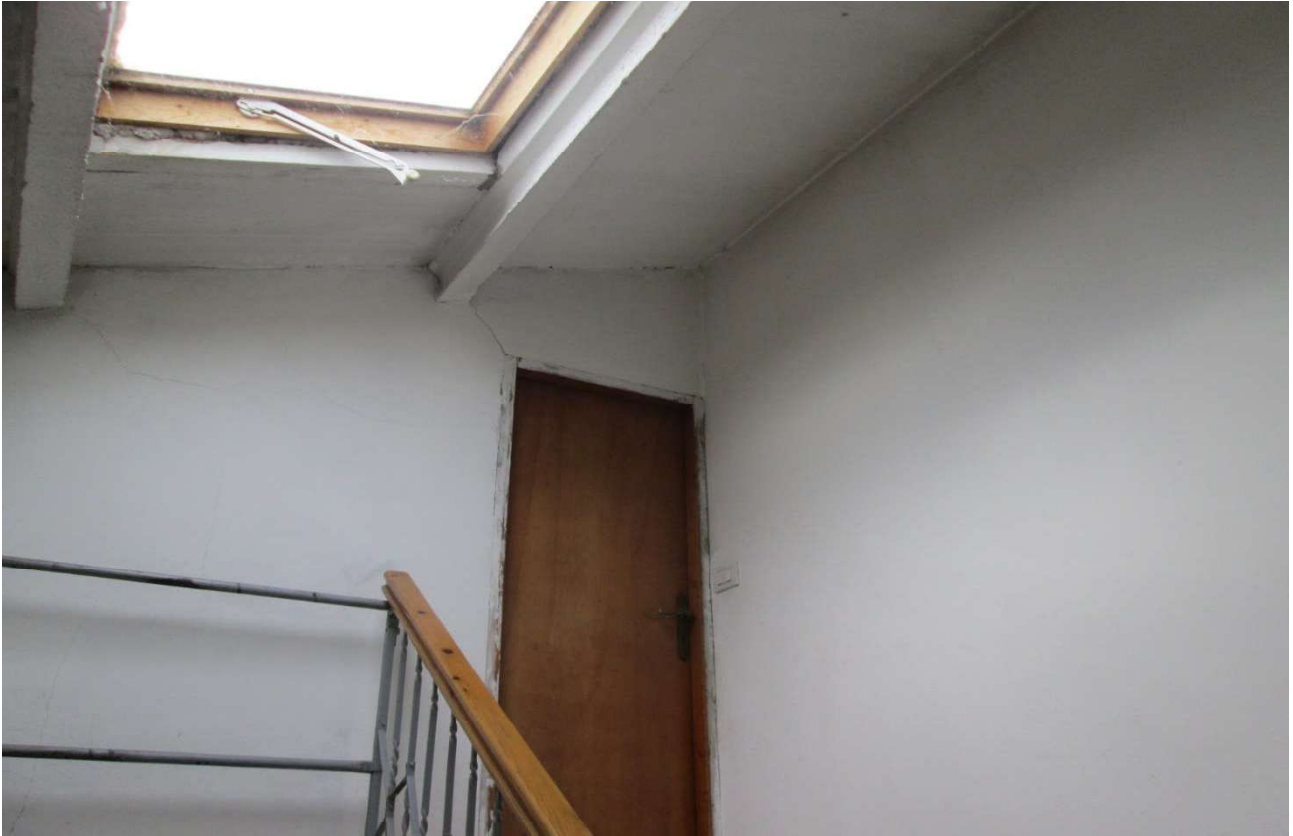
Foto 16- Porta d'ingresso al Piano secondo -sottotetto
