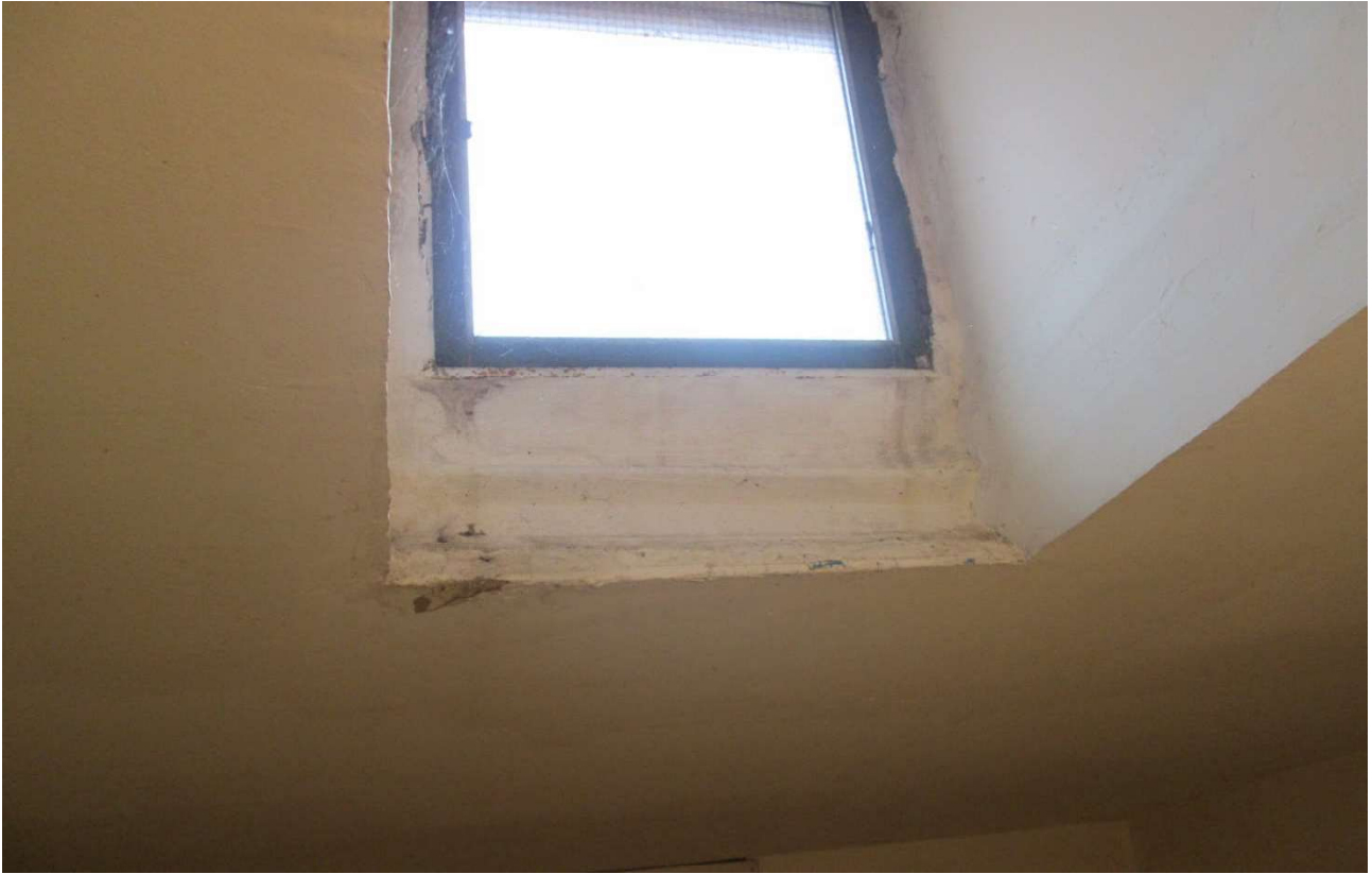
Foto 18- Abbaino nel vano finito al Piano secondo -sottotetto
