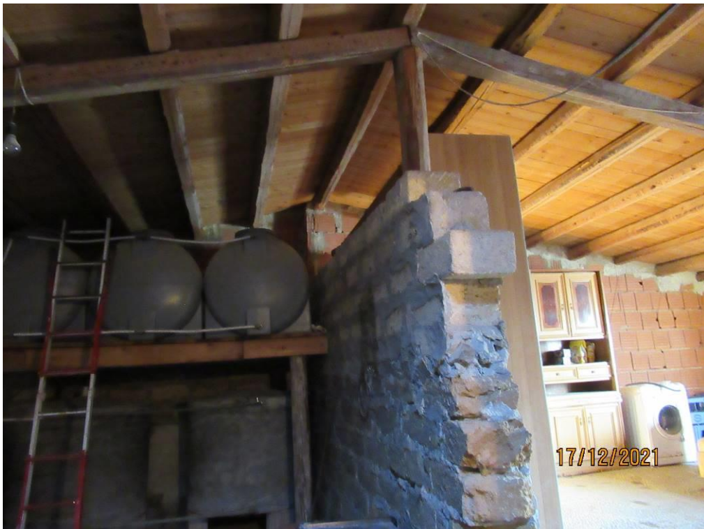
INTERNI scala seconda rampa e locali sottotetto piano terzo
