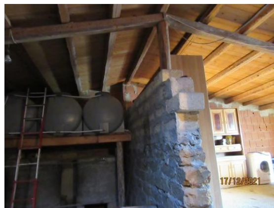
Locali sottotetto (3° piano)
