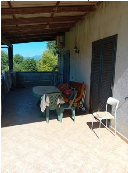
Figura 16 tettoia piano rialzato
