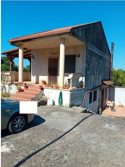
Figura 8 villetta distribuita tra piano rialzato e piano seminterrato
