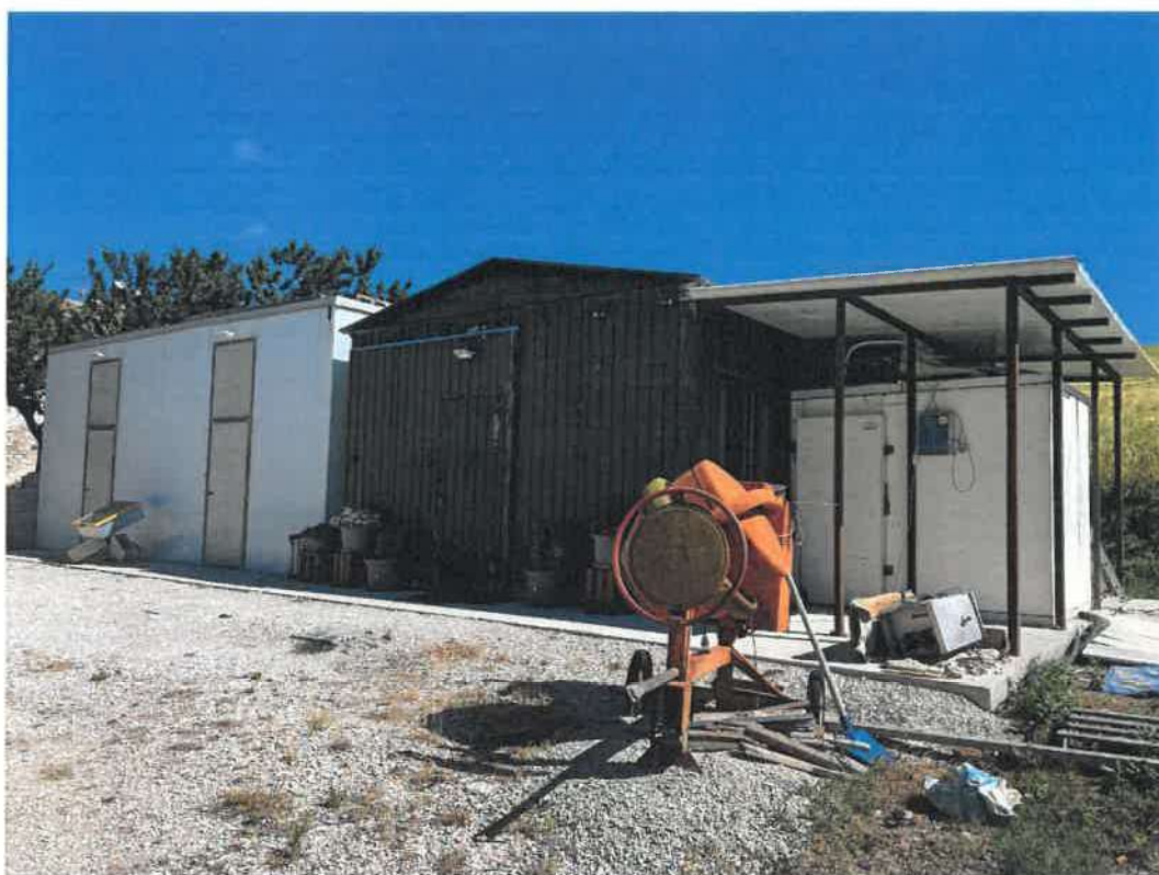
Foto 02 – fabbricati abusivi da demolire (f.134, mapp.190)
