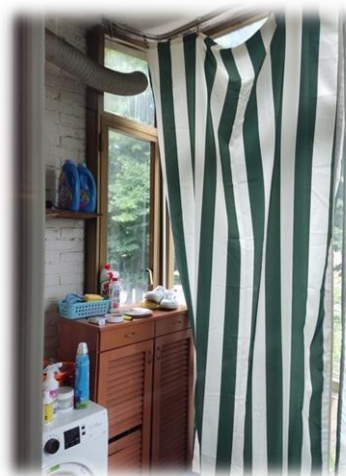
balcone verandato abusivamente
