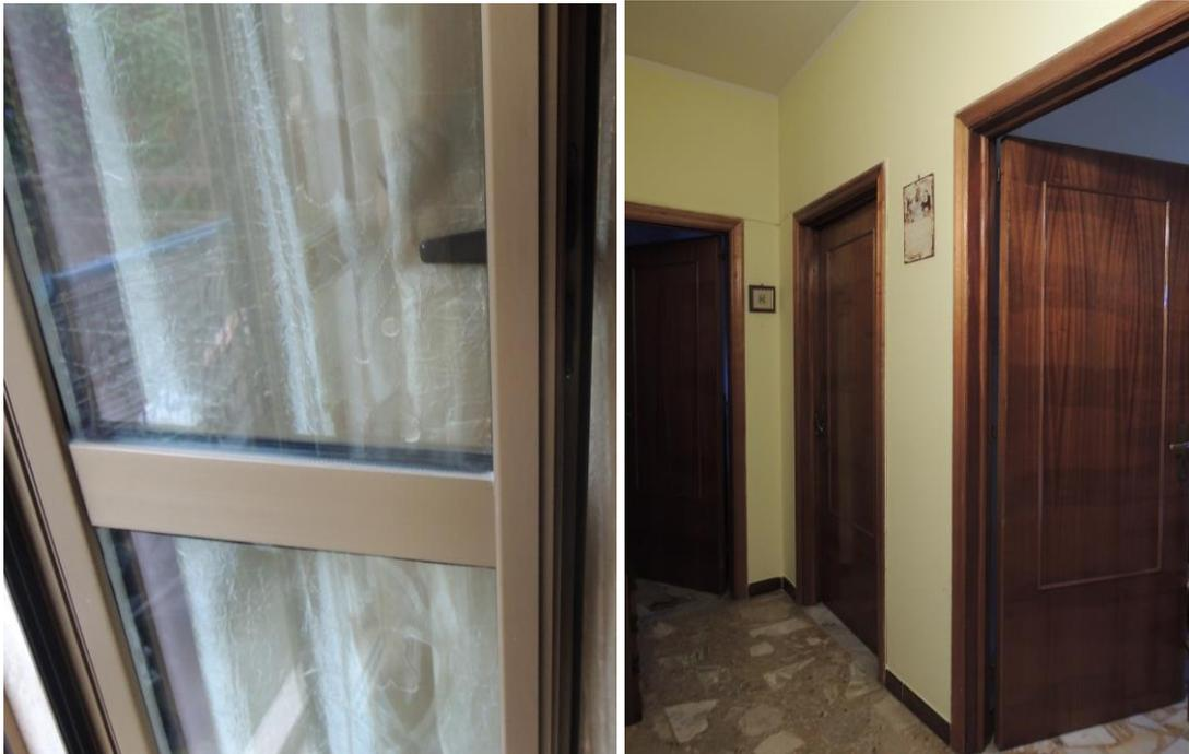
**Figura 7** Particolare infissi esteri in alluminio **Figura 8** Particolari infissi interni in legno tamburato
