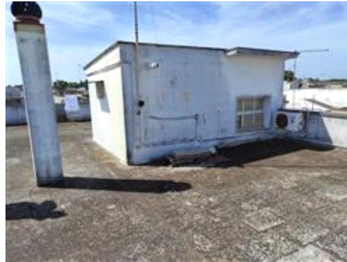
Vano tecnico lastrico solare
