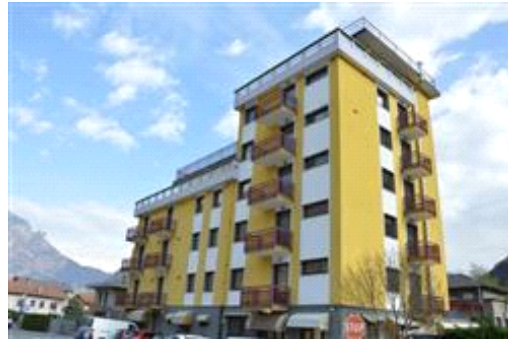
Fronti sud-est del fabbricato di cui fa parte il ristorante oggetto di esecuzione.
