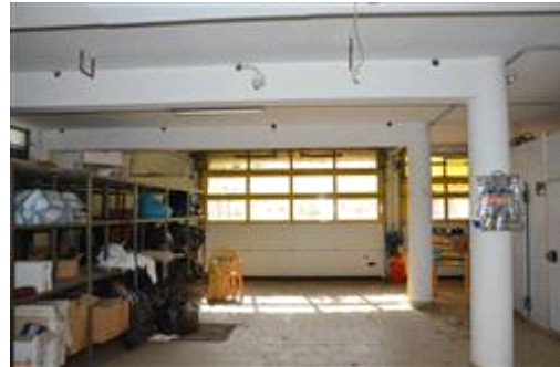
Locale adibito a deposito posto al piano seminterrato.
