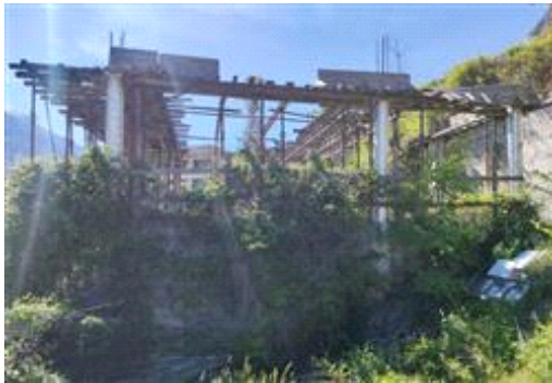
Struttura in c.a. del fabbricato realizzato solo parzialmente sul mappale 809 e mai ultimato.
