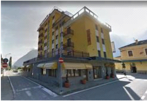
Fronti nord-ovest del fabbricato di cui fa parte il ristorante oggetto di esecuzione.
