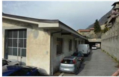
Strada asfaltata che costeggia il capannone lungo il fronte nord (che insiste sul mappale n. 744) e da accesso alla porzione di corte coperta. Tale tratto di strada sarebbe dovuto essere coperto secondo progetto.
