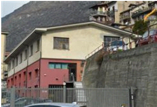
Vista dei fronti sud ed est. Il bene oggetto di esecuzione è quello posto al livello superiore.
