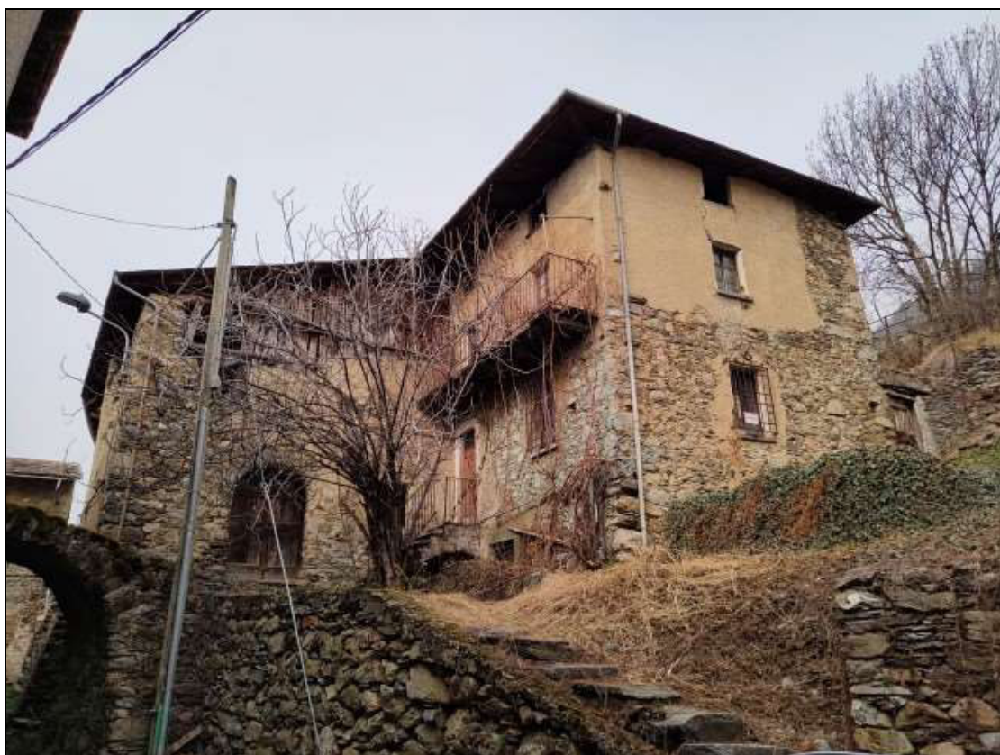
Foto n. 97 – Fabbricato Foglio 50 mappale 337, visto da sud-est
