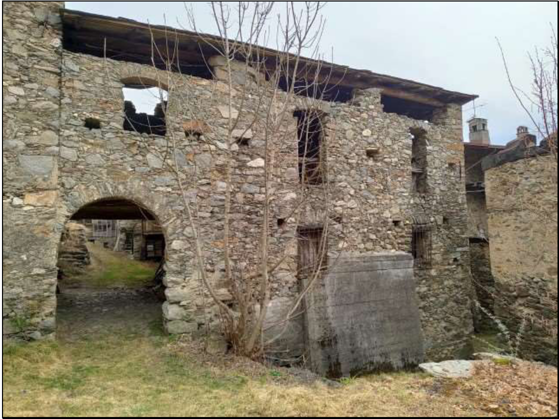
Foto n. 88 – Fabbricato Foglio 50 mappale 333, visto da ovest
