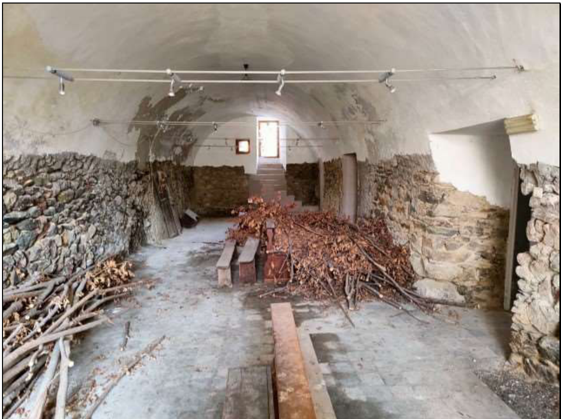
Foto n. 17 – Locale al piano terra del fabbricato Foglio 48 mappale 50
