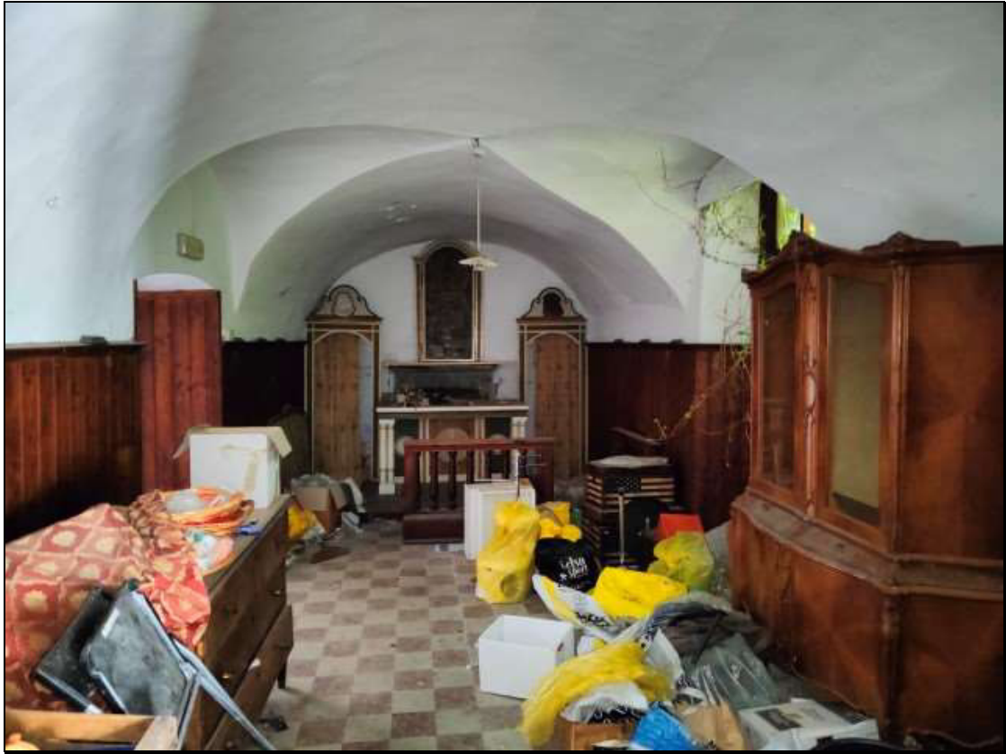
Foto n. 20 – Locale al piano terra del fabbricato Foglio 48 mappale 50
