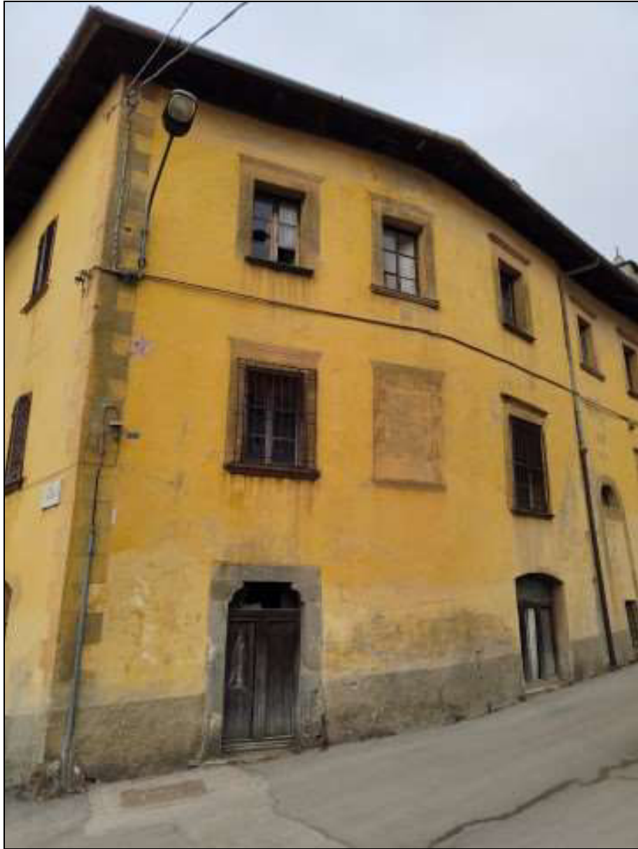
Foto n. 8 – Facciata nord (porzione est) del fabbricato Foglio 48 mappale 50, vista da nord-est
