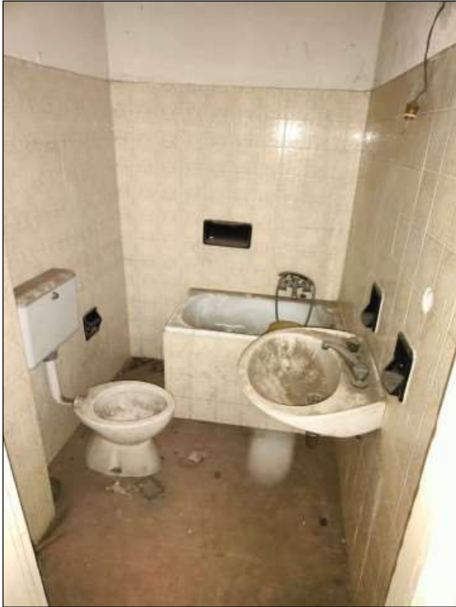
Foto n. 44 – Locale al piano secondo del fabbricato Foglio 48 mappale 50
