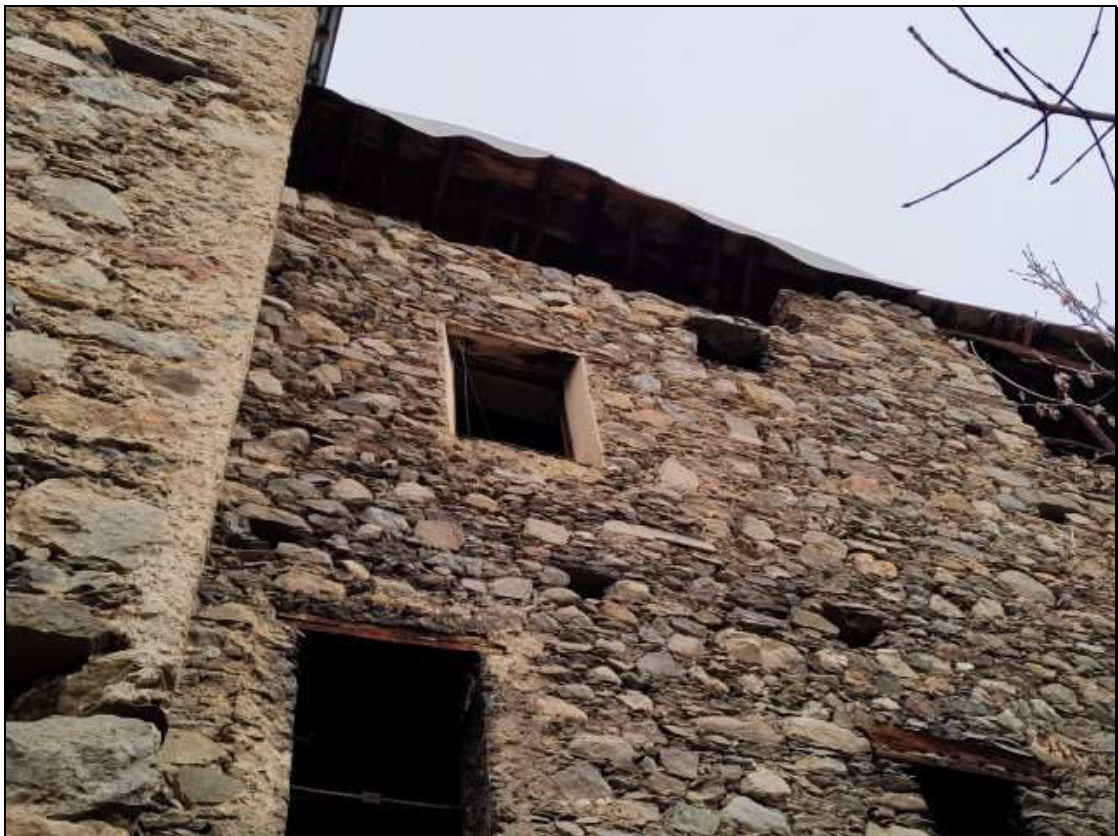
Foto n. 70 – Vista finestra del ripostiglio al piano secondo Foglio 48 mappale 47 sub. 3, ubicata sulla facciata sud del fabbricato
