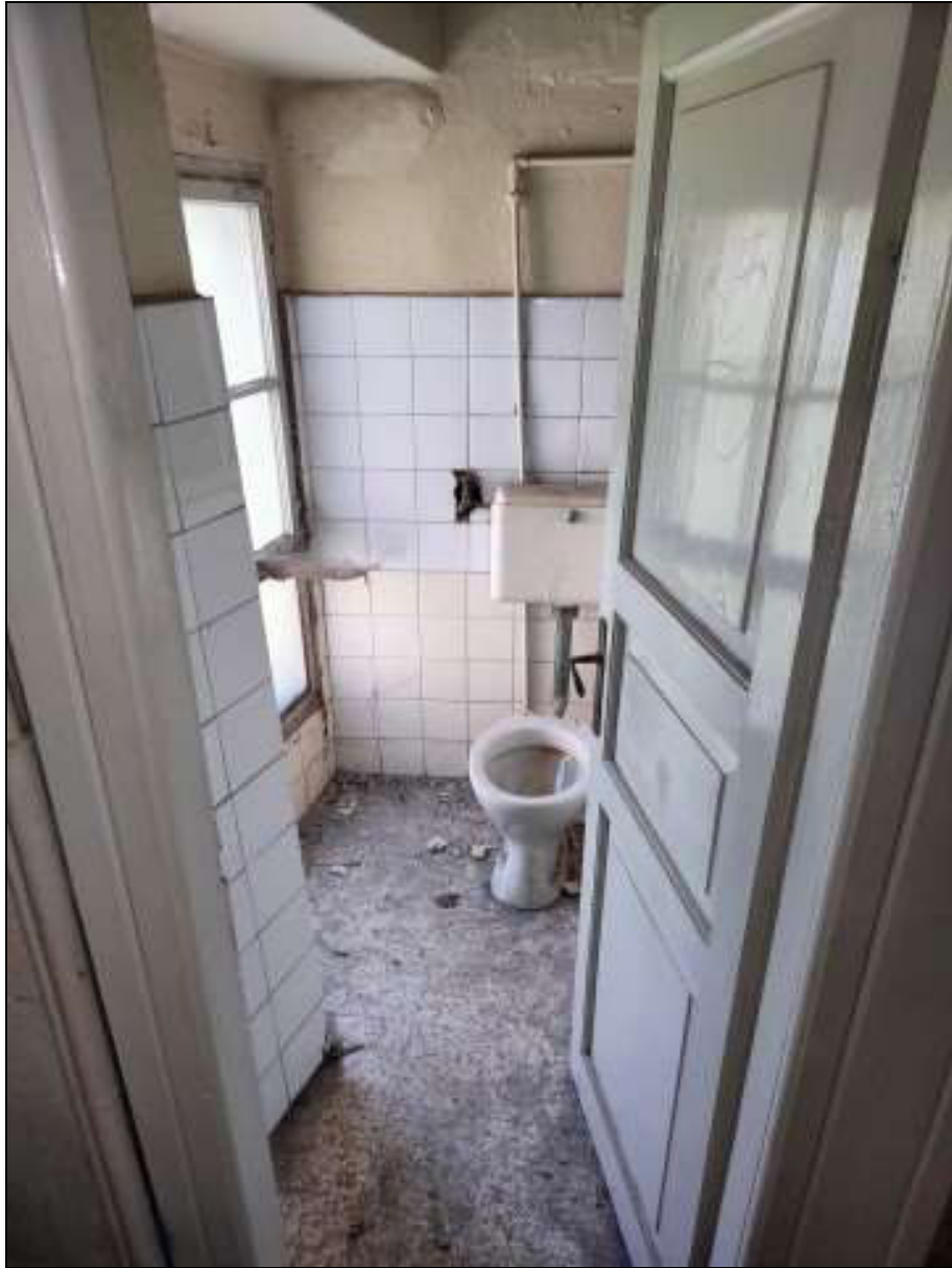
Foto n. 56 – Locale al piano secondo del fabbricato Foglio 48 mappale 50
