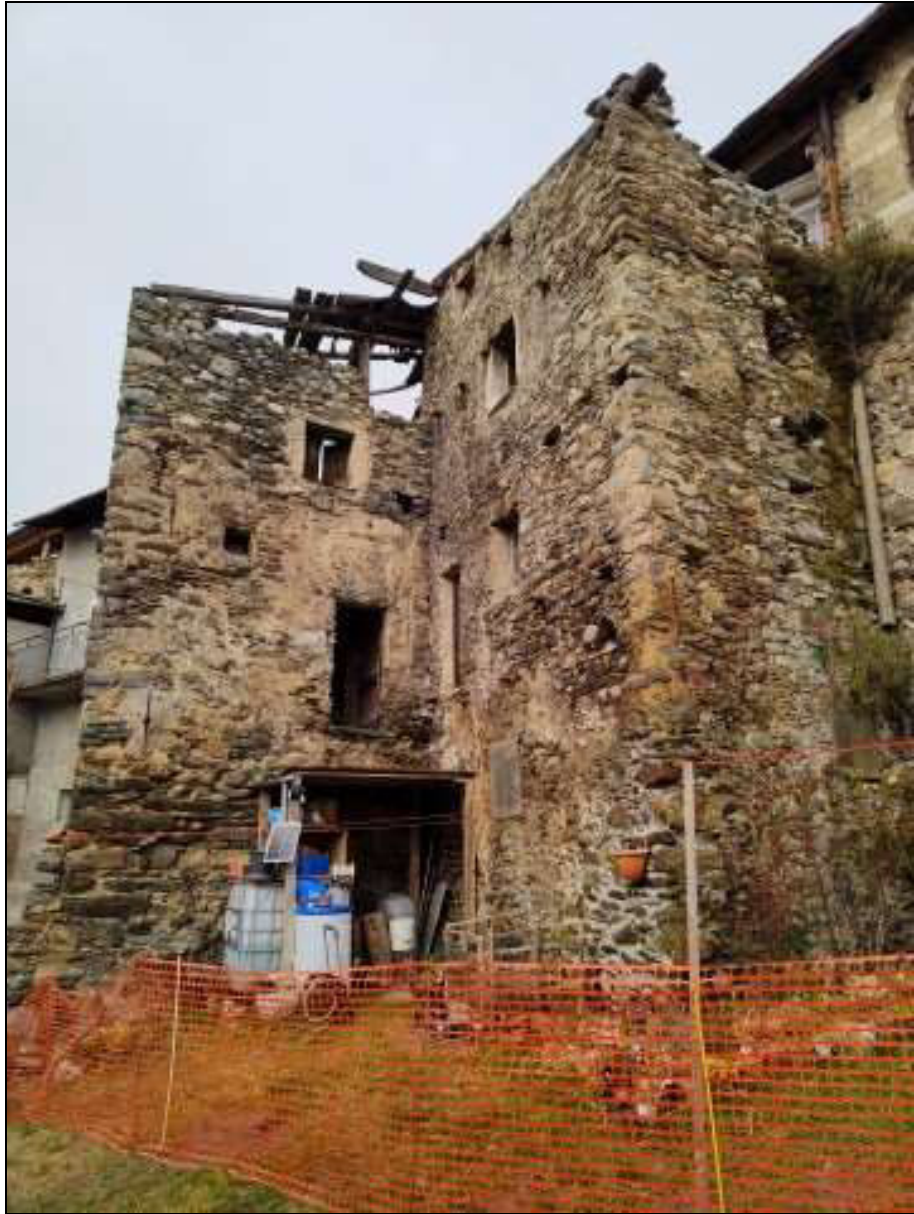
Foto n. 74 – Fabbricato Foglio 48 mappale 48, visto da sud-est
