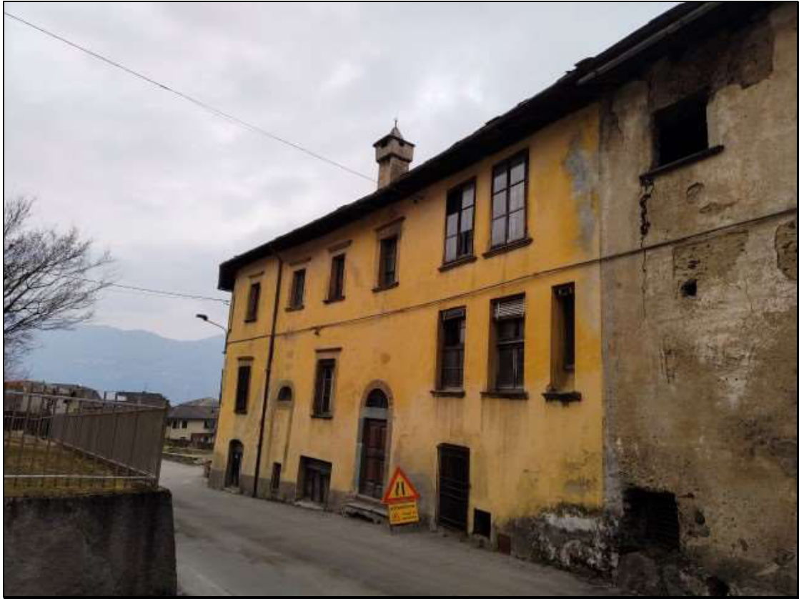
Foto n. 1 – Fabbricato Foglio 48 mappale 50, visto da nord-ovest
