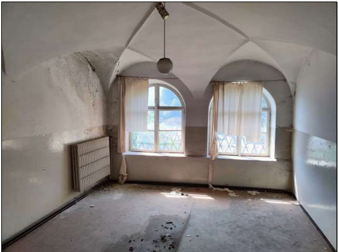
Foto n. 51 – Locale al piano secondo del fabbricato Foglio 48 mappale 50
