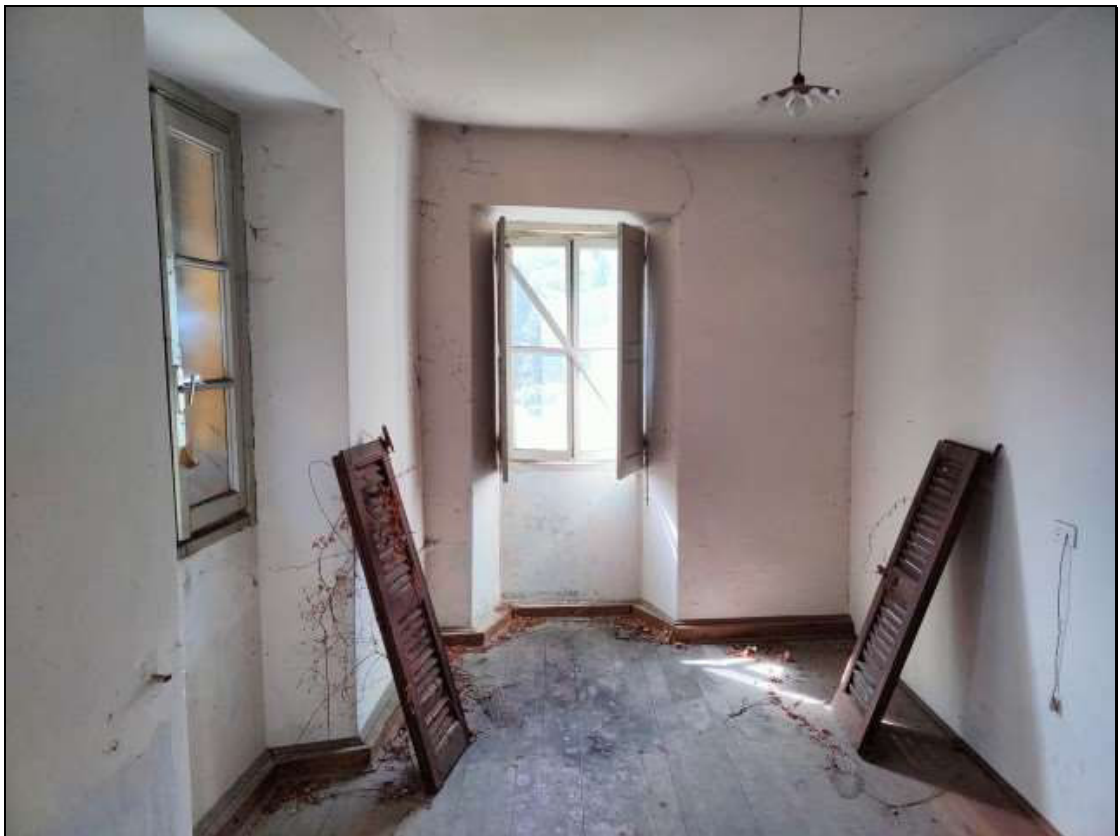
Foto n. 42 – Locale al piano secondo del fabbricato Foglio 48 mappale 50
