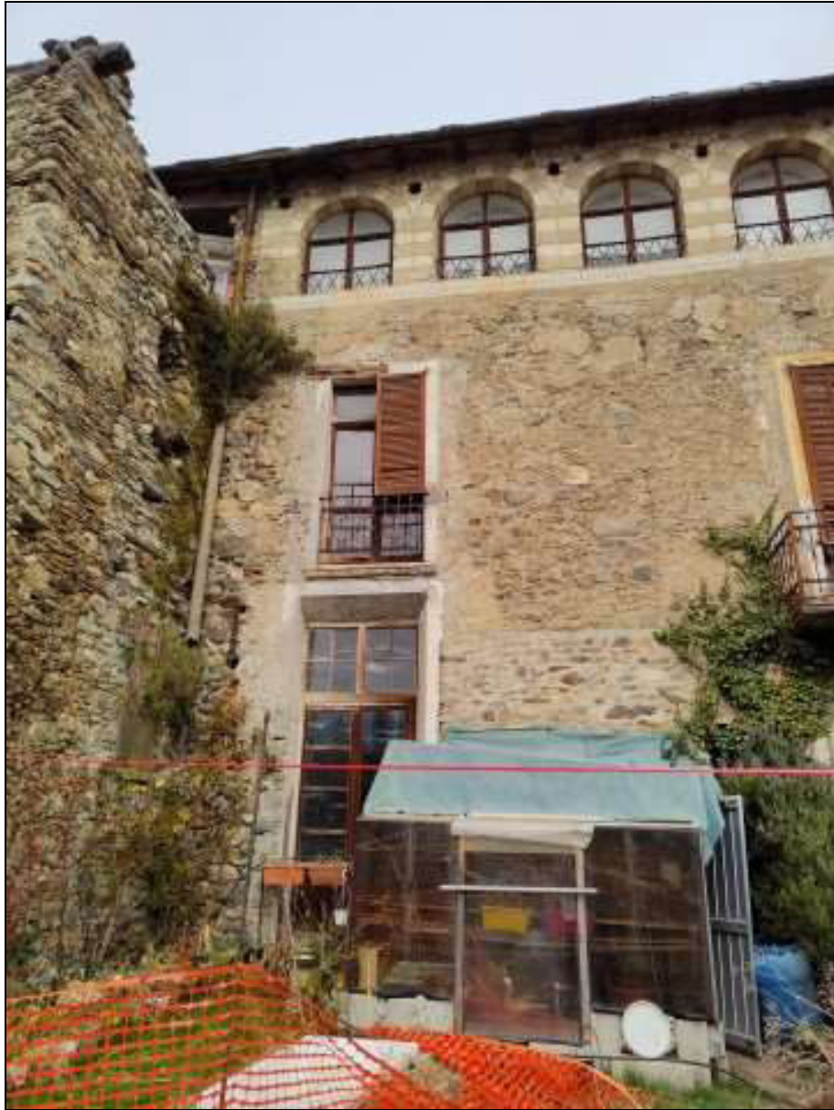
Foto n. 13 – Facciata sud (porzione ovest) del fabbricato Foglio 48 mappale 50, vista da sud
