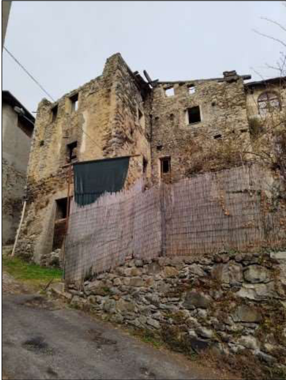
Foto n. 73 – Fabbricato Foglio 48 mappale 48, visto da sud-est
