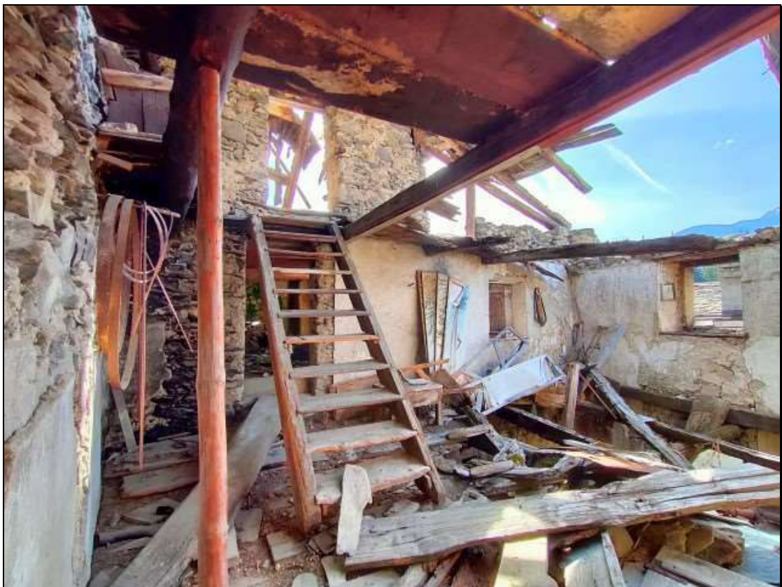
Foto n. 84 – Vista interna del ripostiglio “sud-ovest” al piano secondo, con vista porta d’ingresso al ripostiglio “sud-est” al piano secondo, entrambi i ripostigli identificati con il Foglio 48 mappale 48 sub. 1
