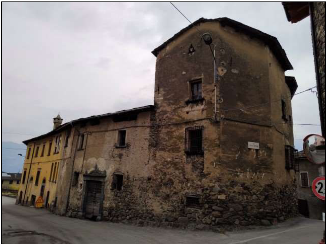
Foto n. 66 – Fabbricato Foglio 48 mappale 47, visto da nord-ovest
