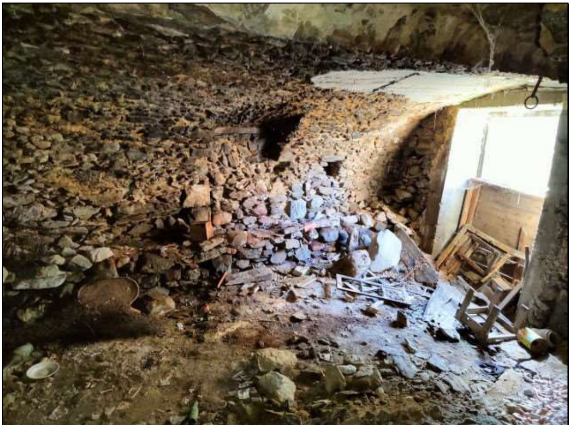
Foto n. 78 – Vista interna del ripostiglio “sud” al piano terra, identificato con il Foglio 48 mappale 48 sub. 1
