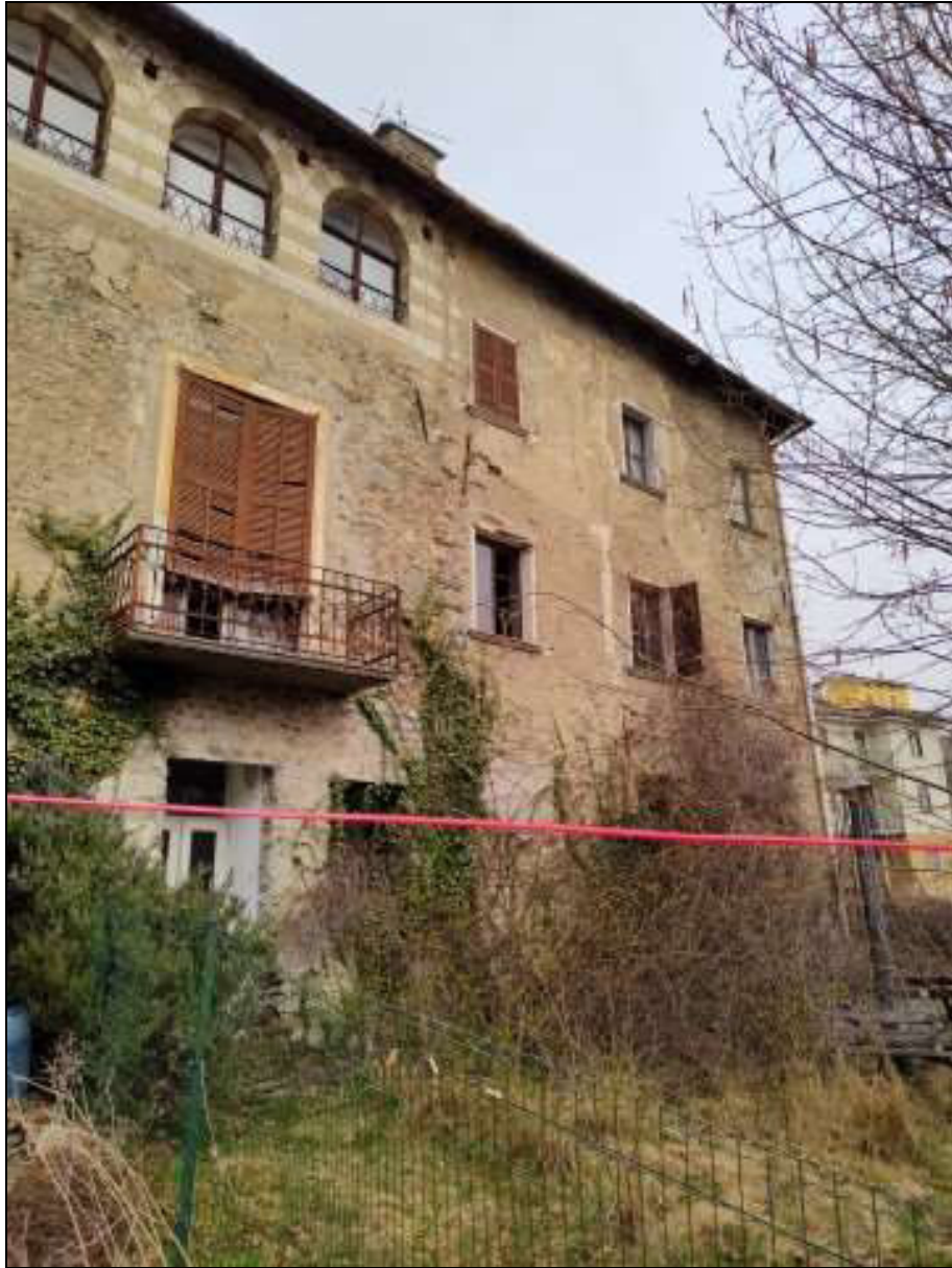
Foto n. 11 – Facciata sud (porzione est) del fabbricato Foglio 48 mappale 50, vista da sud-ovest
