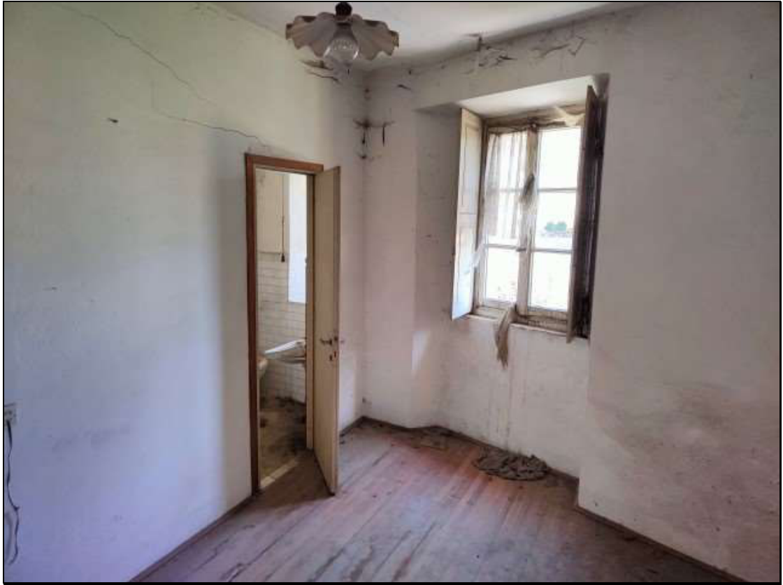
Foto n. 41 – Locale al piano secondo del fabbricato Foglio 48 mappale 50
