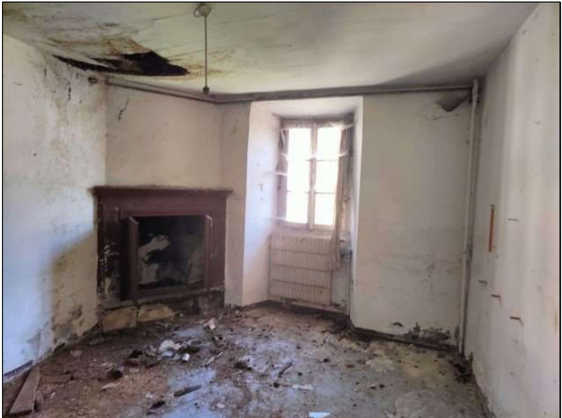
Foto n. 48 – Locale al piano secondo del fabbricato Foglio 48 mappale 50
