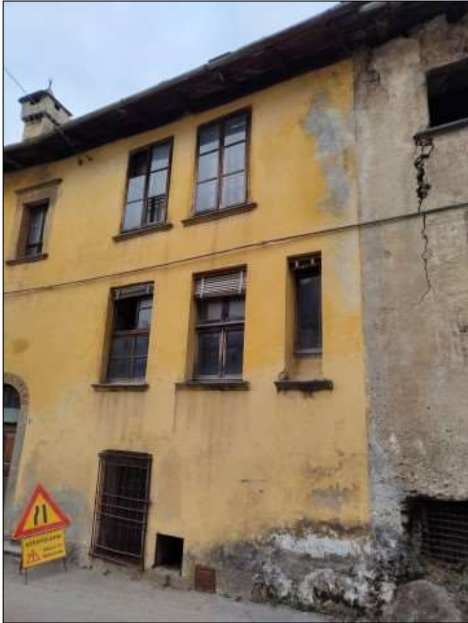
Foto n. 6 – Facciata nord (porzione ovest) del fabbricato Foglio 48 mappale 50, vista da nord-ovest
