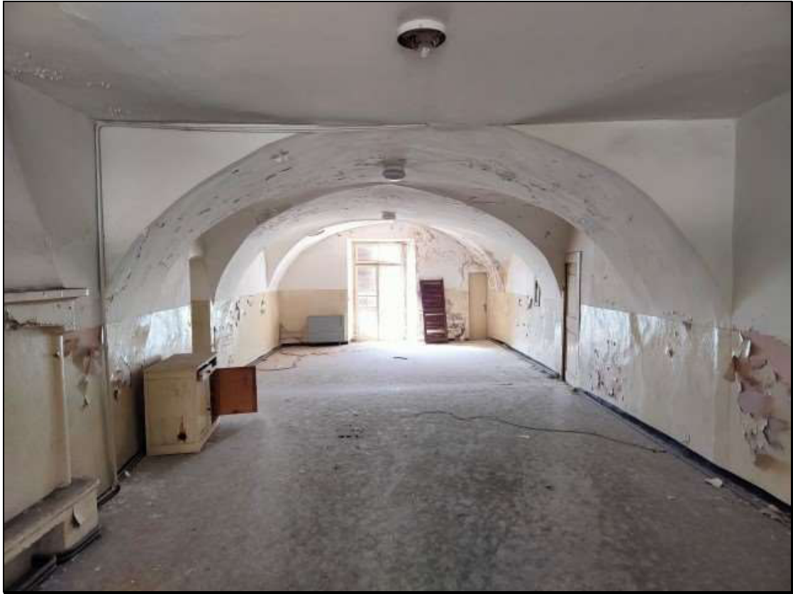
Foto n. 26 – Locale al piano primo del fabbricato Foglio 48 mappale 50
