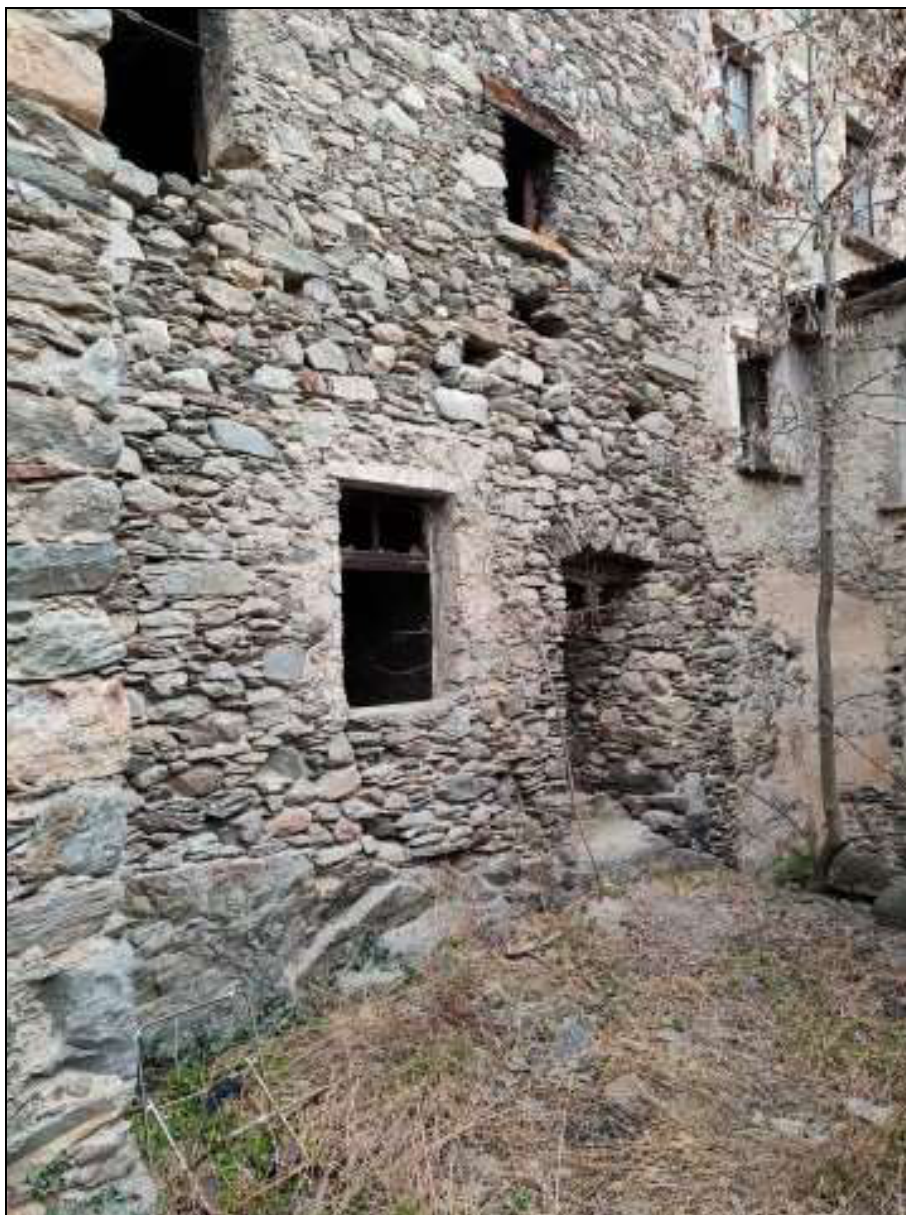
Foto n. 63 – Facciata sud (porzione est, piani bassi) del fabbricato Foglio 48 mappale 47, vista da sud-ovest
