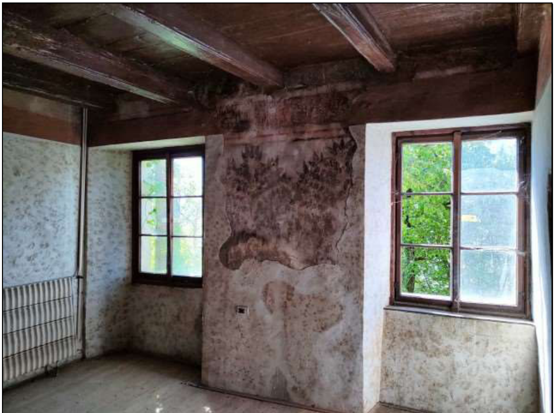
Foto n. 34 – Locale al piano primo del fabbricato Foglio 48 mappale 50
