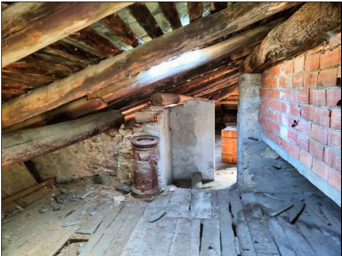
Foto n. 59 – Piano terzo/sottotetto del fabbricato Foglio 48 mappale 50
