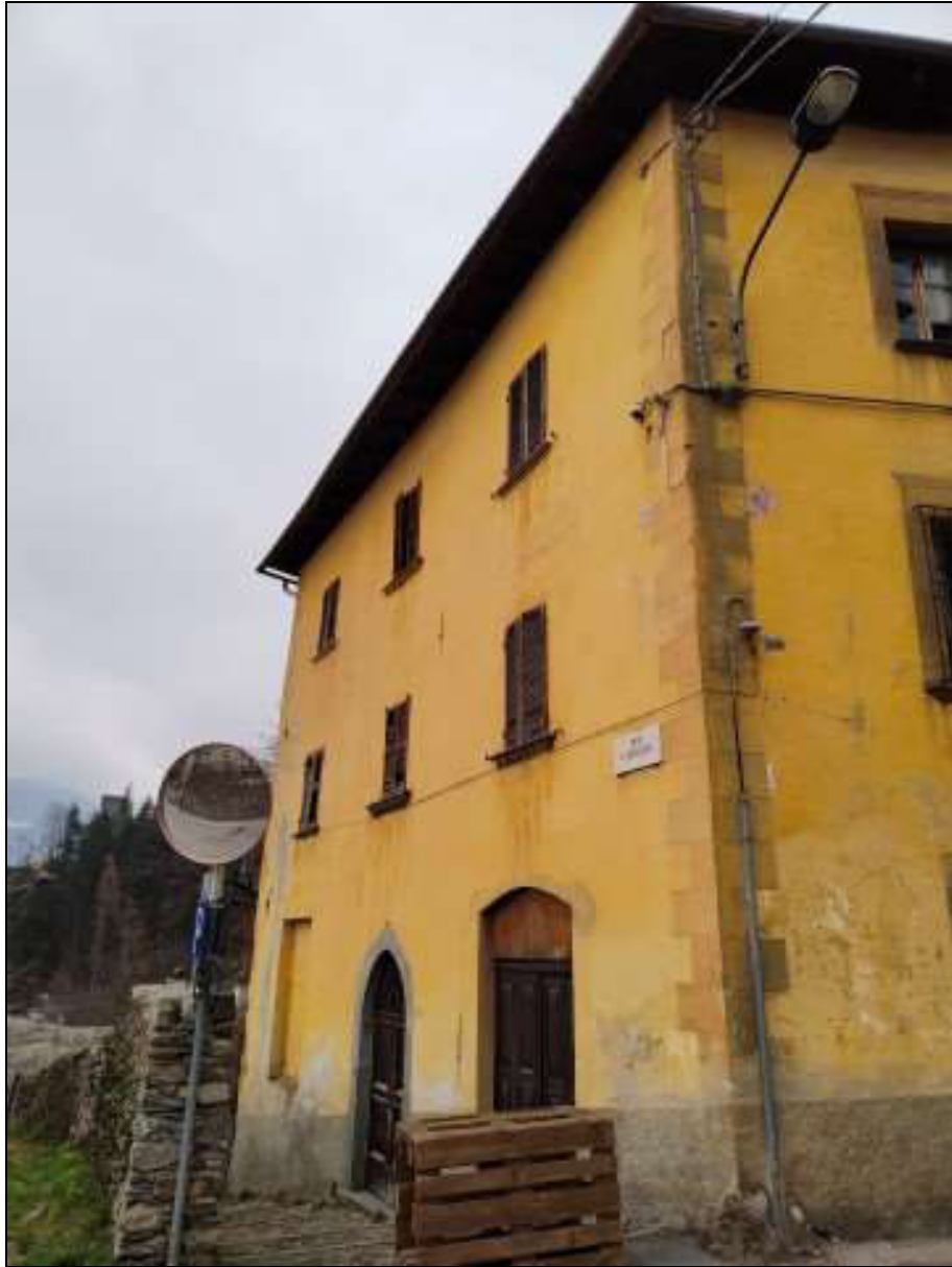
Foto n. 9 – Facciata est del fabbricato Foglio 48 mappale 50, vista da nord-est
