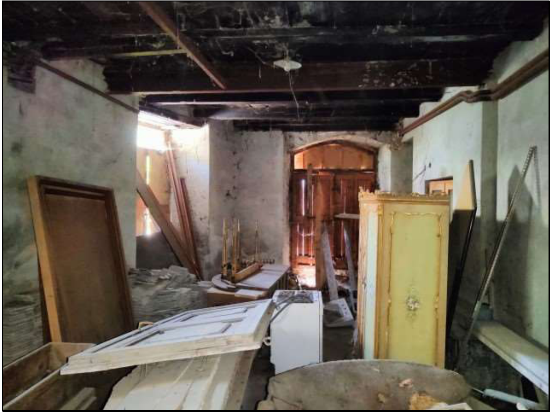
Foto n. 22 – Locale al piano terra del fabbricato Foglio 48 mappale 50
