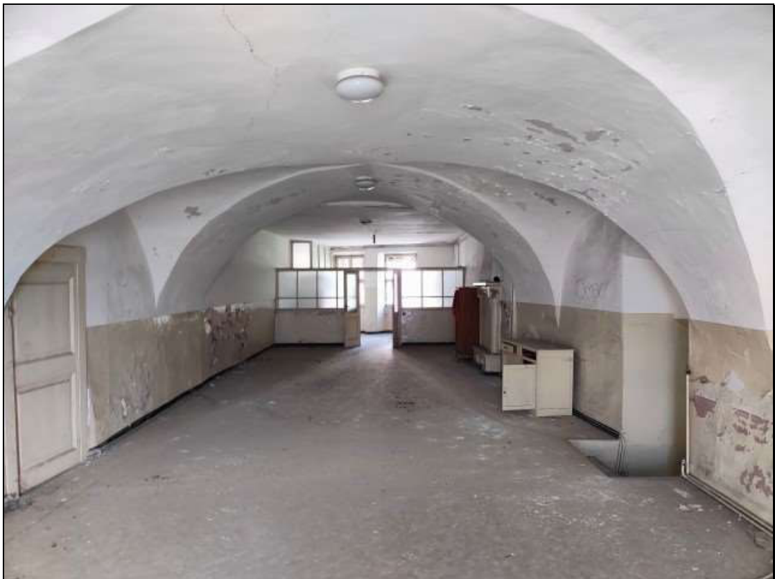
Foto n. 27 – Locale al piano primo del fabbricato Foglio 48 mappale 50
