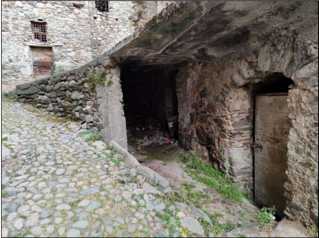
Foto n. 75 – Vista porte d’ingresso ai locali ripostiglio al piano terra, identificati con il Foglio 48 mappale 48 sub. 1
