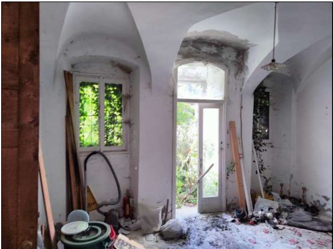
Foto n. 19 – Locale al piano terra del fabbricato Foglio 48 mappale 50
