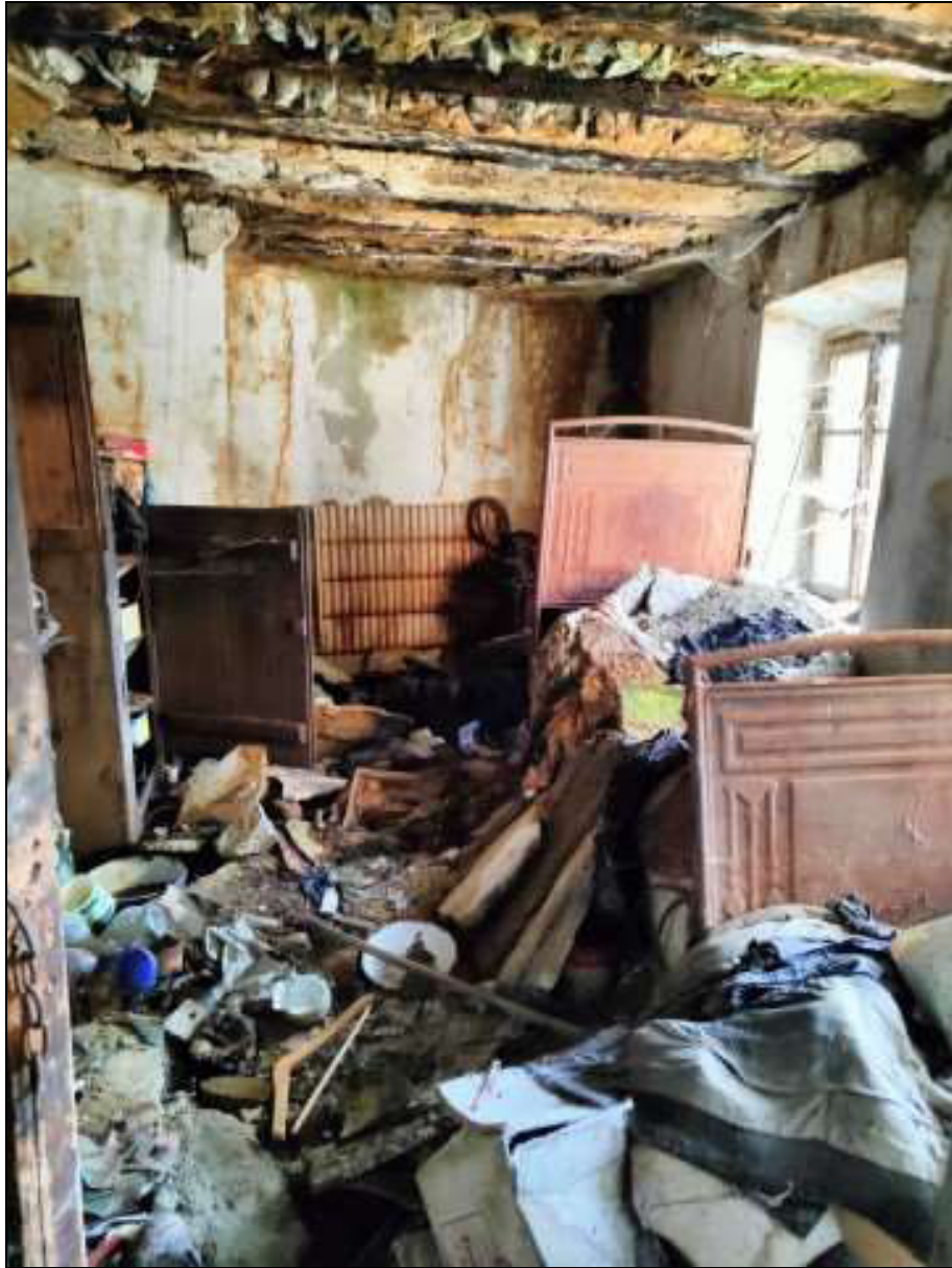
Foto n. 82 – Vista interna del ripostiglio “sud-est” al piano primo, identificato con il Foglio 48 mappale 48 sub. 1
