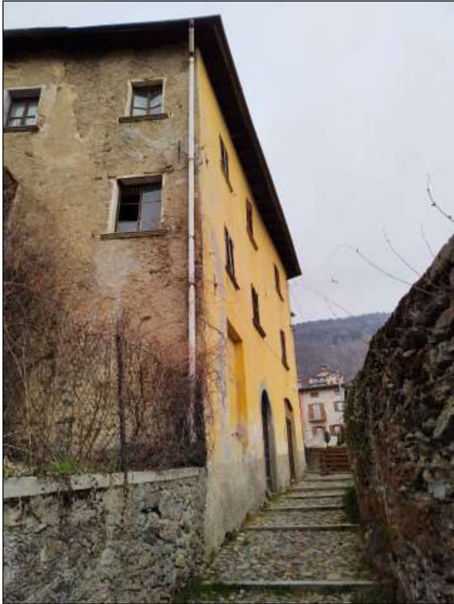
Foto n. 10 – Facciata est del fabbricato Foglio 48 mappale 50, vista da sud-est
