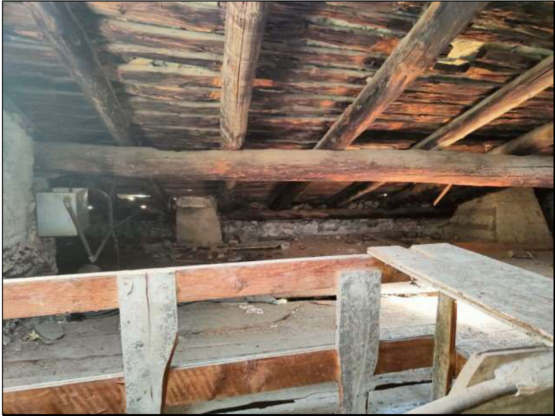
Foto n. 58 – Piano terzo/sottotetto del fabbricato Foglio 48 mappale 50
