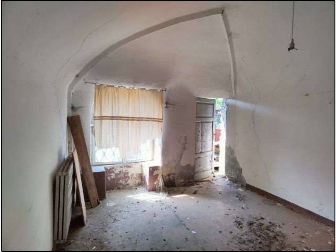
Foto n. 52 – Locale al piano secondo del fabbricato Foglio 48 mappale 50
