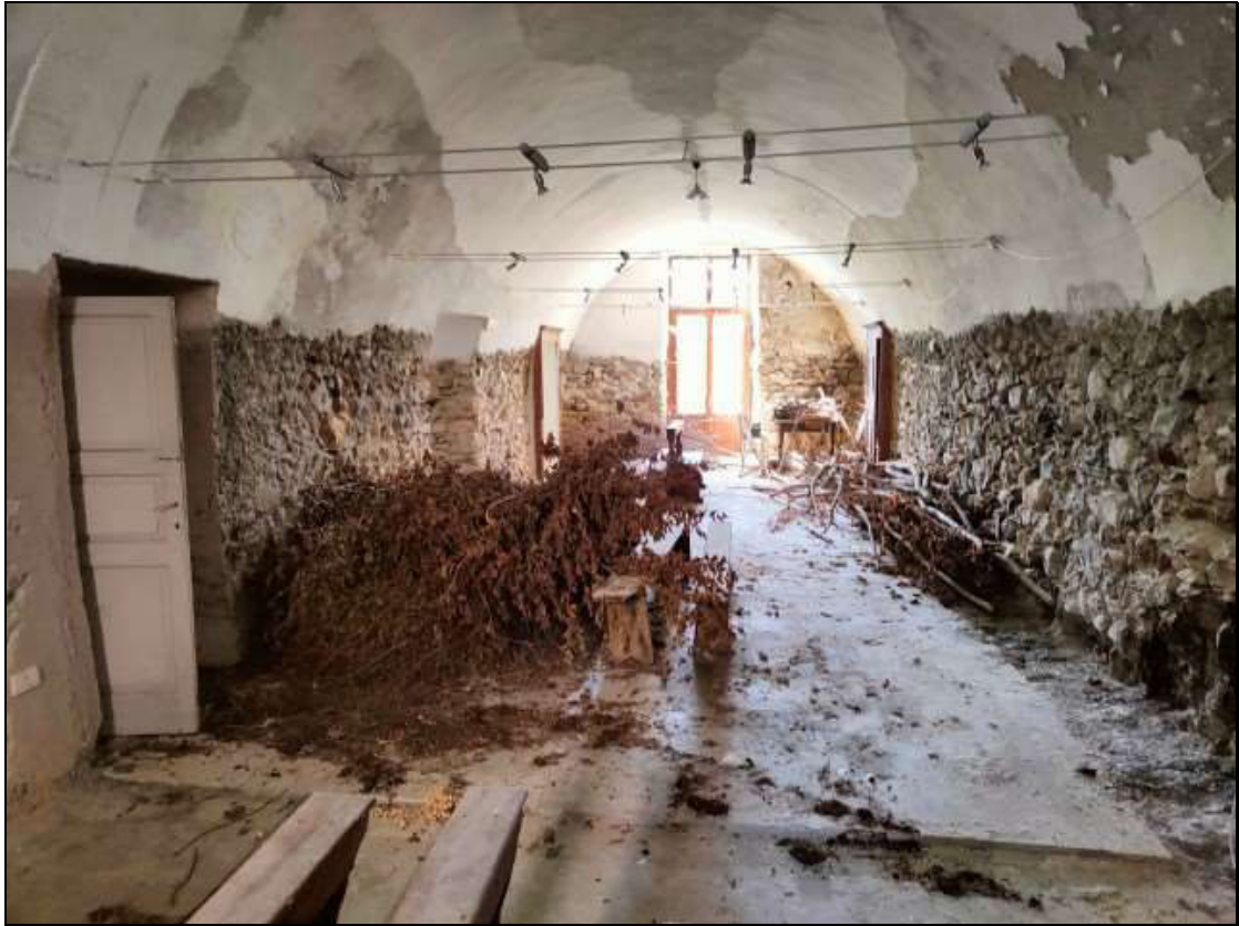
Foto n. 18 – Locale al piano terra del fabbricato Foglio 48 mappale 50
