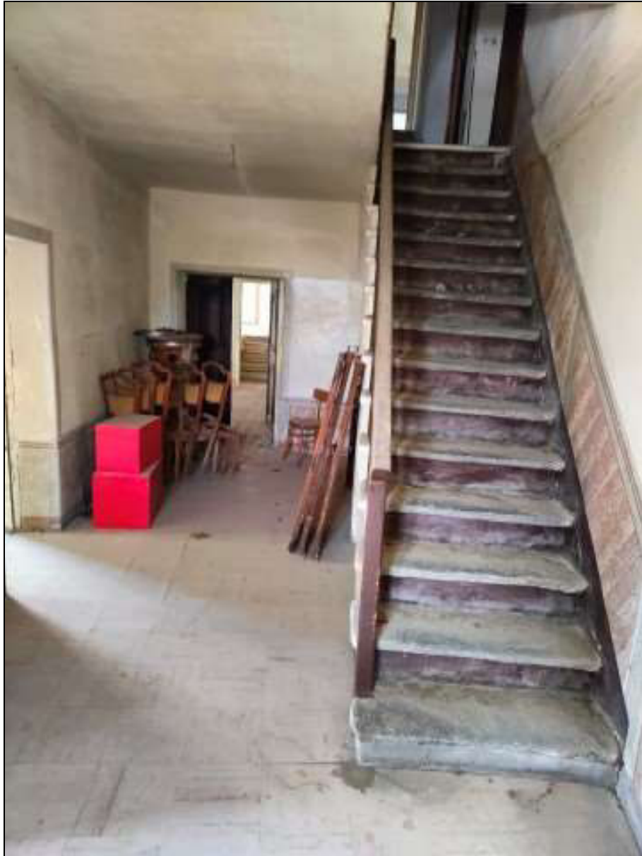
Foto n. 37 – Locale al piano primo del fabbricato Foglio 48 mappale 50, con vista scala di collegamento tra il piano primo e il piano secondo (scala est)
