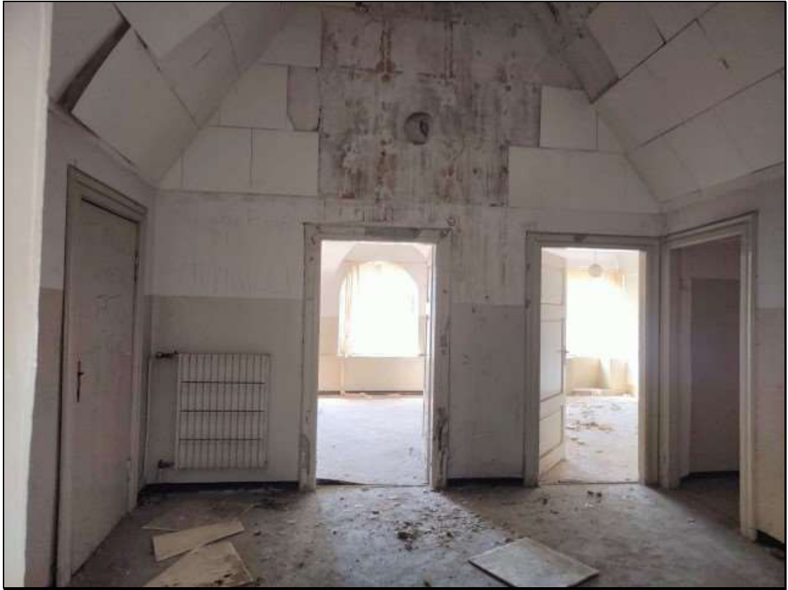
Foto n. 50 – Locale al piano secondo del fabbricato Foglio 48 mappale 50
