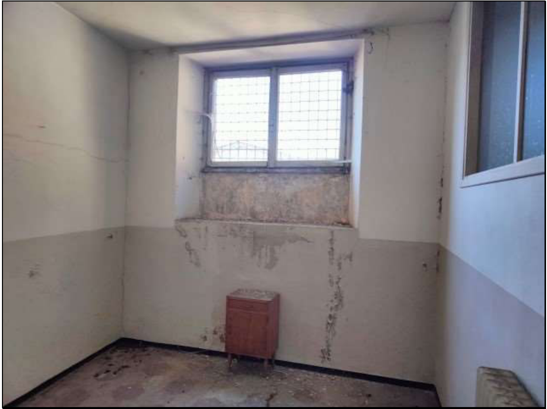
Foto n. 54 – Locale al piano secondo del fabbricato Foglio 48 mappale 50
