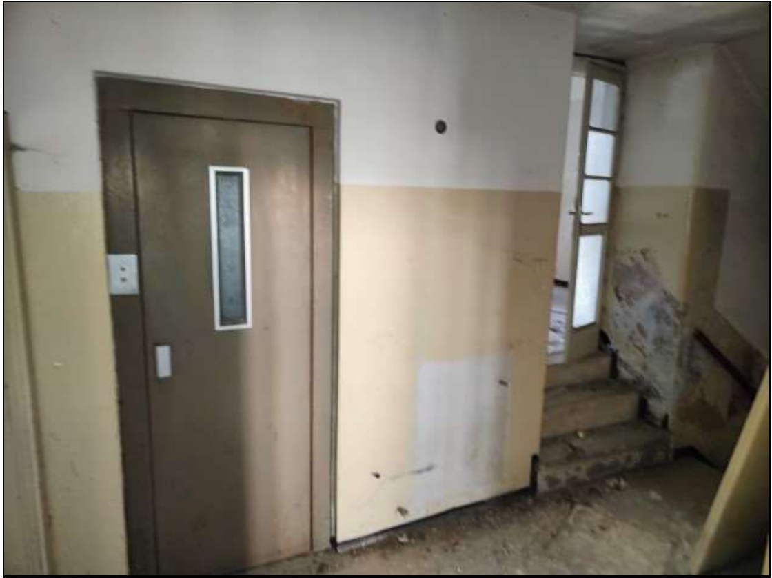
Foto n. 47 – Locale al piano secondo del fabbricato Foglio 48 mappale 50, con vista ascensore
