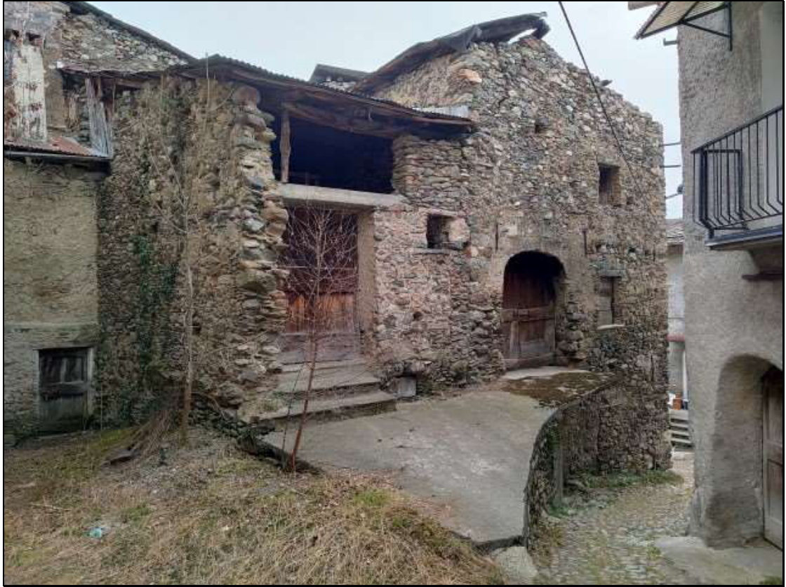
Foto n. 71 – Fabbricato Foglio 48 mappale 48, visto da nord-ovest
