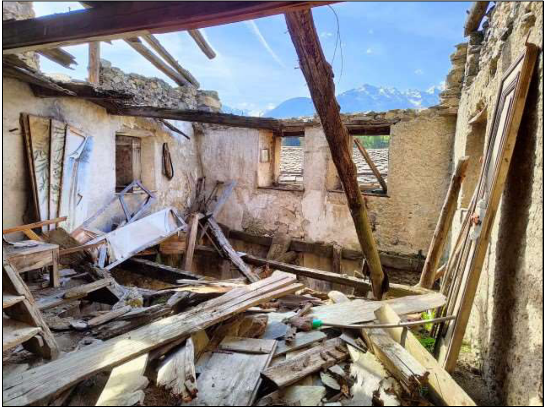
Foto n. 83 – Vista interna del ripostiglio “sud-ovest” al piano secondo, identificato con il Foglio 48 mappale 48 sub. 1
