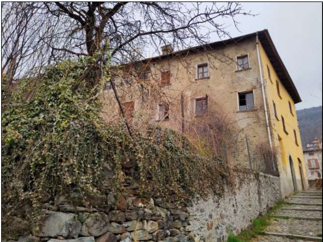
Foto n. 4 – Fabbricato Foglio 48 mappale 50, visto da sud-est (vista ravvicinata)
