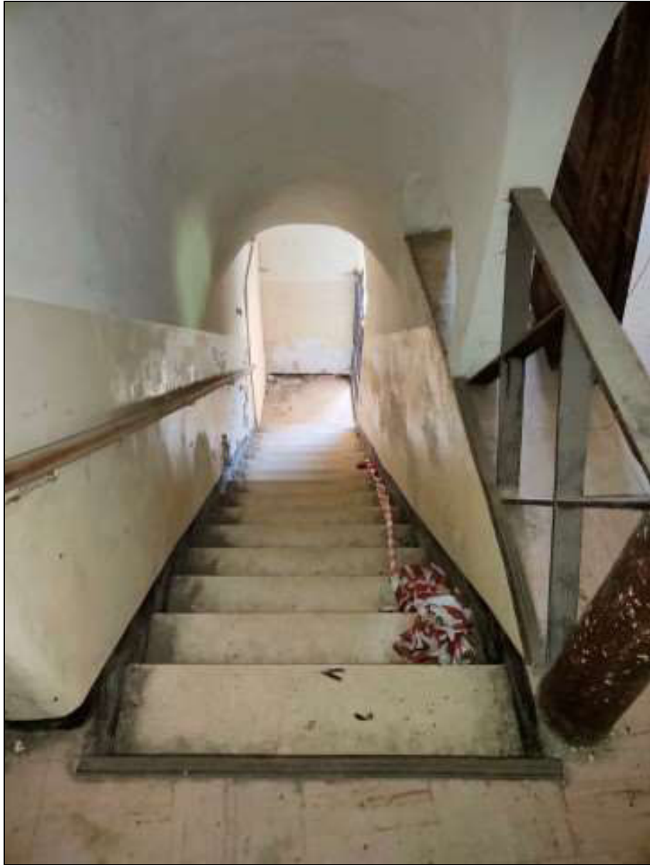
Foto n. 25 – Scala di collegamento tra il piano terra e il piano primo (scala est), del fabbricato Foglio 48 mappale 50
