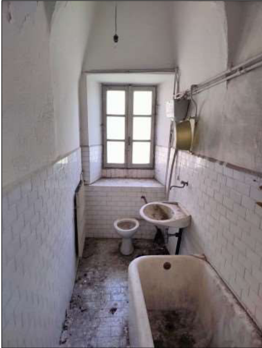
Foto n. 49 – Locale al piano secondo del fabbricato Foglio 48 mappale 50
