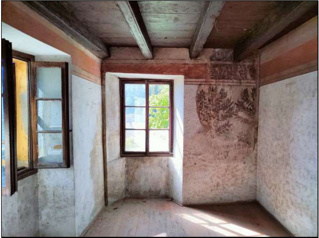
Foto n. 35 – Locale al piano primo del fabbricato Foglio 48 mappale 50
