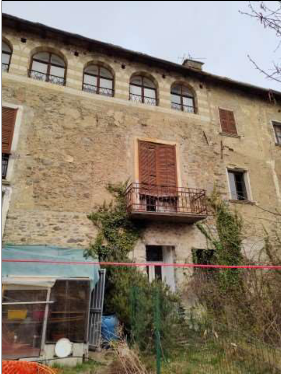
Foto n. 12 – Facciata sud (porzione centrale) del fabbricato Foglio 48 mappale 50, vista da sud-ovest
