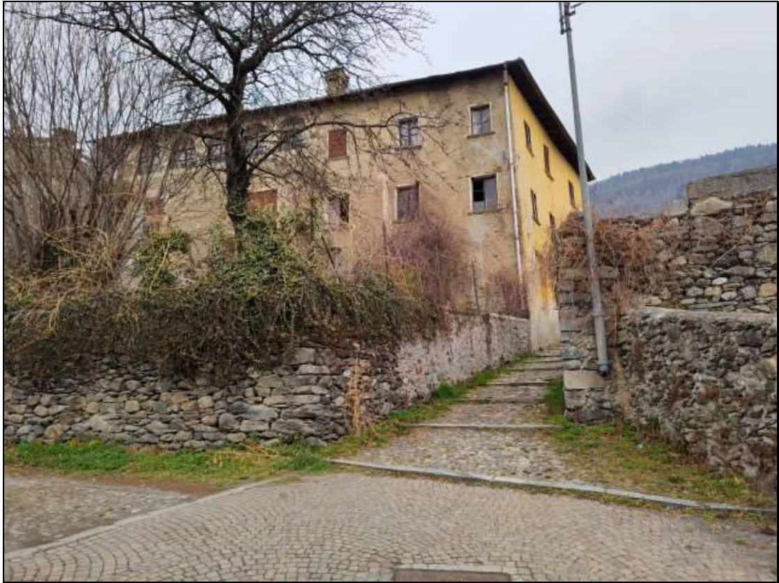
Foto n. 3 – Fabbricato Foglio 48 mappale 50, visto da sud-est
