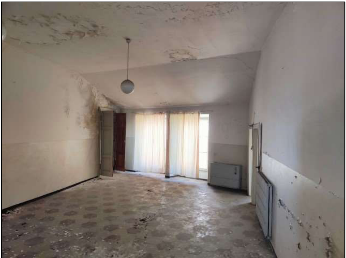
Foto n. 53 – Locale al piano secondo del fabbricato Foglio 48 mappale 50
