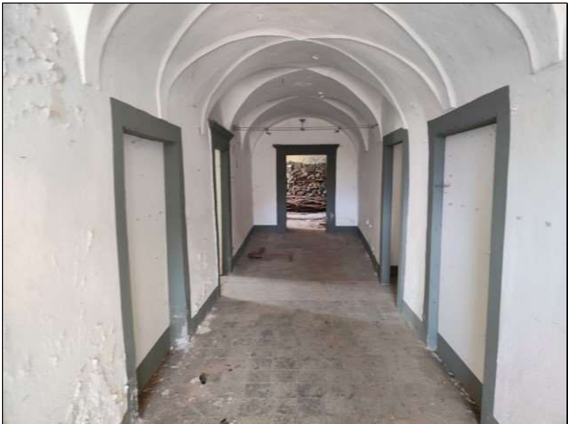
Foto n. 21 – Locale al piano terra del fabbricato Foglio 48 mappale 50
