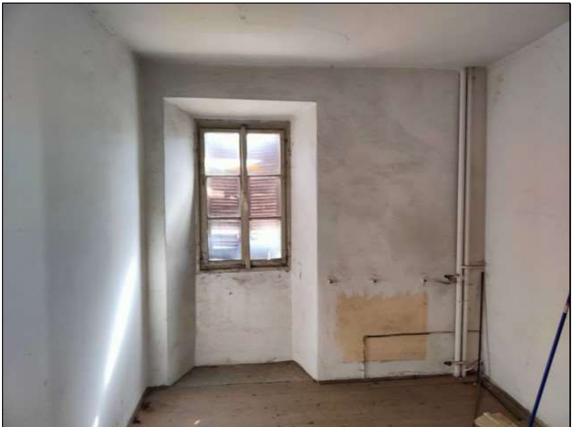
Foto n. 36 – Locale al piano primo del fabbricato Foglio 48 mappale 50
