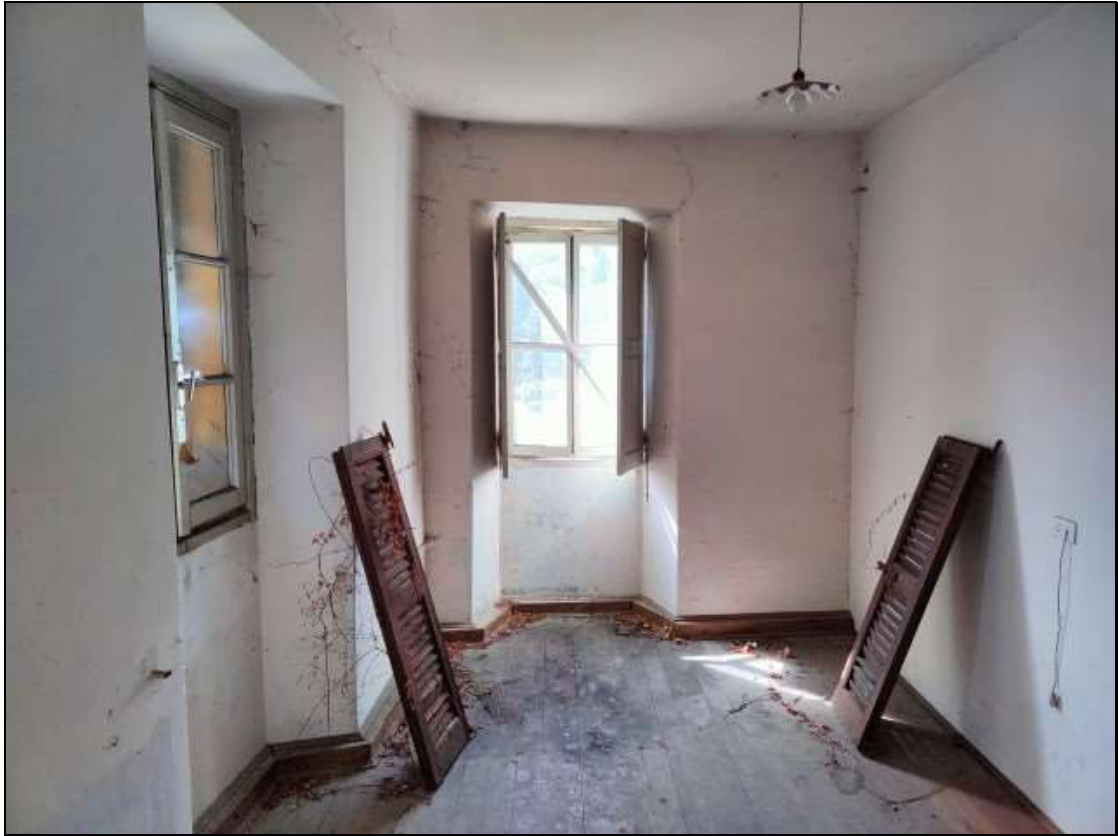
Foto n. 45 – Locale al piano secondo del fabbricato Foglio 48 mappale 50
