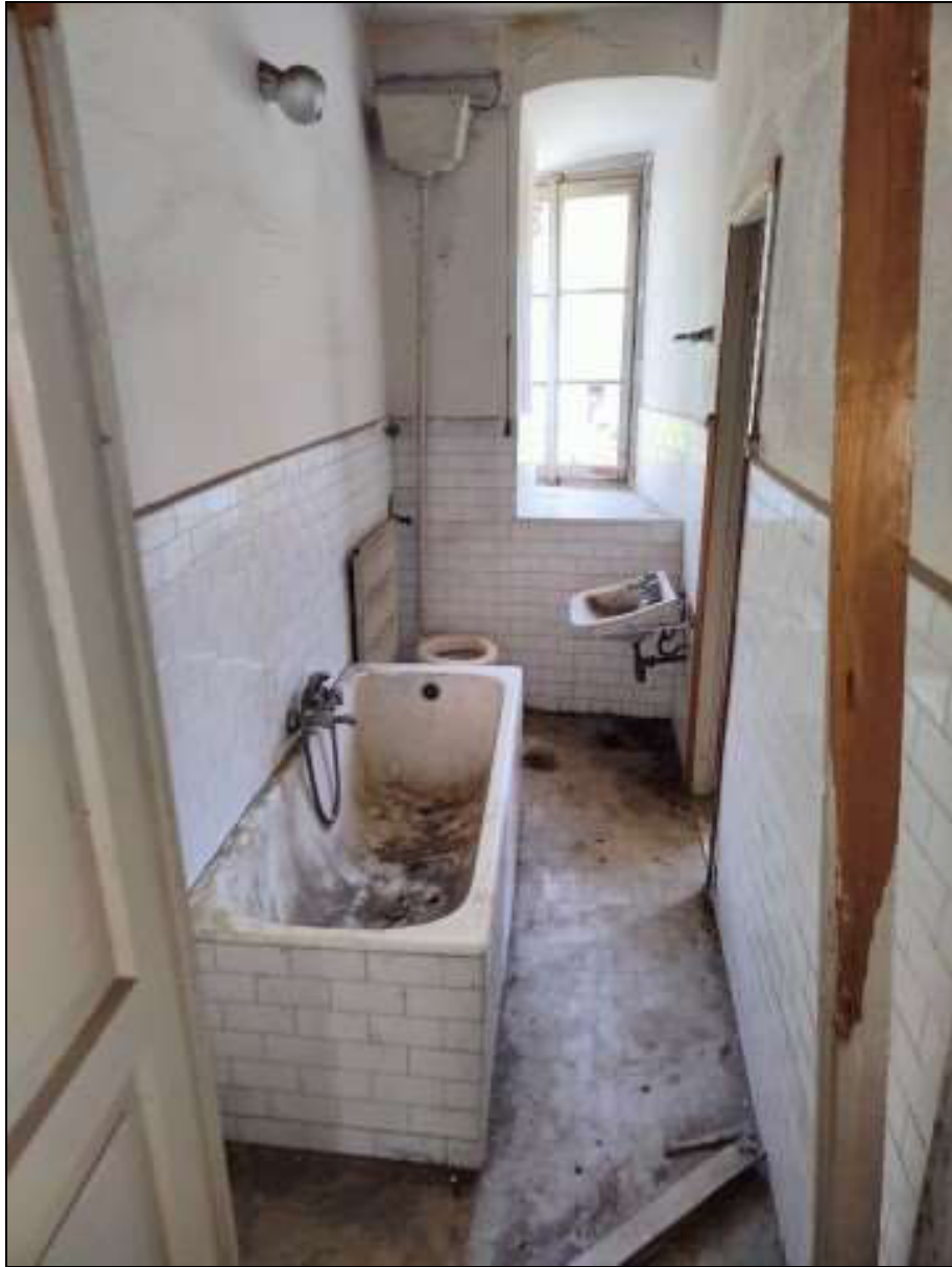
Foto n. 43 – Locale al piano secondo del fabbricato Foglio 48 mappale 50
