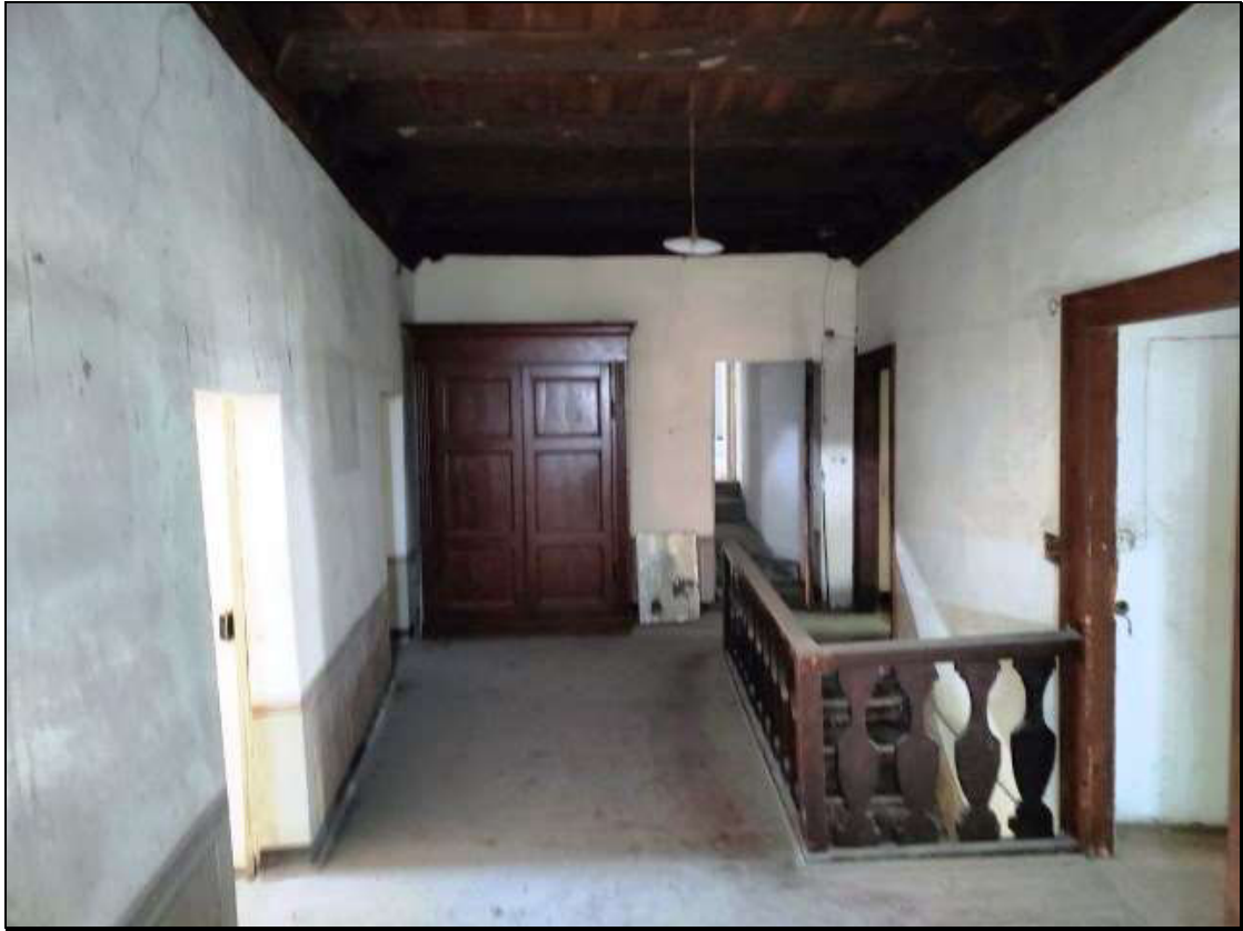
Foto n. 39 – Locale al piano secondo del fabbricato Foglio 48 mappale 50
