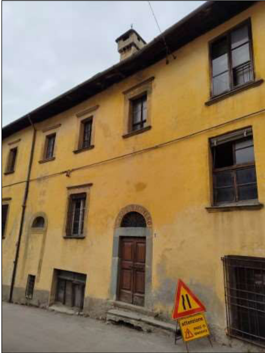
Foto n. 7 – Facciata nord (porzione centrale) del fabbricato Foglio 48 mappale 50, vista da nord-ovest
