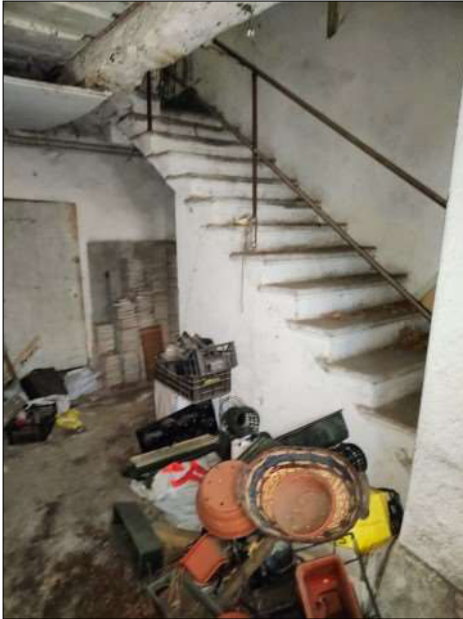
Foto n. 24 – Scala di collegamento tra il piano terra e il piano primo (scala ovest), del fabbricato Foglio 48 mappale 50
