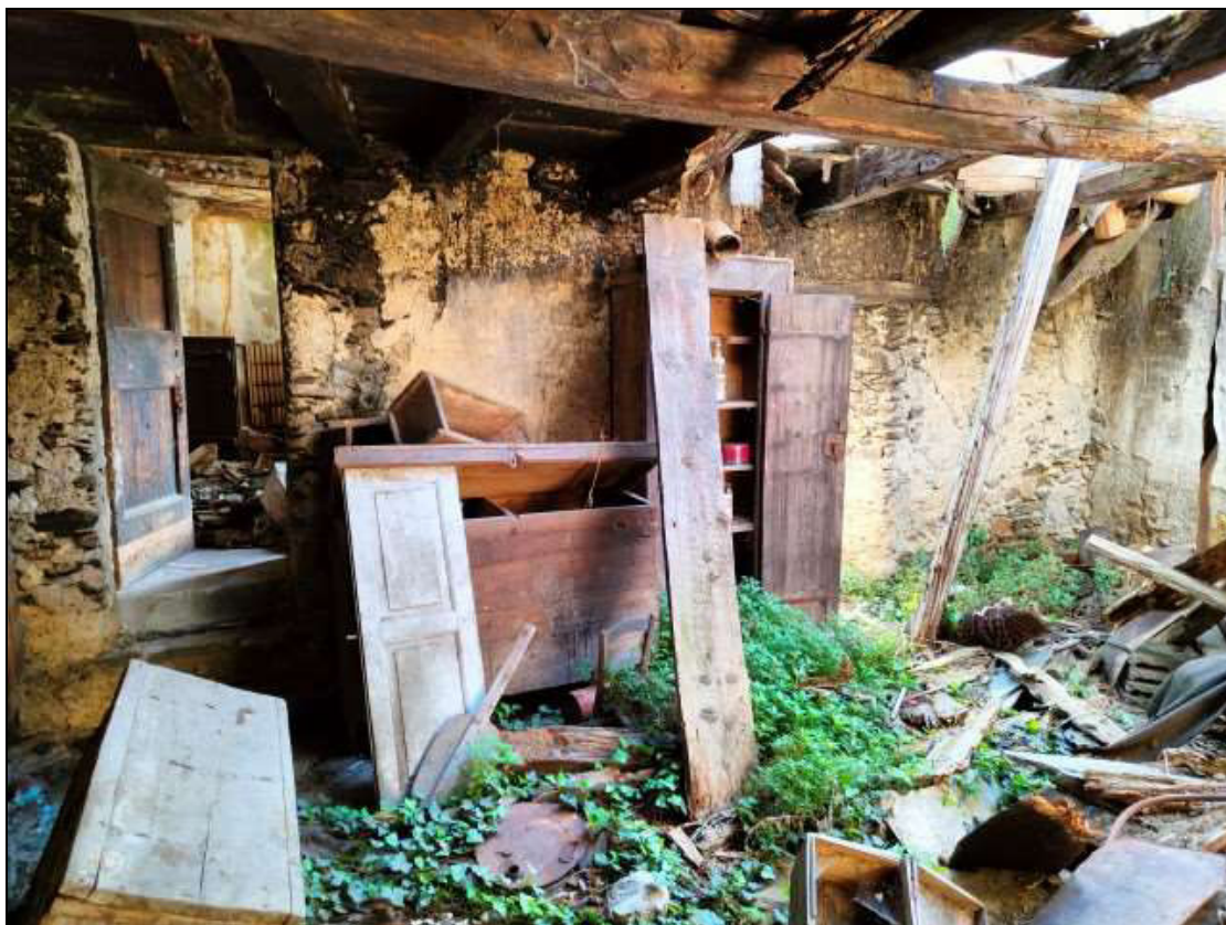
Foto n. 81 – Vista interna del ripostiglio “sud-ovest” al piano primo, identificato con il Foglio 48 mappale 48 sub. 1
