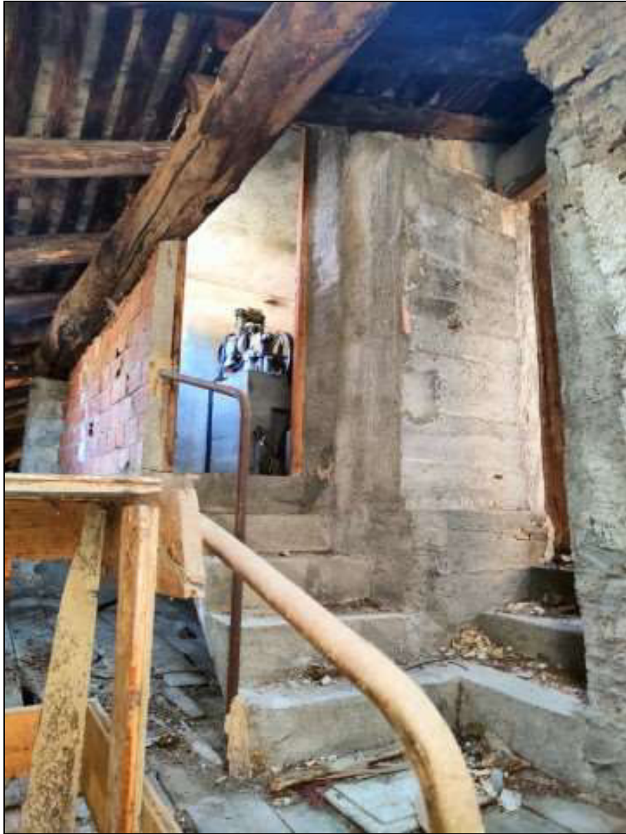
Foto n. 60 – Piano terzo/sottotetto del fabbricato Foglio 48 mappale 50
