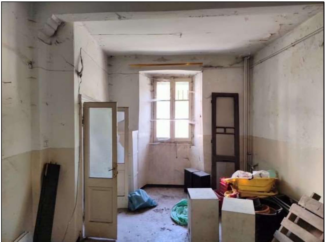
Foto n. 29 – Locale al piano primo del fabbricato Foglio 48 mappale 50
