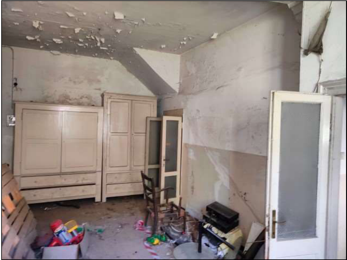
Foto n. 30 – Locale al piano primo del fabbricato Foglio 48 mappale 50
