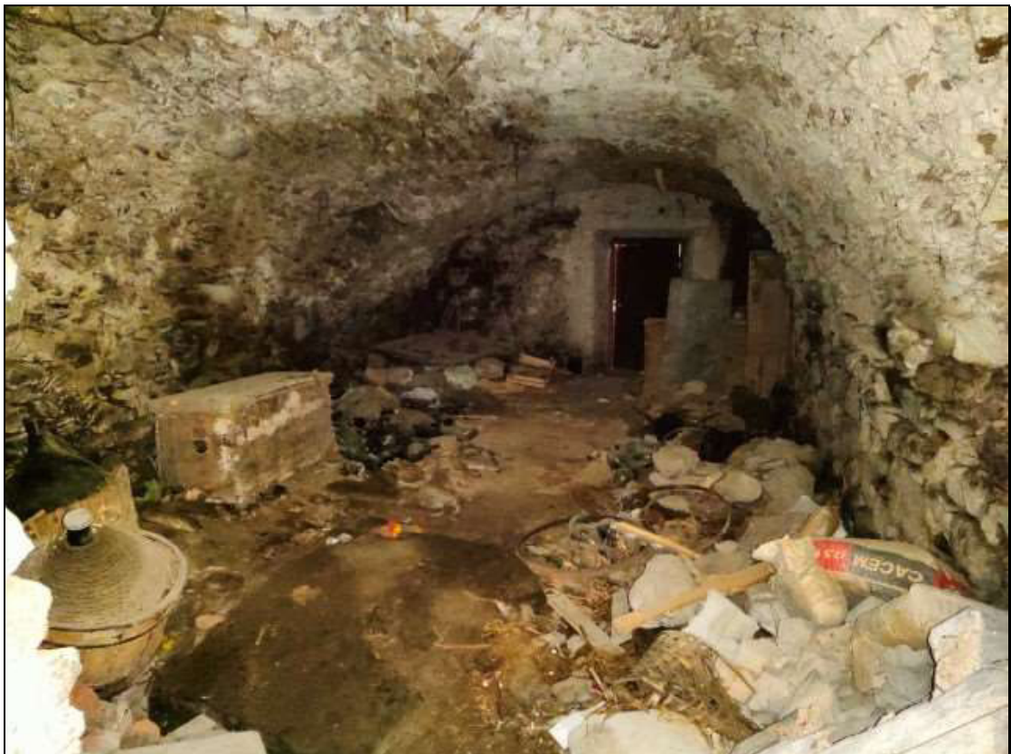
Foto n. 76 – Vista interna del ripostiglio “nord” al piano terra, identificato con il Foglio 48 mappale 48 sub. 1
