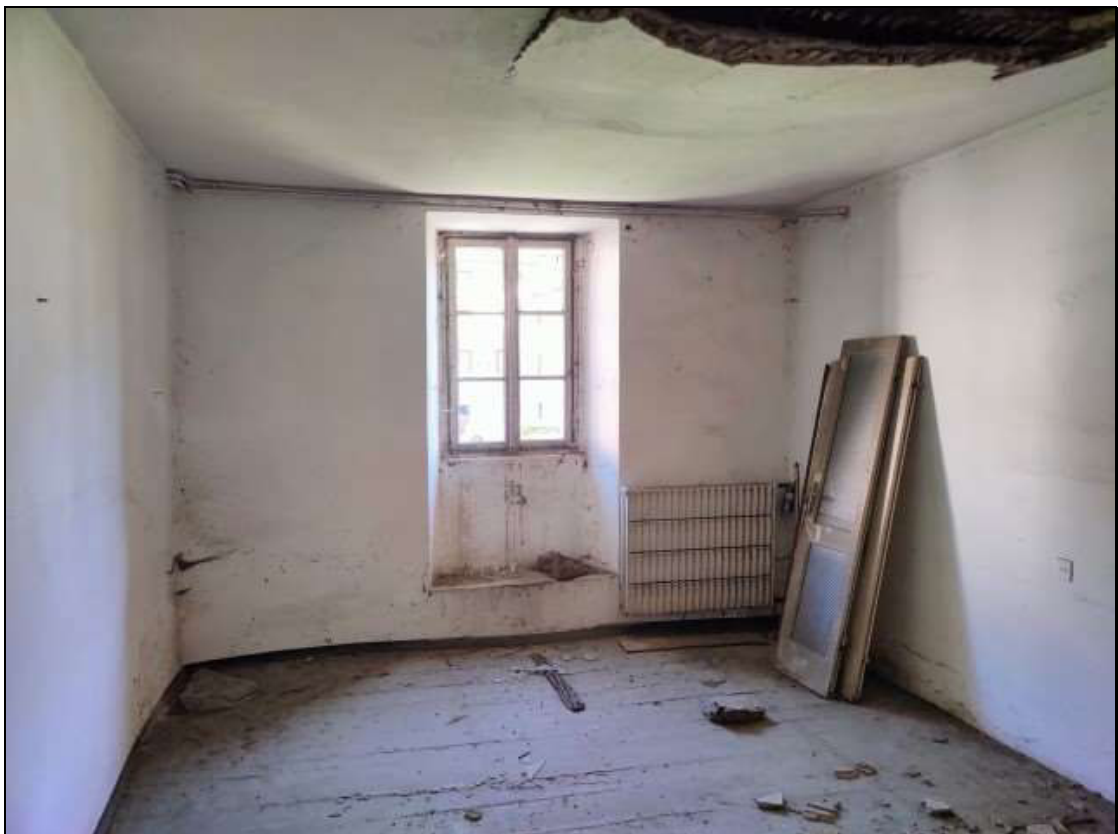
Foto n. 46 – Locale al piano secondo del fabbricato Foglio 48 mappale 50
