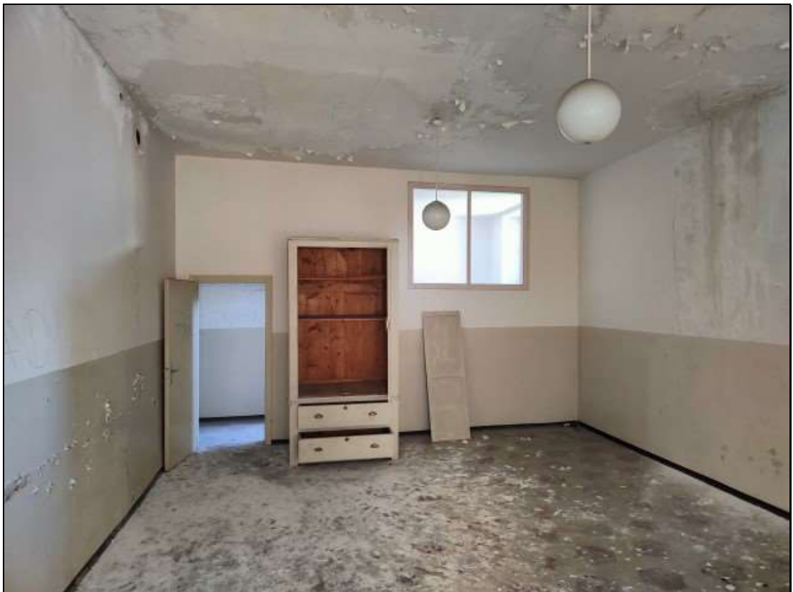
Foto n. 55 – Locale al piano secondo del fabbricato Foglio 48 mappale 50
