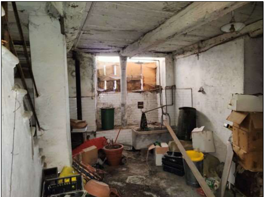
Foto n. 23 – Locale al piano terra del fabbricato Foglio 48 mappale 50
