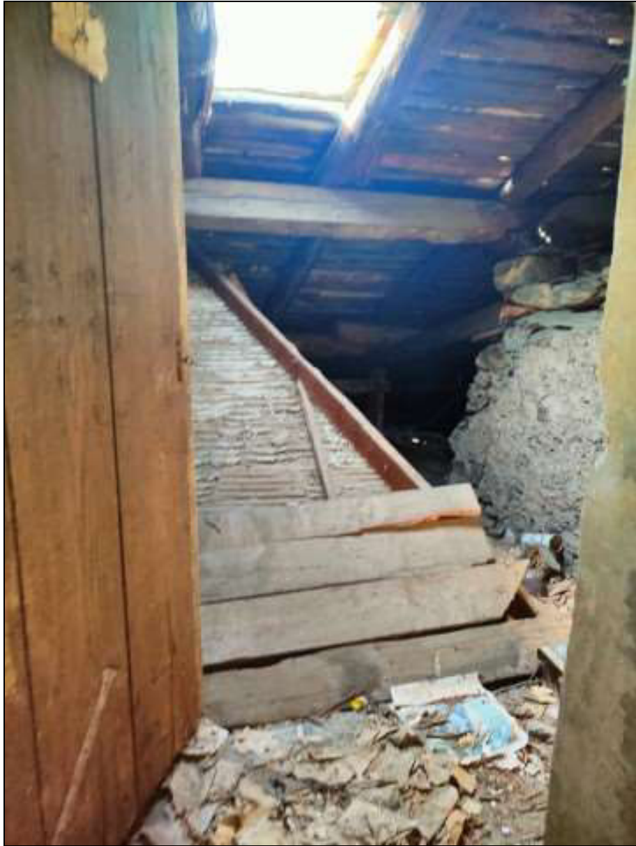
Foto n. 61 – Piano terzo/sottotetto del fabbricato Foglio 48 mappale 50
