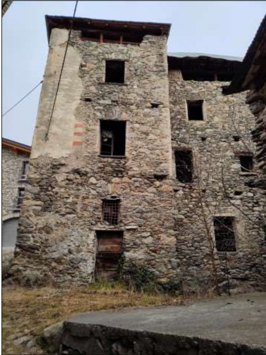
Foto n. 62 – Facciata sud (porzione ovest) del fabbricato Foglio 48 mappale 47, vista da sud
