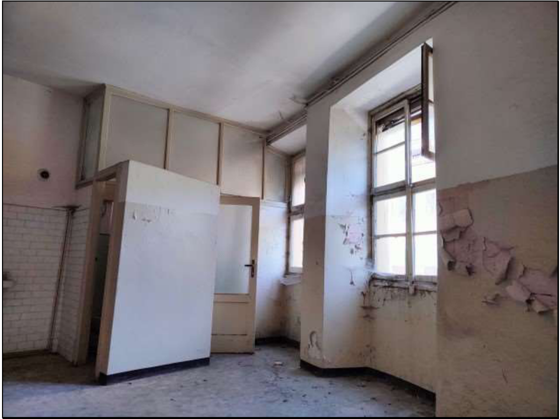
Foto n. 28 – Locale al piano primo del fabbricato Foglio 48 mappale 50
