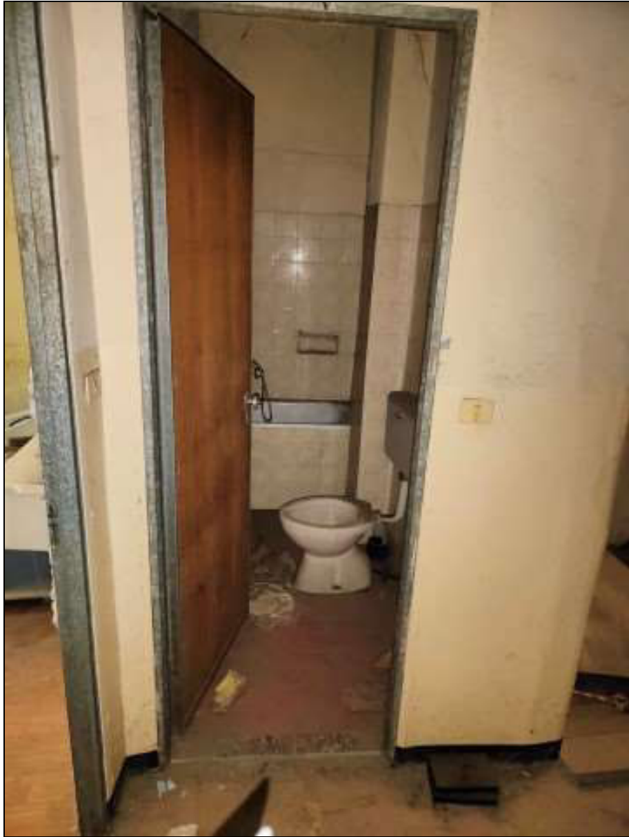
Foto n. 32 – Locale al piano primo del fabbricato Foglio 48 mappale 50
