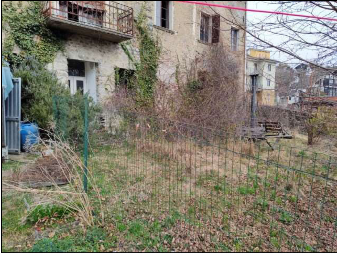
Foto n. 14 – Area di pertinenza del fabbricato Foglio 48 mappale 50, vista da ovest
