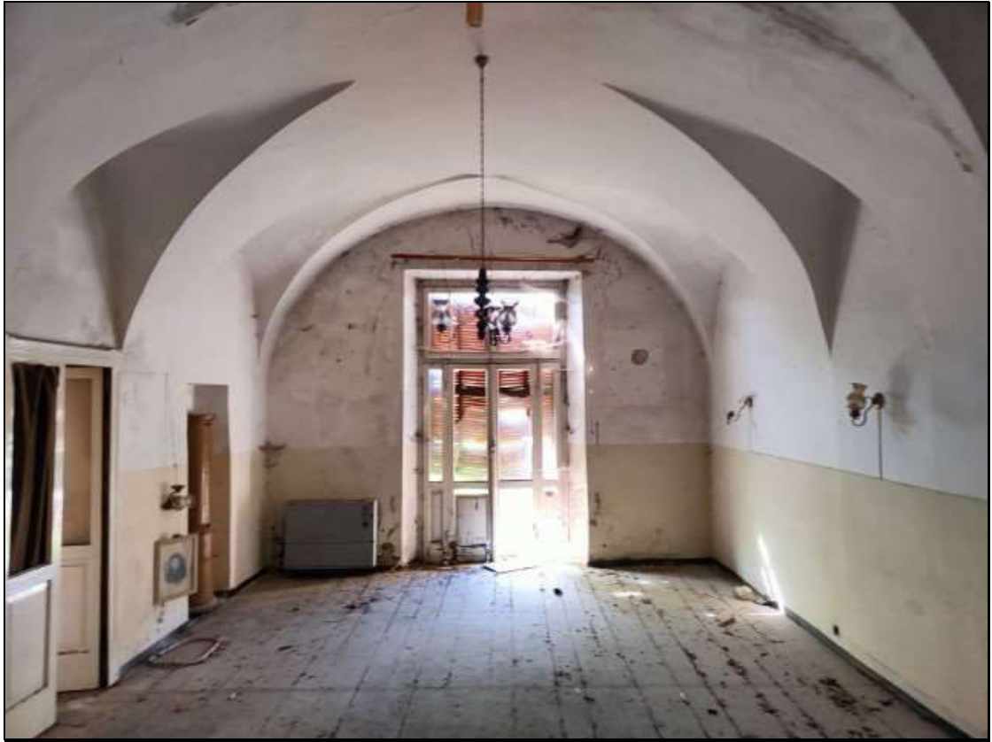
Foto n. 33 – Locale al piano primo del fabbricato Foglio 48 mappale 50
