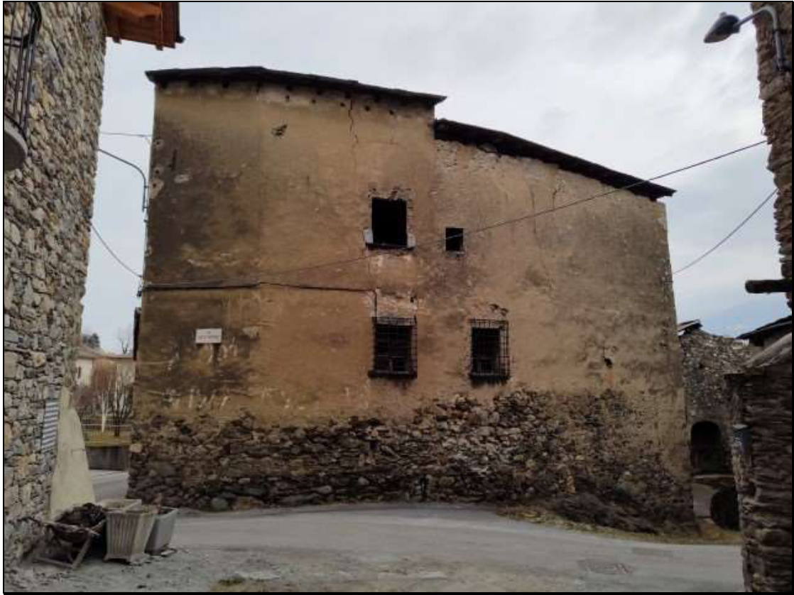
Foto n. 65 – Facciata sud (porzione ovest) del fabbricato Foglio 48 mappale 47, vista da sud
