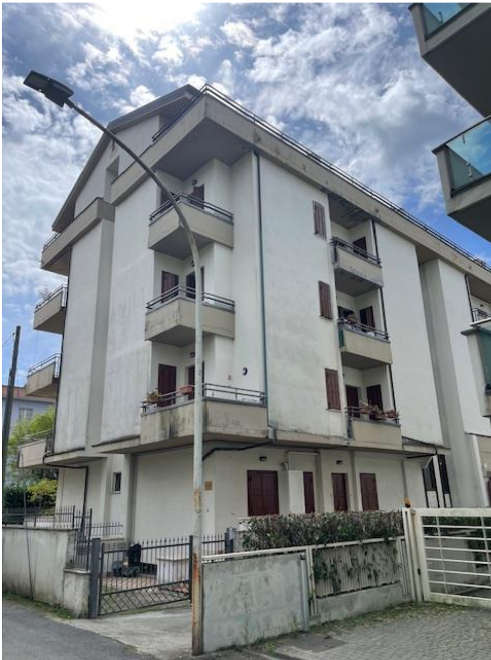
Vista dell'intero fabbricato
