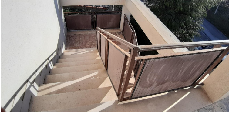
Vano scala accesso piano primo
