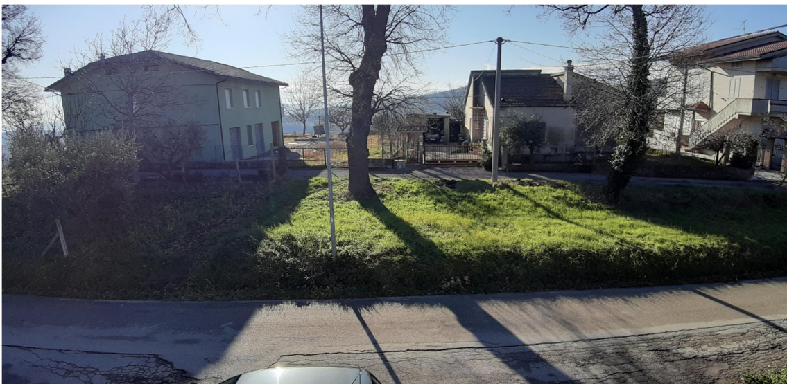
Veduta frontale (lato sud)
