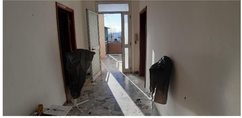
Ingresso piano primo
