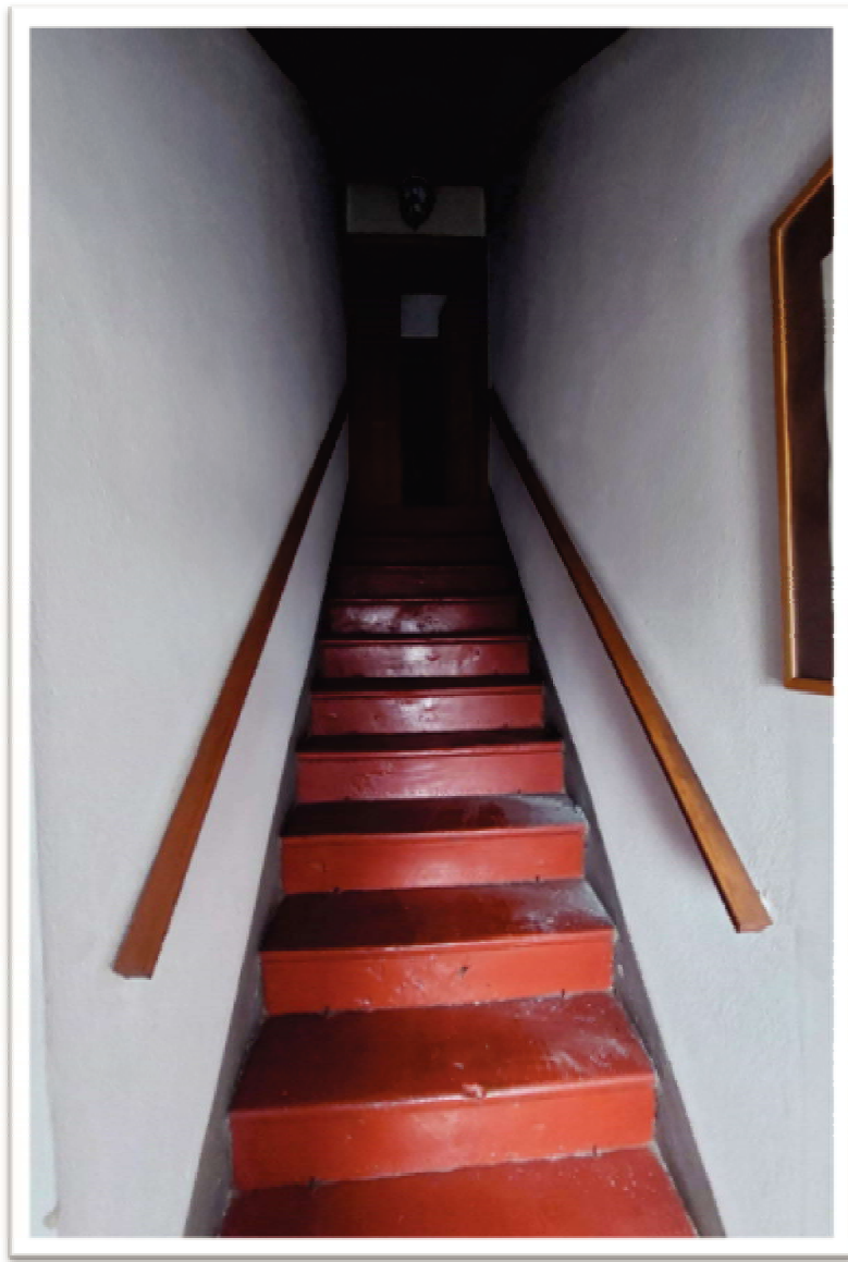
FOTO N. 4 - VANO SCALA DI ACCESSO AL PIANO SECONDO
