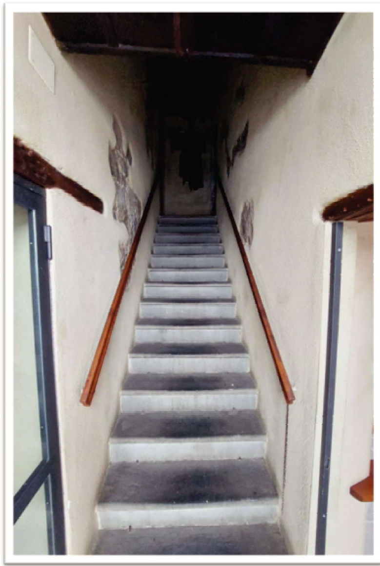
FOTO N. 3 - VANO SCALA A COMUNE
