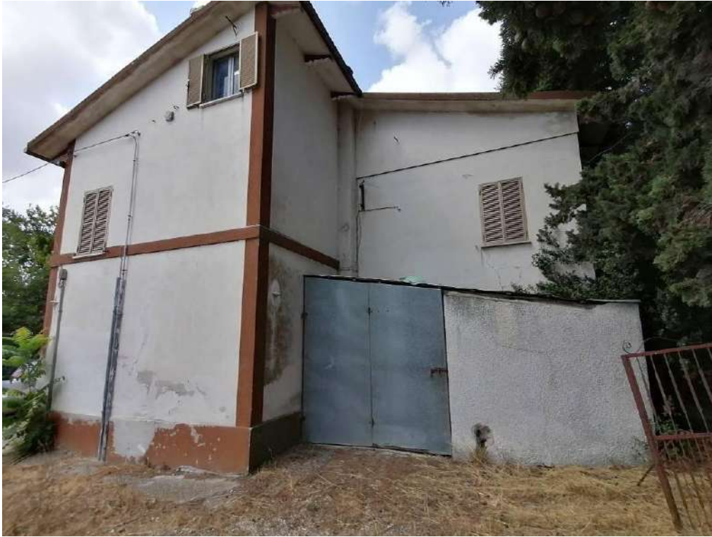
FOTO 31 (Fabbricato Fg. 91, Part. 80, Sub. 2 - vista est)
