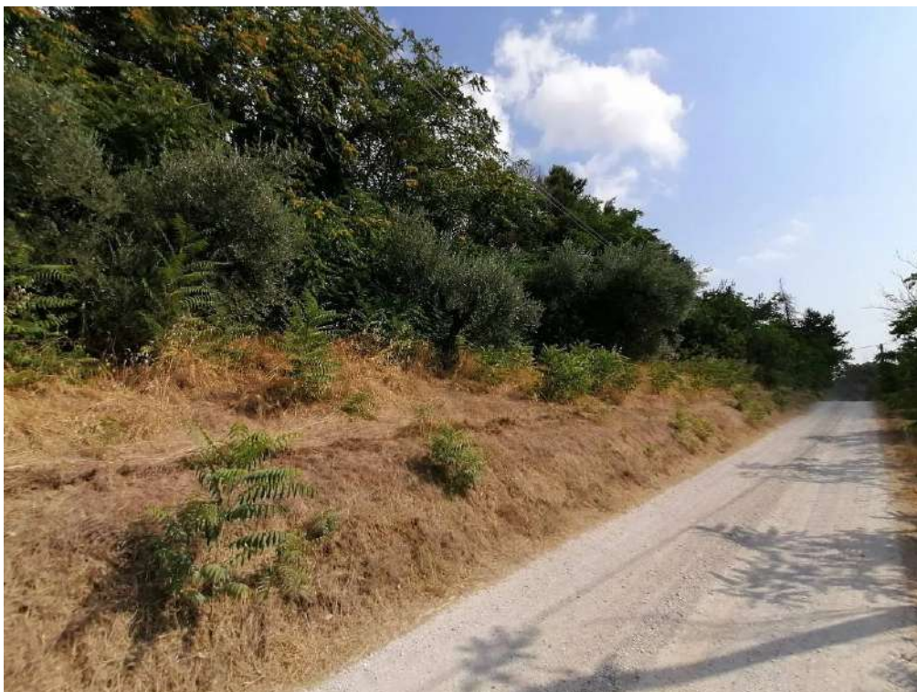
FOTO 54 (versante sud/est – Part. 345)
