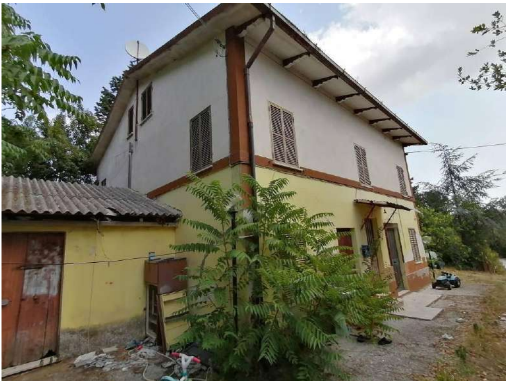
FOTO 32 (Fabbricato Fg. 91, Part. 80, Sub. 2 - vista sud/ovest)
