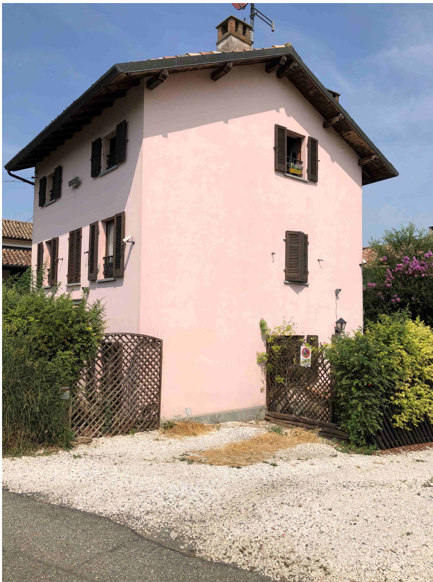
Vista esterno fronte strada e laterale (Sud/Est)
