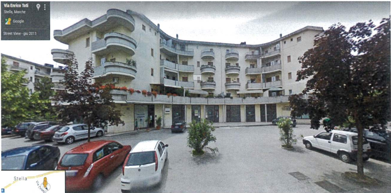
VISTA FABBRICATO FOGLIO 15 PARTICELLA 637
