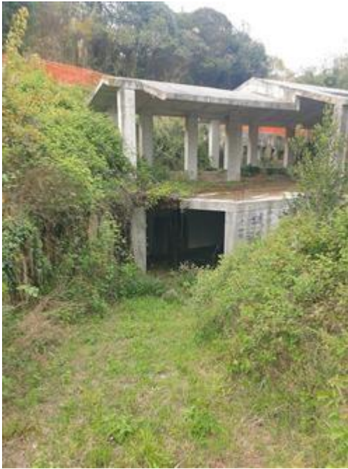
vista ingresso interrato
