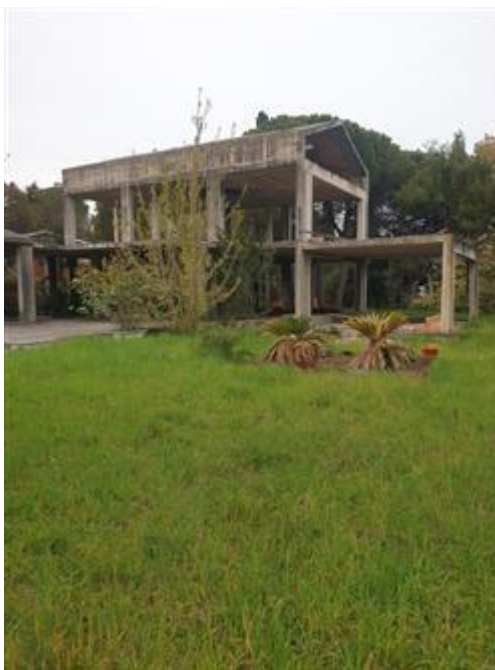
vista corpo di fabbrica
