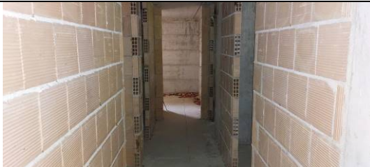
Vista del piano cantinato
