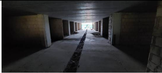
Vista del piano cantinato
