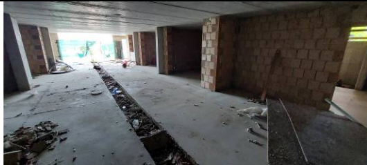
Vista del piano cantinato
