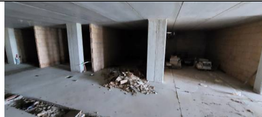
Vista del piano cantinato
