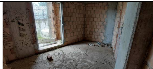
Vista del piano terra
