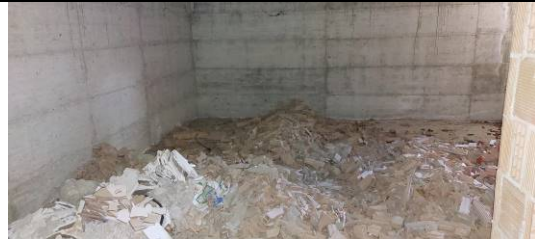
Vista del piano cantinato
