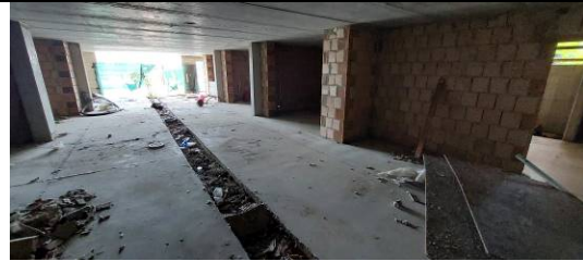
Vista del piano cantinato
