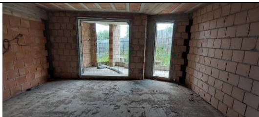
Vista del piano terra
