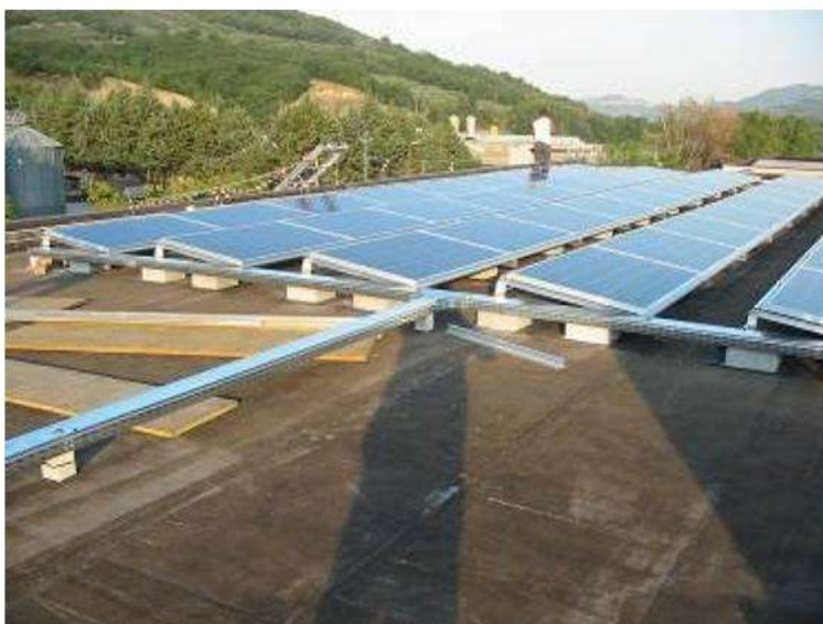
Foto 2 Posa pannelli su copertura piana
