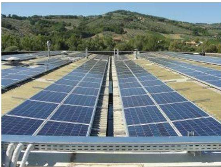
Foto 1. Posa pannelli su copertura in fibrocemento
