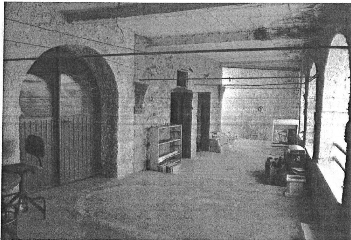
Loggiato al piano S1°
