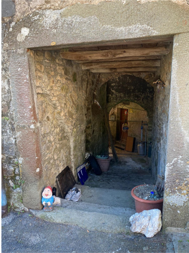
Foto n° 3 – Particolare del volto su Via Maestra che conduce al piano seminterrato
