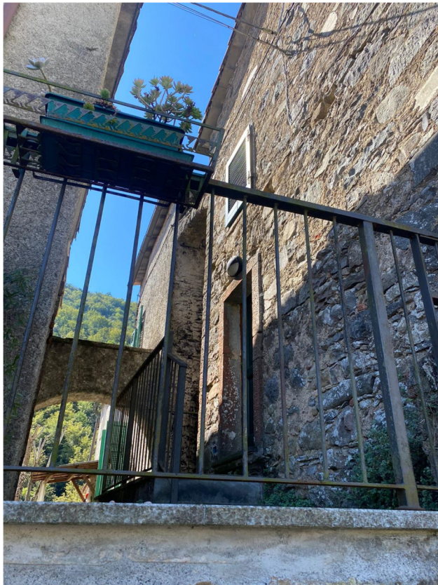
Foto n° 6 – Vista del prospetto est sul mapp. 547 (distacco fra fabbricati)
