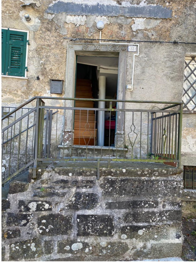
Foto n. 5 - Particolare dell'accesso all'abitazione a piano rialzato
