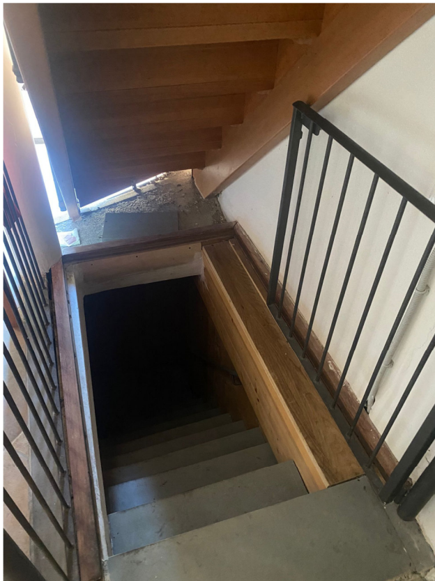
Foto n° 8 – Particolare della scala di collegamento con il piano seminterrato
