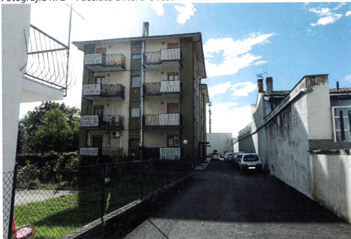
Fotografia n. 2 – Facciata a Nord-Ovest
