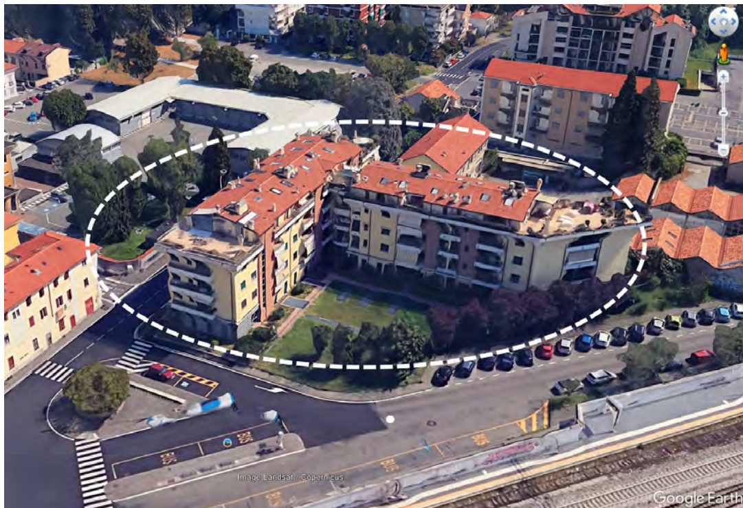
Fotografia n° 1 - Complesso residenziale di Via F.lli Bandiera angolo via Sciesa
