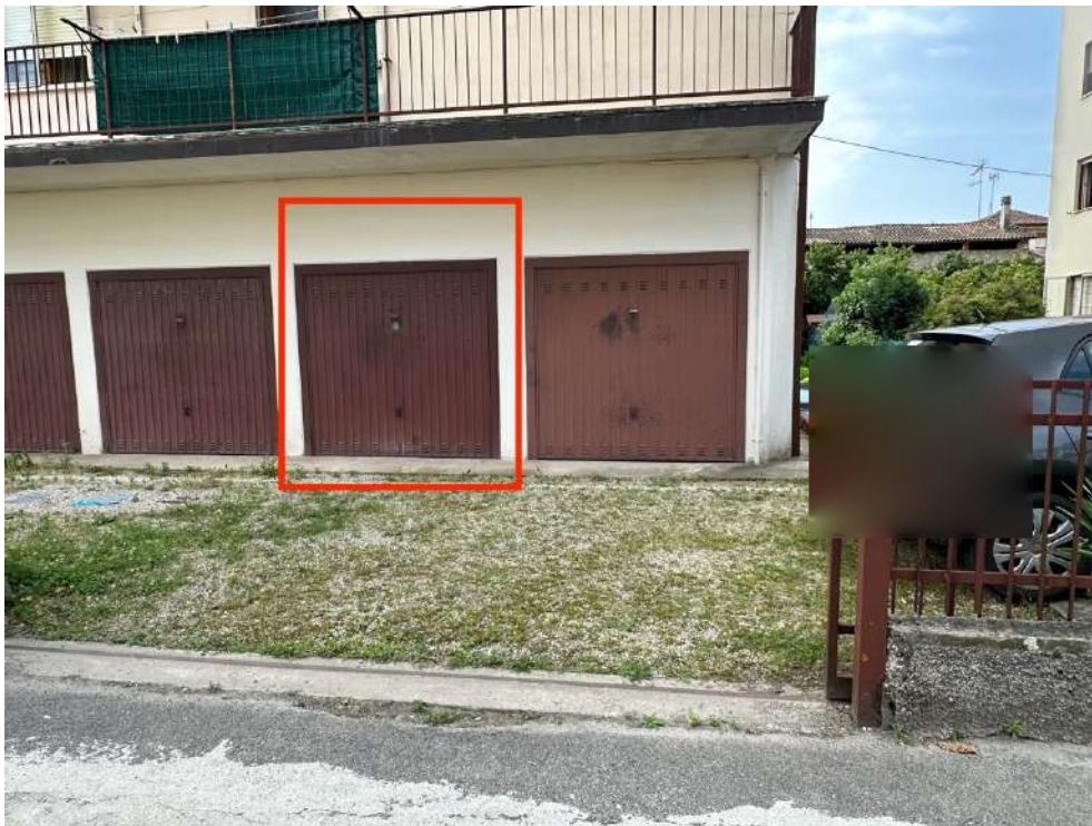
Lato nord (garage).
