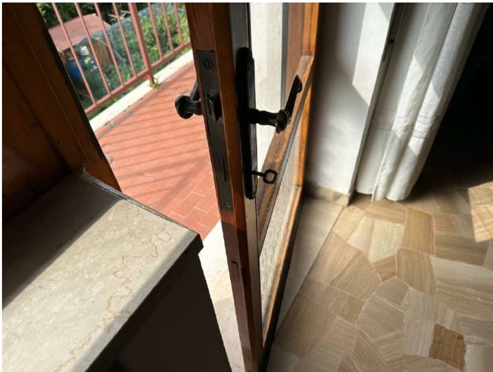
Dettaglio serramento e poggiolo.
