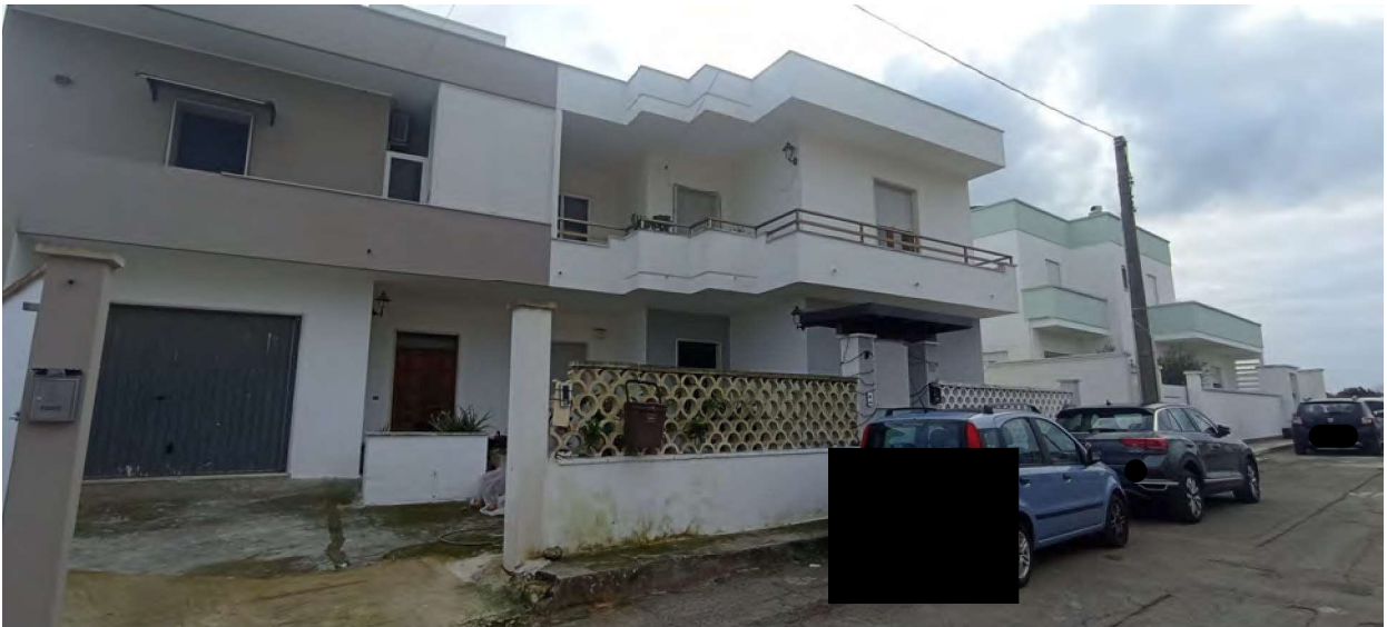
Foto 4- INGRESSO VIA Vincenzo Monti n.26/A
