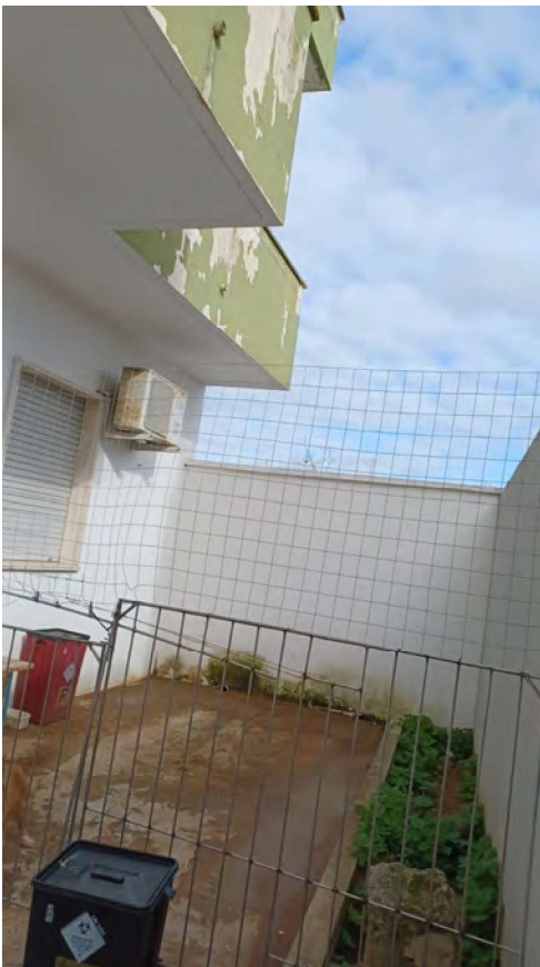
Foto 8 - esterno lato posteriore
