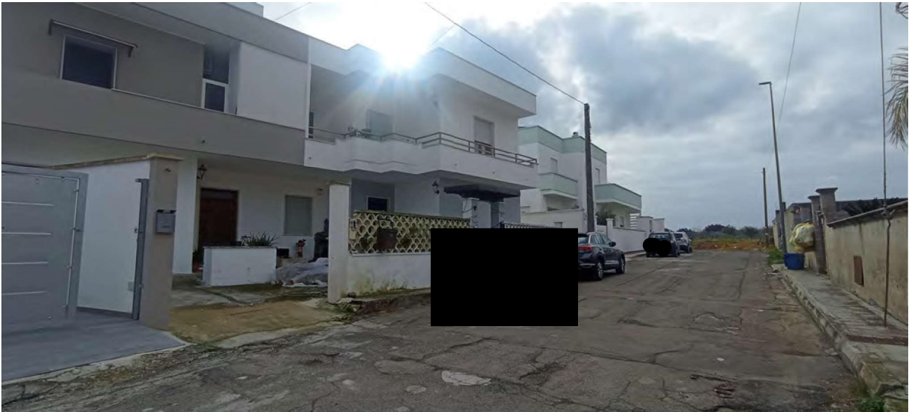
Foto1- INGRESSO VIA Vincenzo Monti n.26/A
