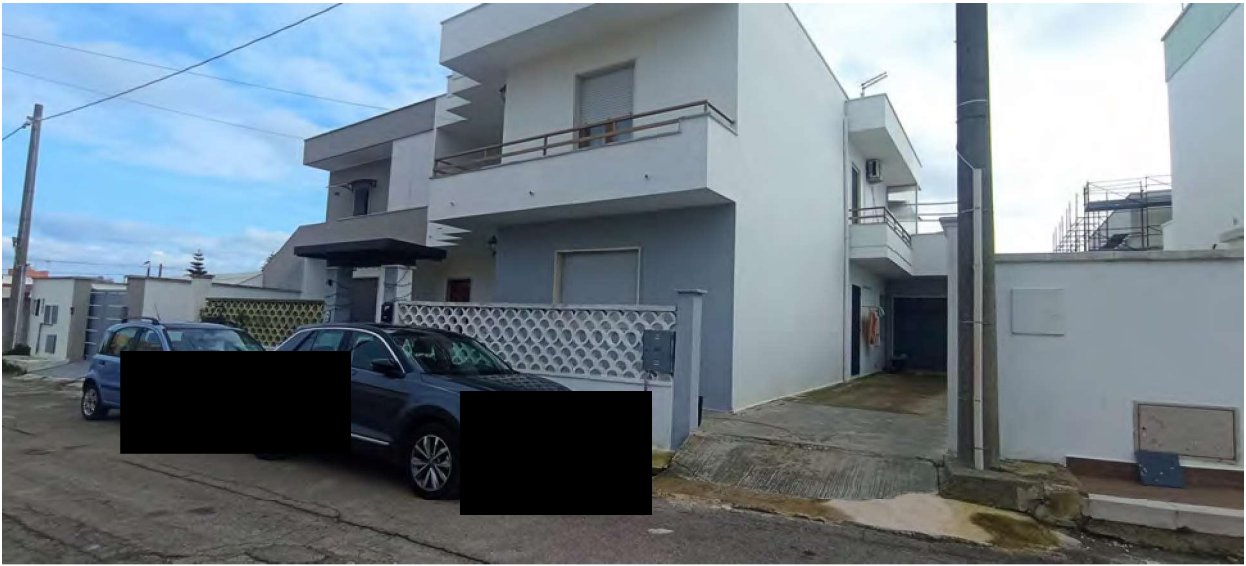
Foto 3- INGRESSO VIA Vincenzo Monti n.26/A
