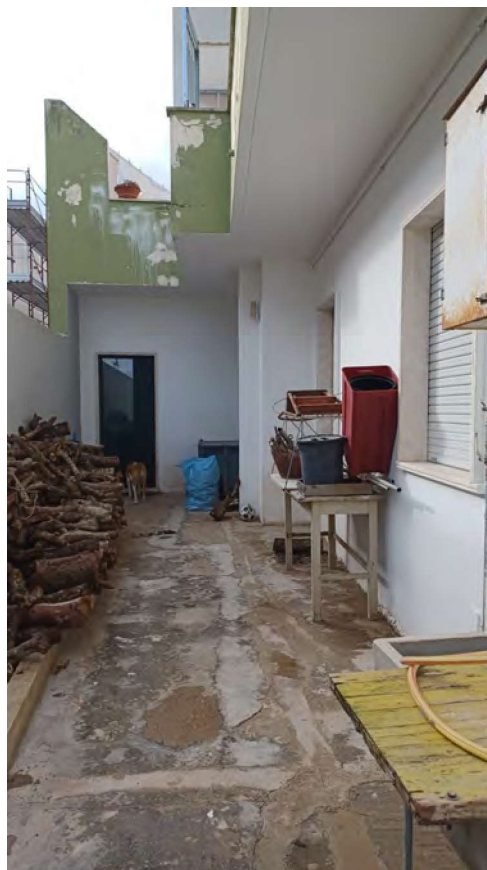
Foto 9 - esterno lato posteriore
