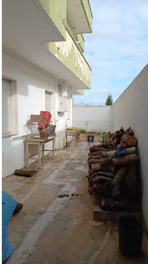
Foto 7 - esterno lato posteriore
