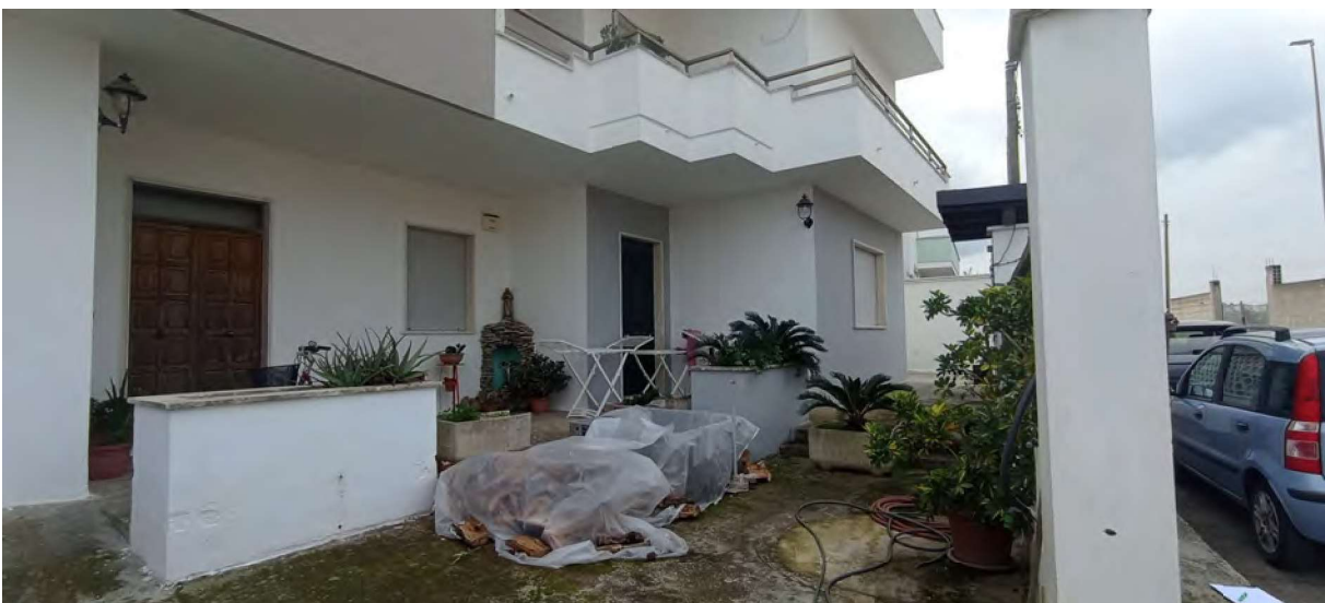
Foto 5 - INGRESSO VIA Vincenzo Monti n.26/A
