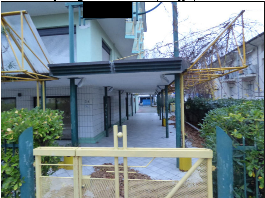
Fotografia 5_ Vista della corte e del passaggio pedonale.
