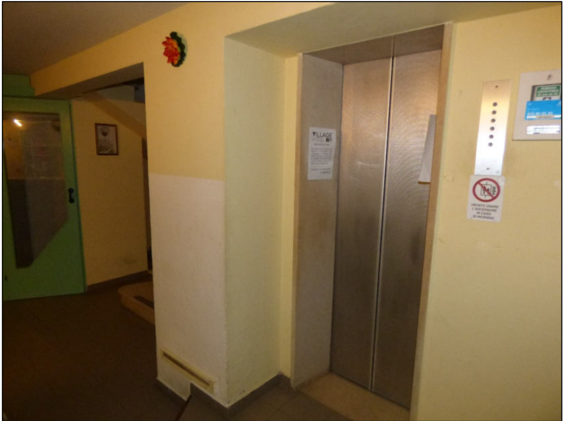
Fotografia 10_Vista del vano ascensore.
