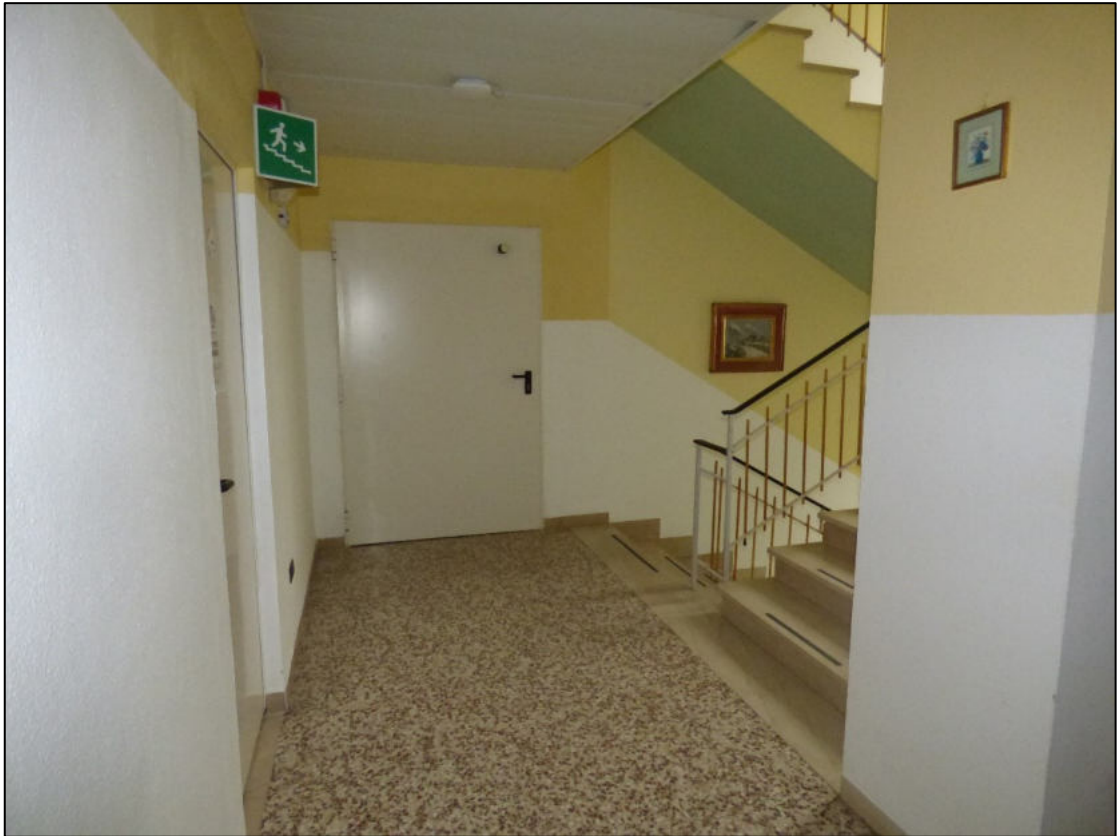
Fotografia 22_Vista del disimpegno di collegamento ai piani tipo.
