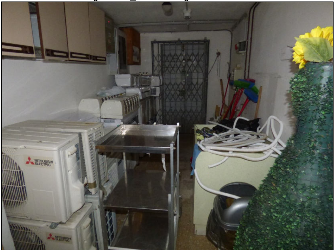
Fotografia 15_ Vista dell'ingresso di servizio.
