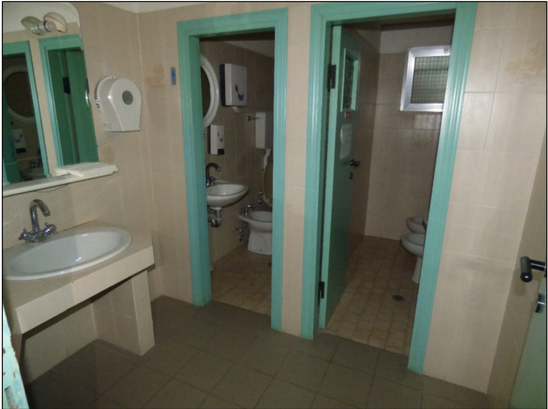
Fotografia 12_ Vista del bagno.
