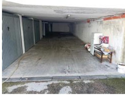
La rampa/corsia (condominiale) per l'accesso alle autorimesse
