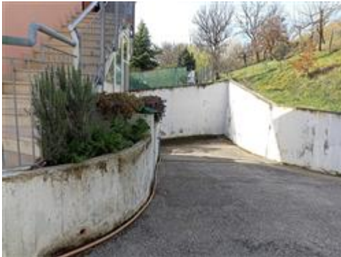
La rampa/corsia (condominiale) per l'accesso alle autorimesse
