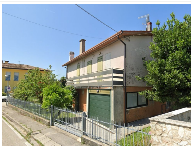
Vista sud-est, con accesso carraio al garage
