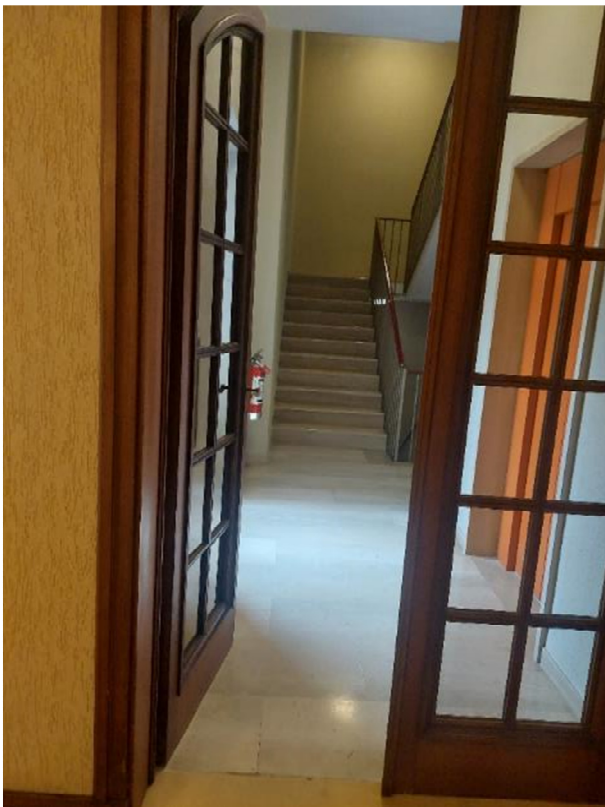
FOTO 24,25: porta di accesso al vano scala e vano scala
