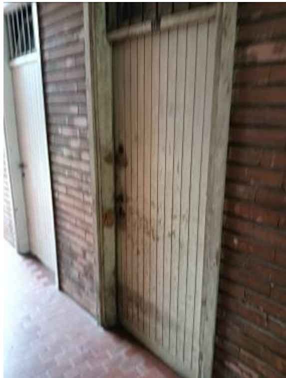
FOTO 12 – ingresso cantina a piano terra
