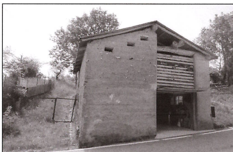
vista deposito dalla strada
