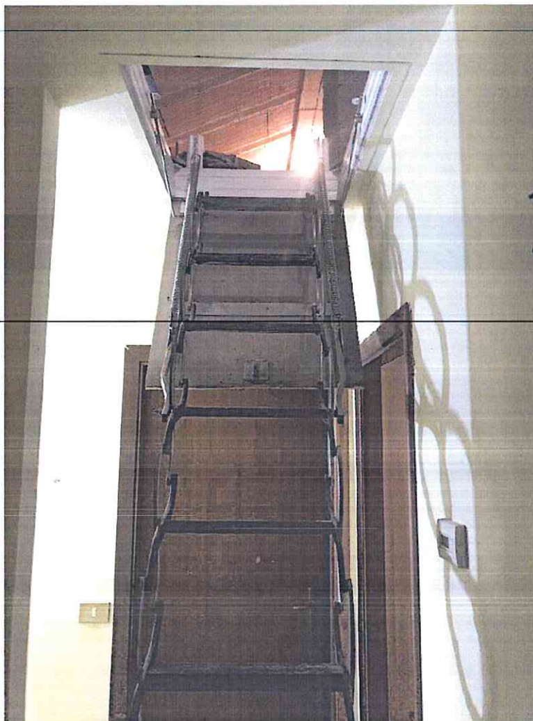
Foto 22 – Foto interna – piano secondo botola con scala retrattile per accesso alla soffitta sopra la porzione alta del fabbricato
