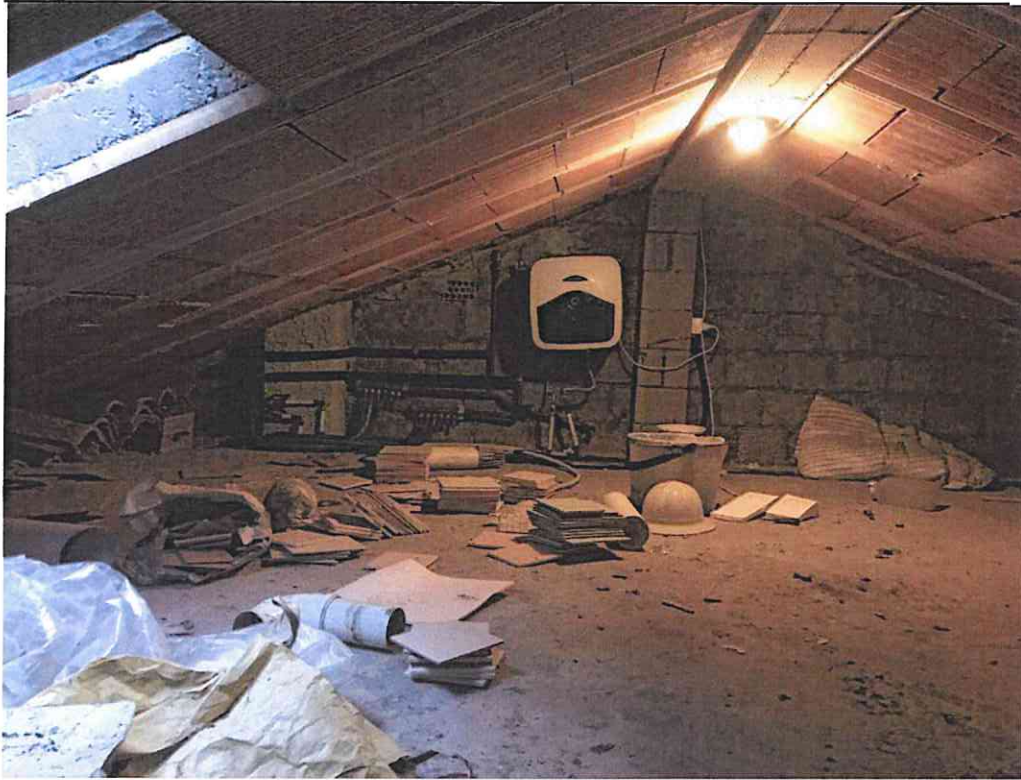
Foto 23 – Foto interna – piano soffitta sopra il piano secondo accessibile tramite scala retrattile dal disimpegno; nel vano è presente il boiler elettrico per la produzione dell'acqua calda oltre alla botola di accesso alla copertura
