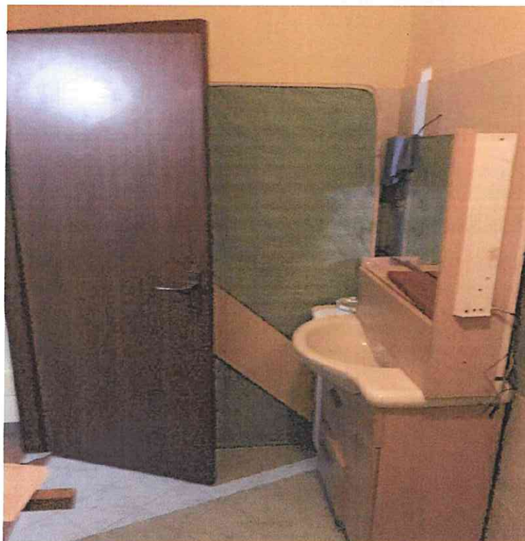
Foto 21 – Foto interna restante porzione del bagno piano secondo lato sud accessibile dalla camera
