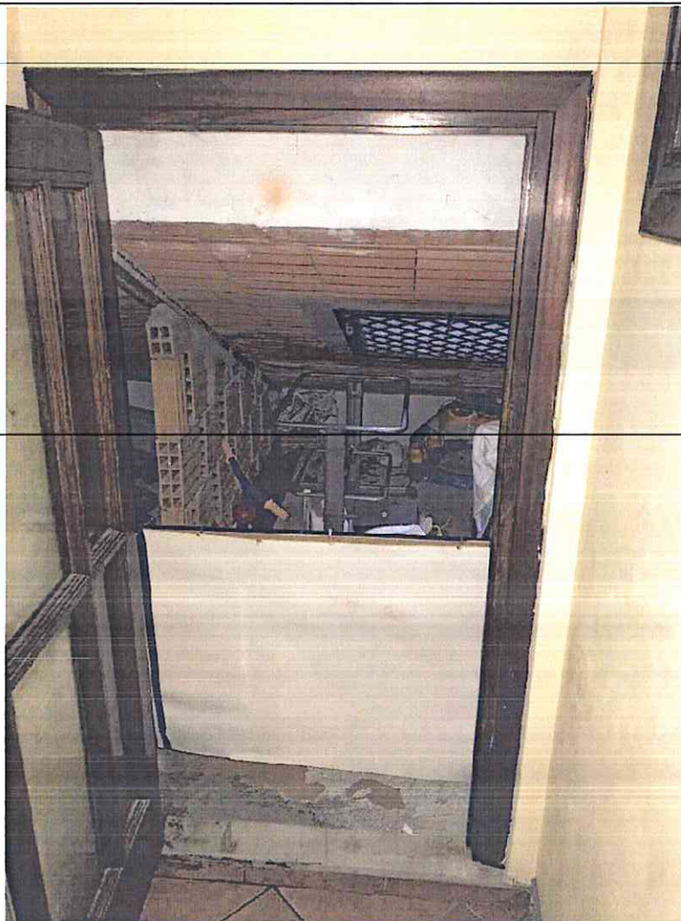
Foto 24 – Foto interna – porta interna nel disimpegno del piano secondo di accesso ad una soffitta della porzione di fabbricato più bassa esposta ad est
