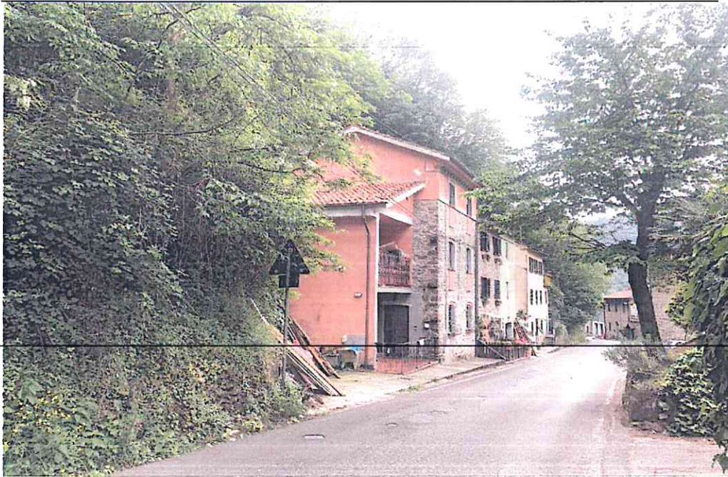
Foto 1 – Lato Nord-Est - Vista dalla Via per Pieve di Brancoli
