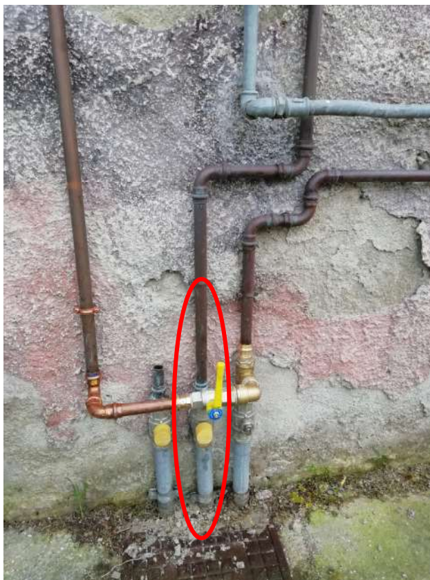
P.V.F. 25 – Allaccio metano, contatore rimosso
