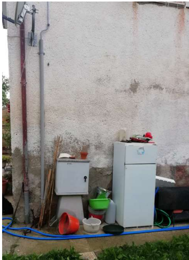
P.V.F. 24 – Cassetta esterna con contatore Enel
