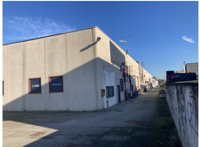
Vista angolo sud-ovest
