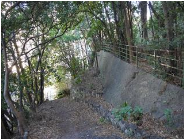
Percordo pedonale in ascendere verso villa Cabrini
