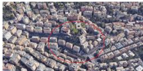
VISTA GENERALE COMPLESSO
