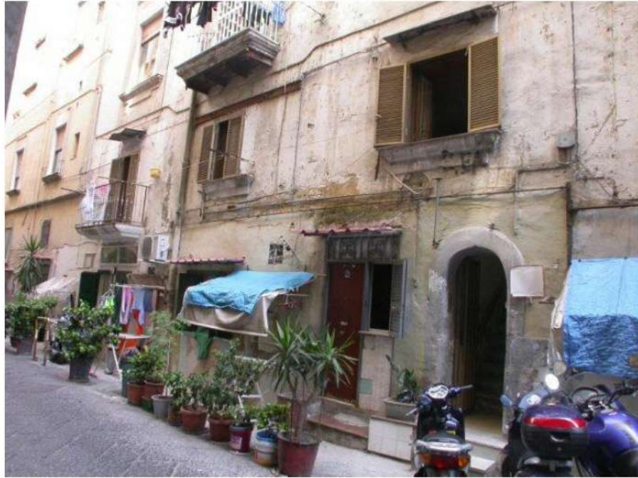
Foto n° 3 e 4 - via del Priorato – Ingresso al civico n° 6
