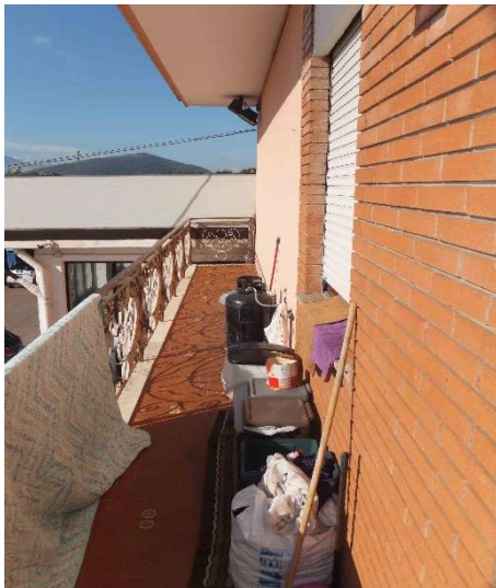
Foto 21, esterno P.1, balcone.
