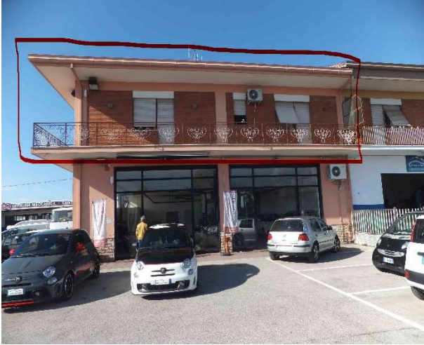
E.I. 73/2023. Foto 01, esterno fabbricato.
