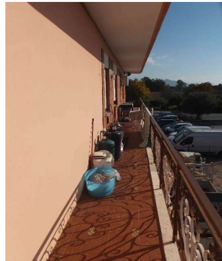
Foto 22, esterno P.1, balcone.
