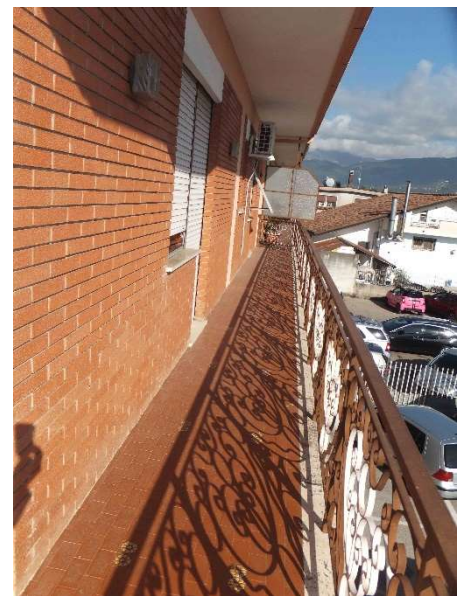
Foto 24, esterno P.1, balcone.
