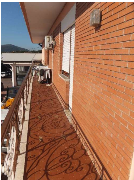
Foto 23, esterno P.1, balcone.
