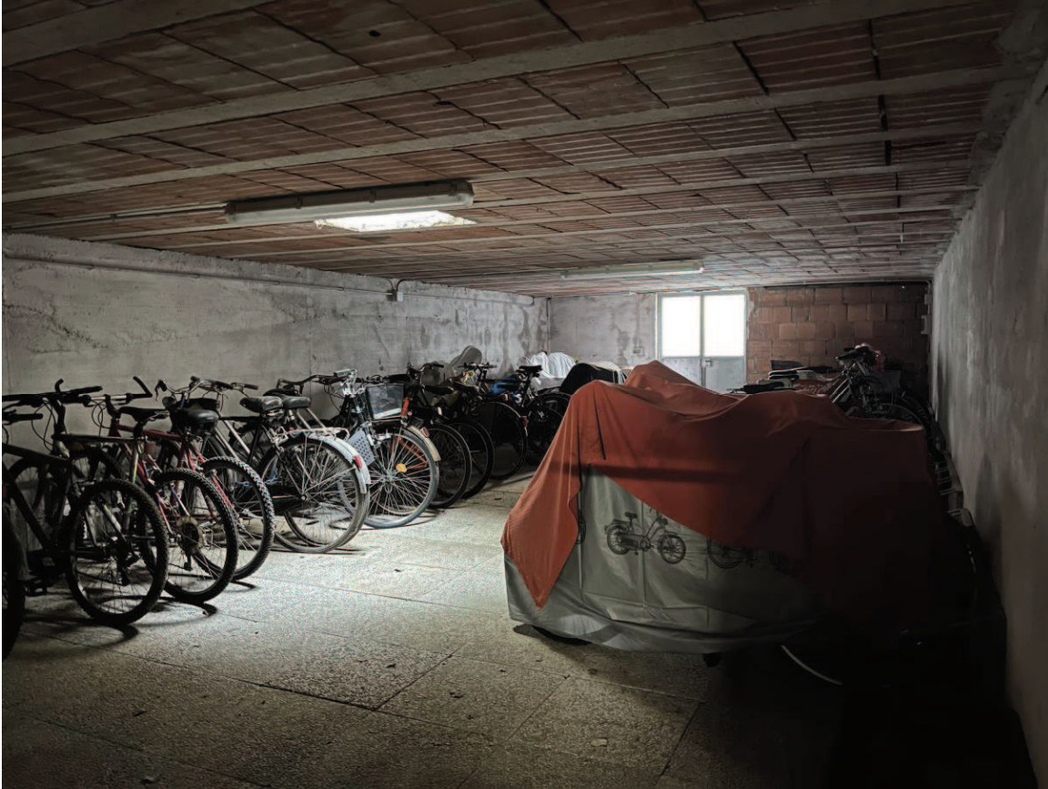
Foto 71 - magazzino in comproprietà
