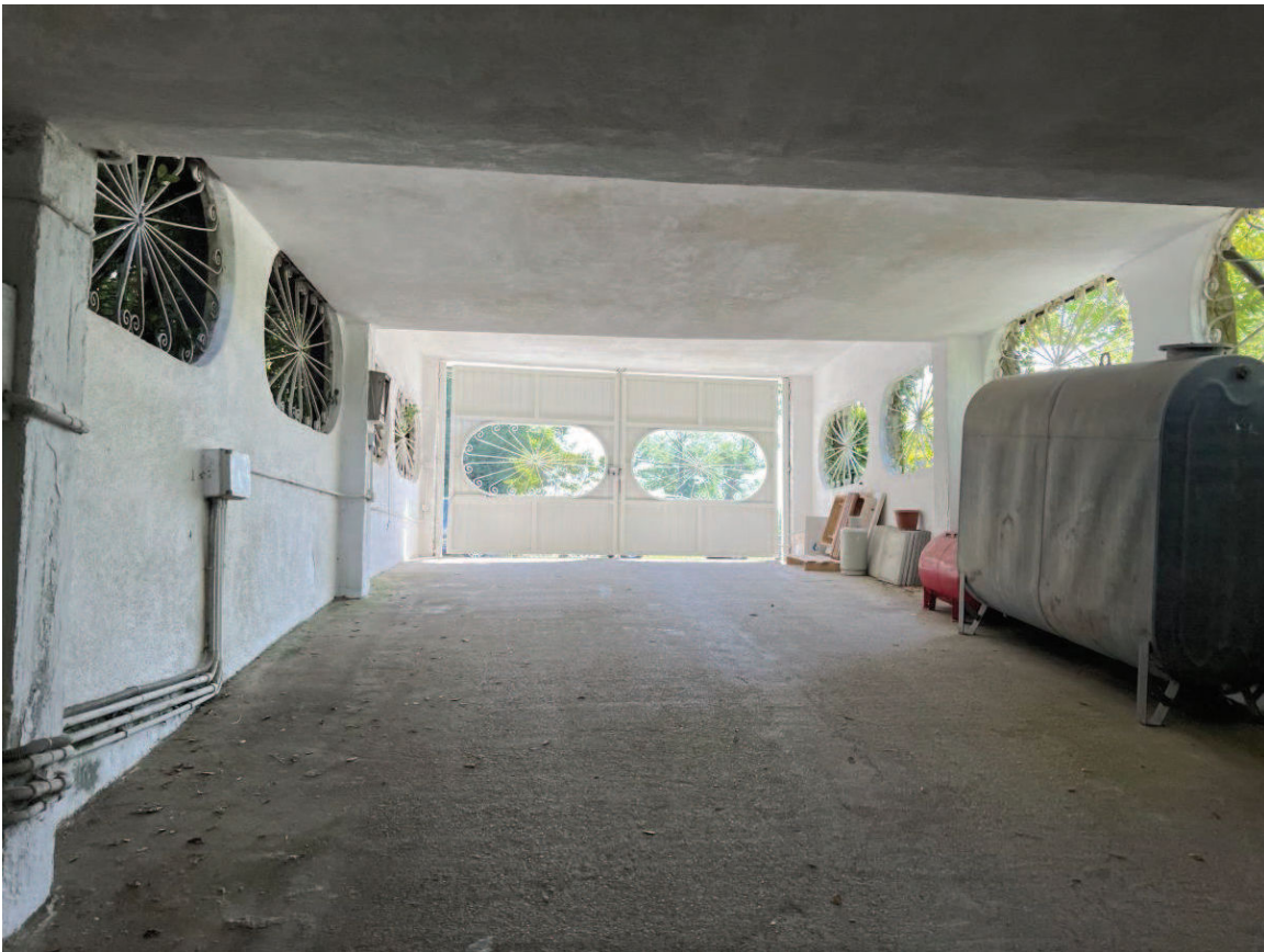
Foto 72 - rampa di accesso all'interrato
