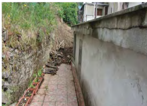
Percorso pavimentato di accesso
