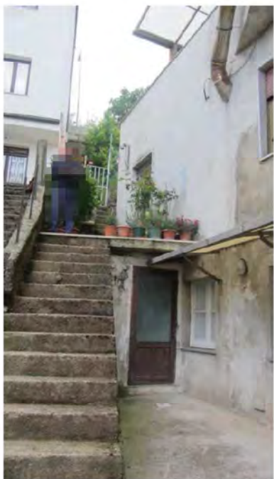
Seconda rampa di accesso scala esterna
