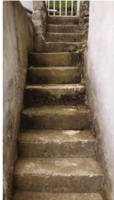
Terza rampa di accesso
