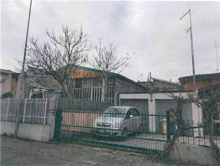
vista esterna da via Meucci
